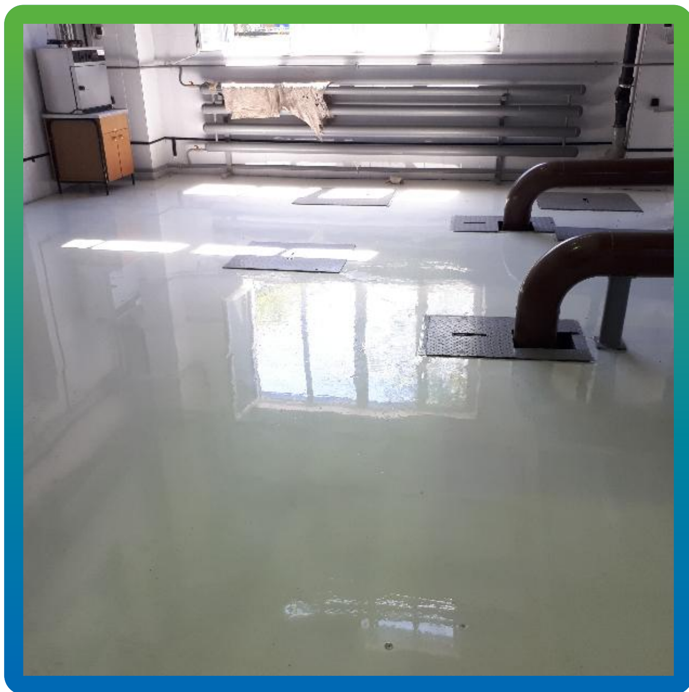
Вид финишного покрытия
