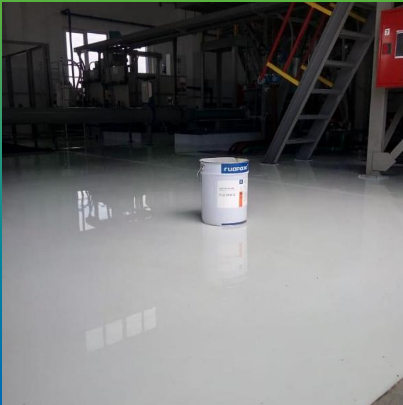
Вид финишного эпоксидного покрытия ДенСтол ЭП 500
