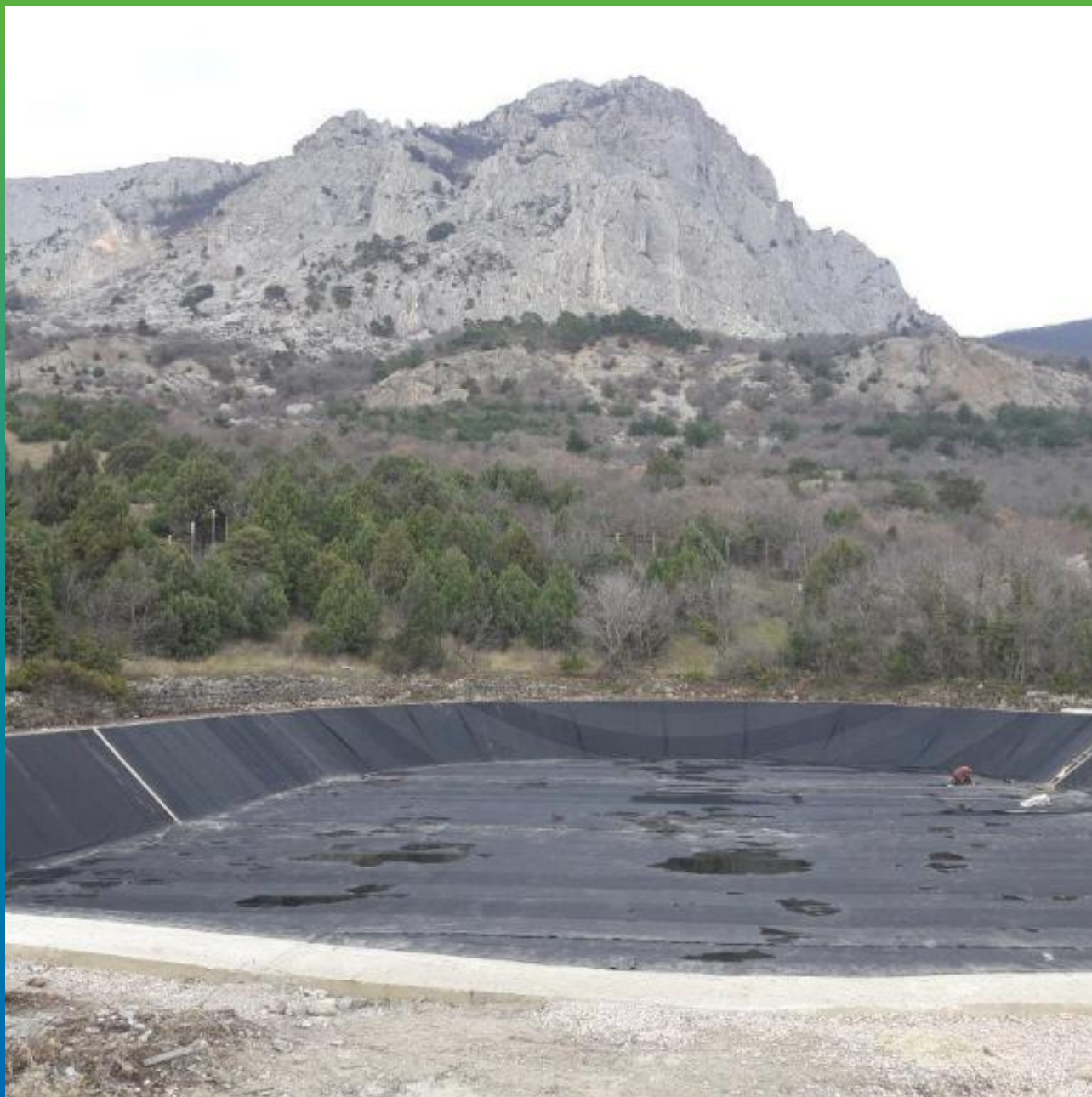
Вид готового объекта
