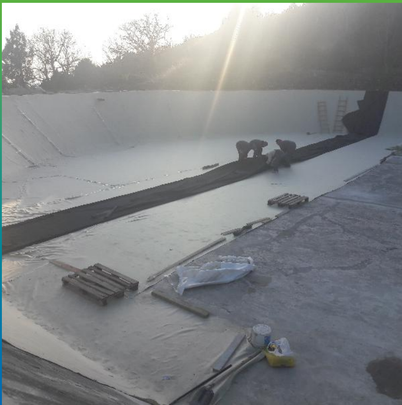
Процесс укладки ЭПДМ мембраны поверх геотекстиля
