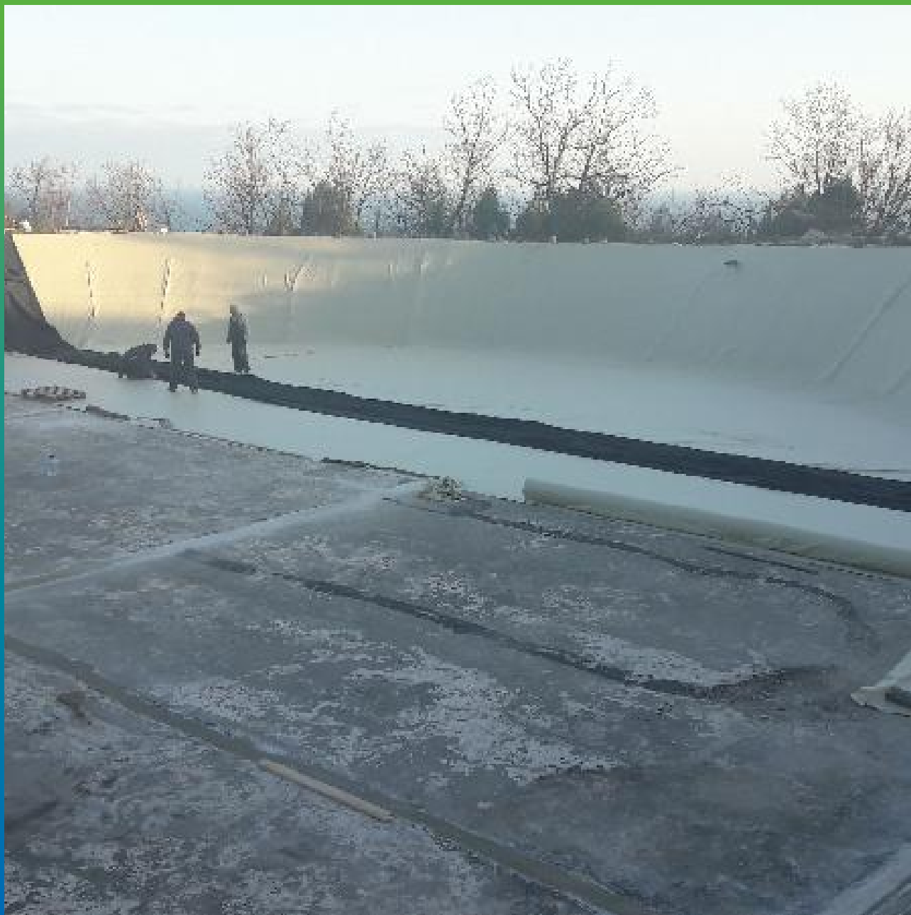
Процесс укладки ЭПДМ мембраны поверх геотекстиля
