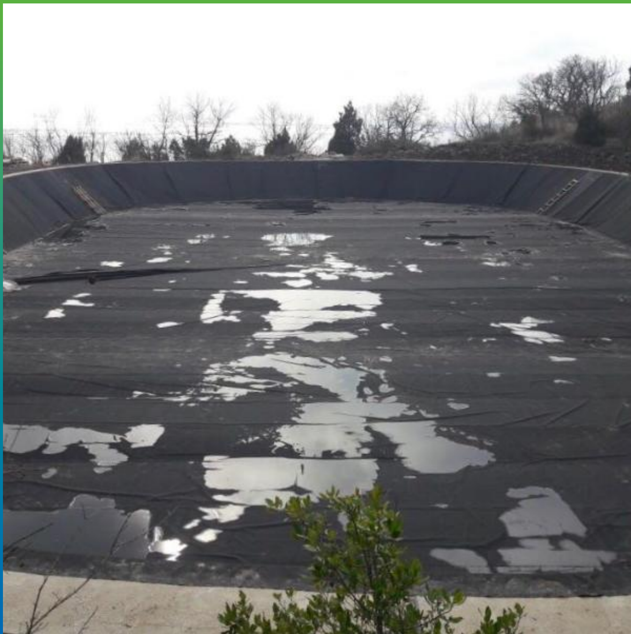
Вид готового объекта
