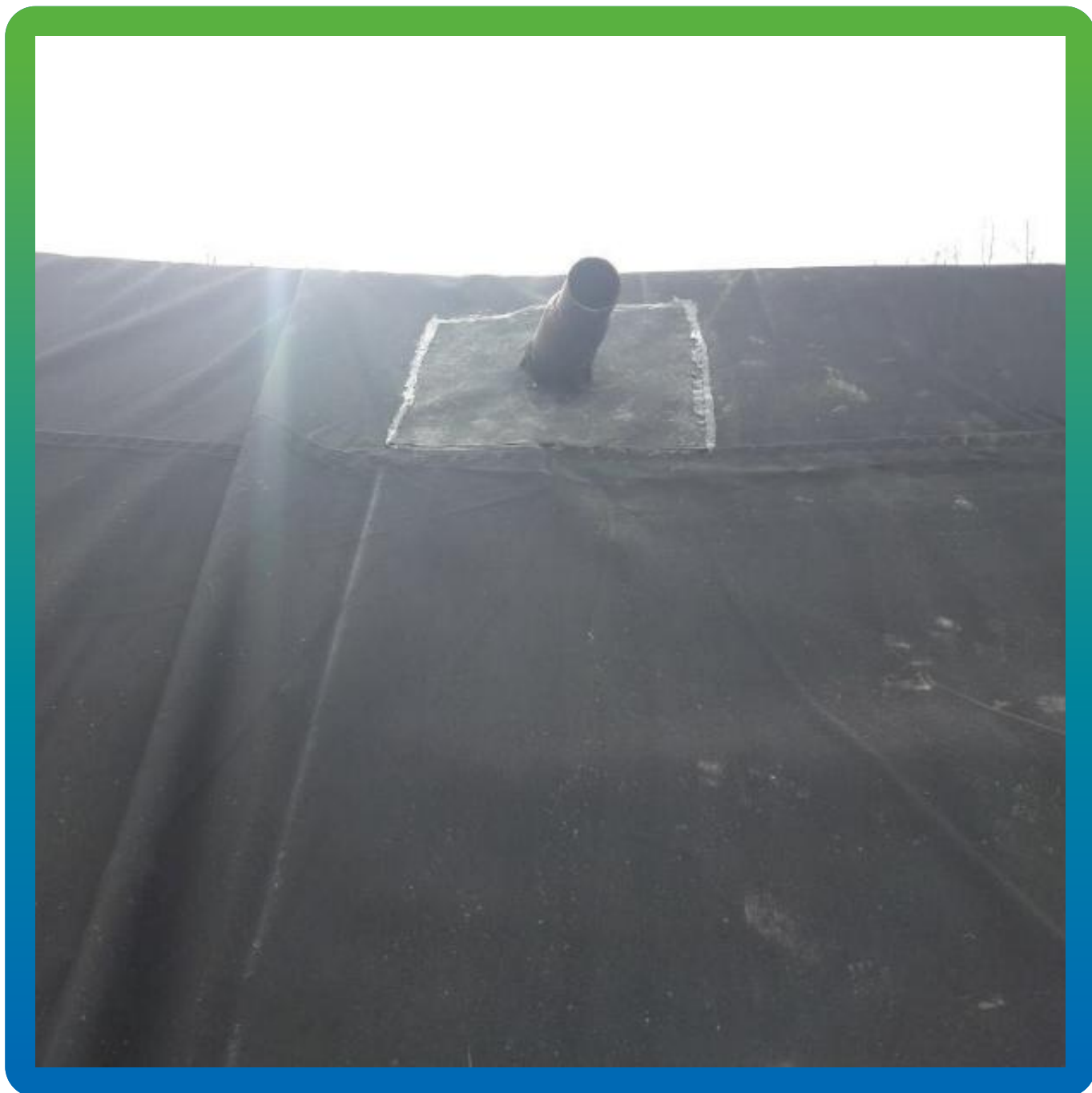
Загерметизированный ввод коммуникаций
