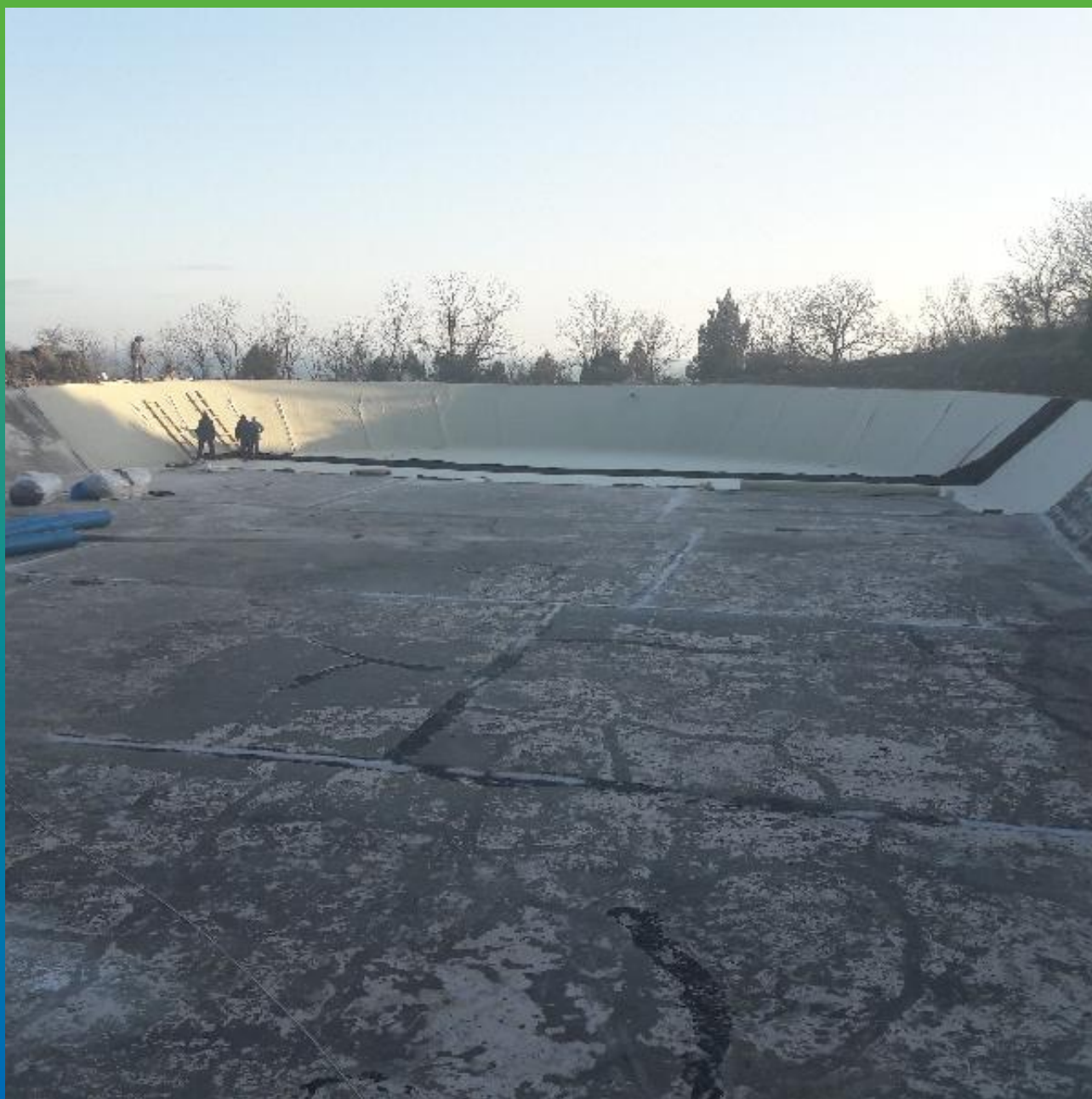
Начало укладки мембраны
