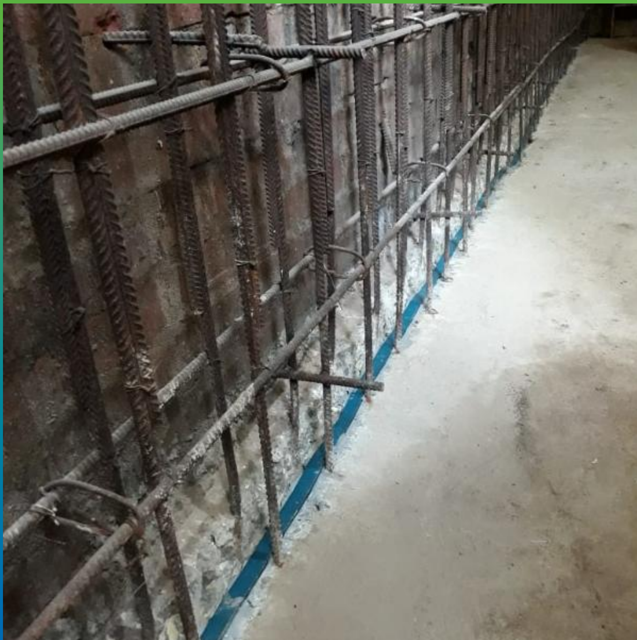
Установленный шнур Манодил Свелл ХК 2507 на набухающий герметик Манодил Свелл 1К
