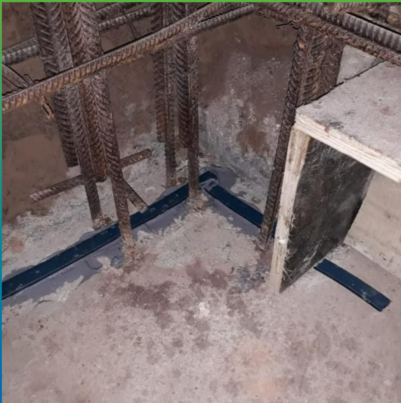
Монтаж гидрофильного шнура Манодил Свелл ХК 2507 на углу
