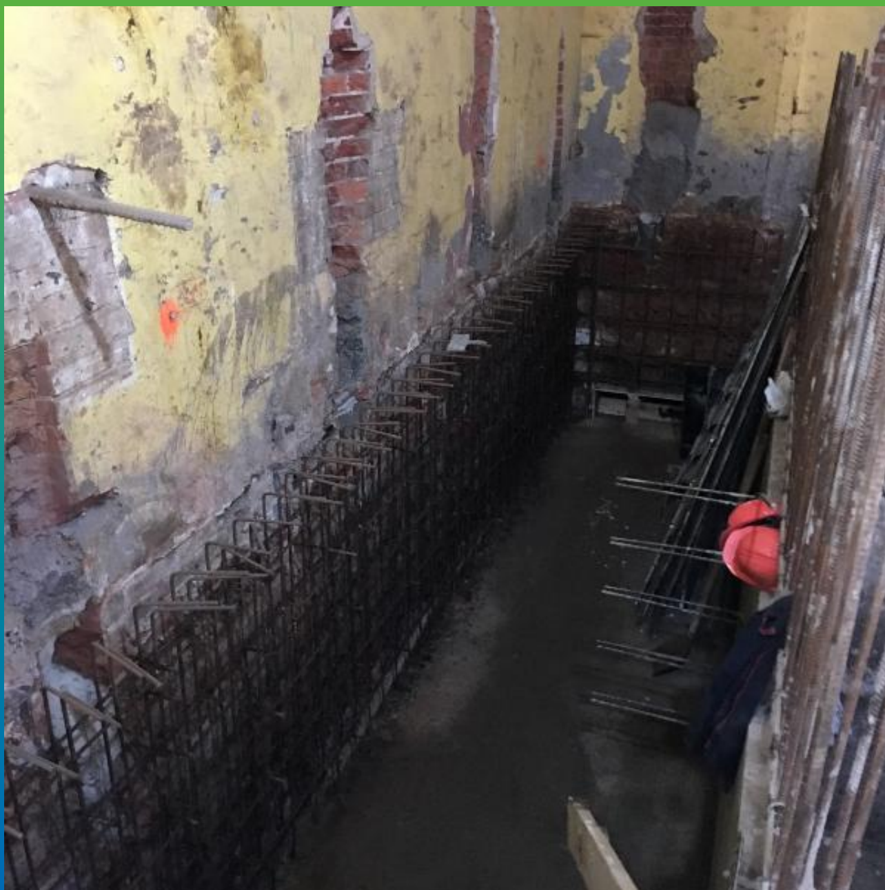
Вид объекта изнутри
