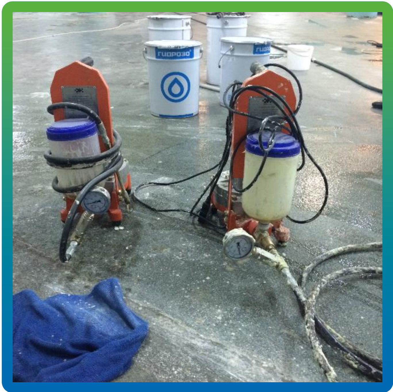
Подготовка к инъектированию
