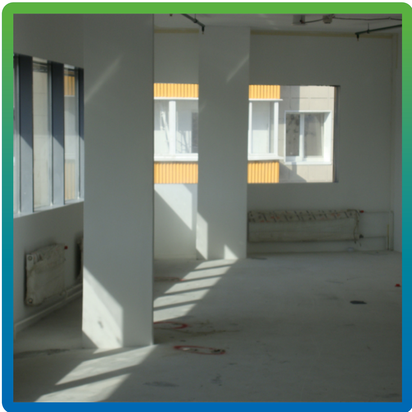
Вид объекта изнутри
