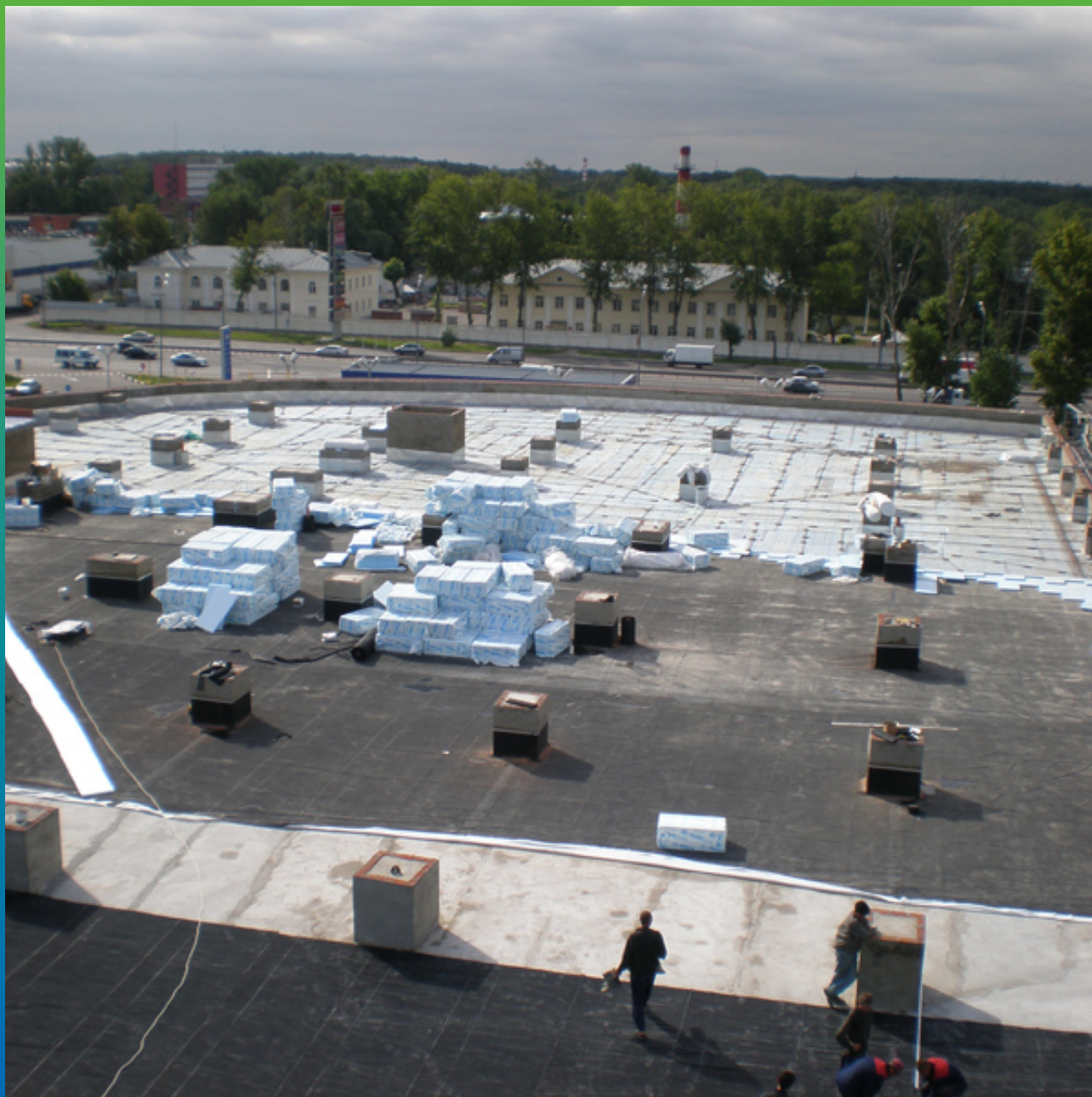
Монтаж утеплителя поверх мембраны
