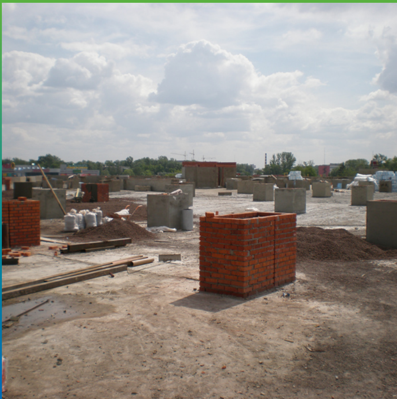
Основание эксплуатируемой части
