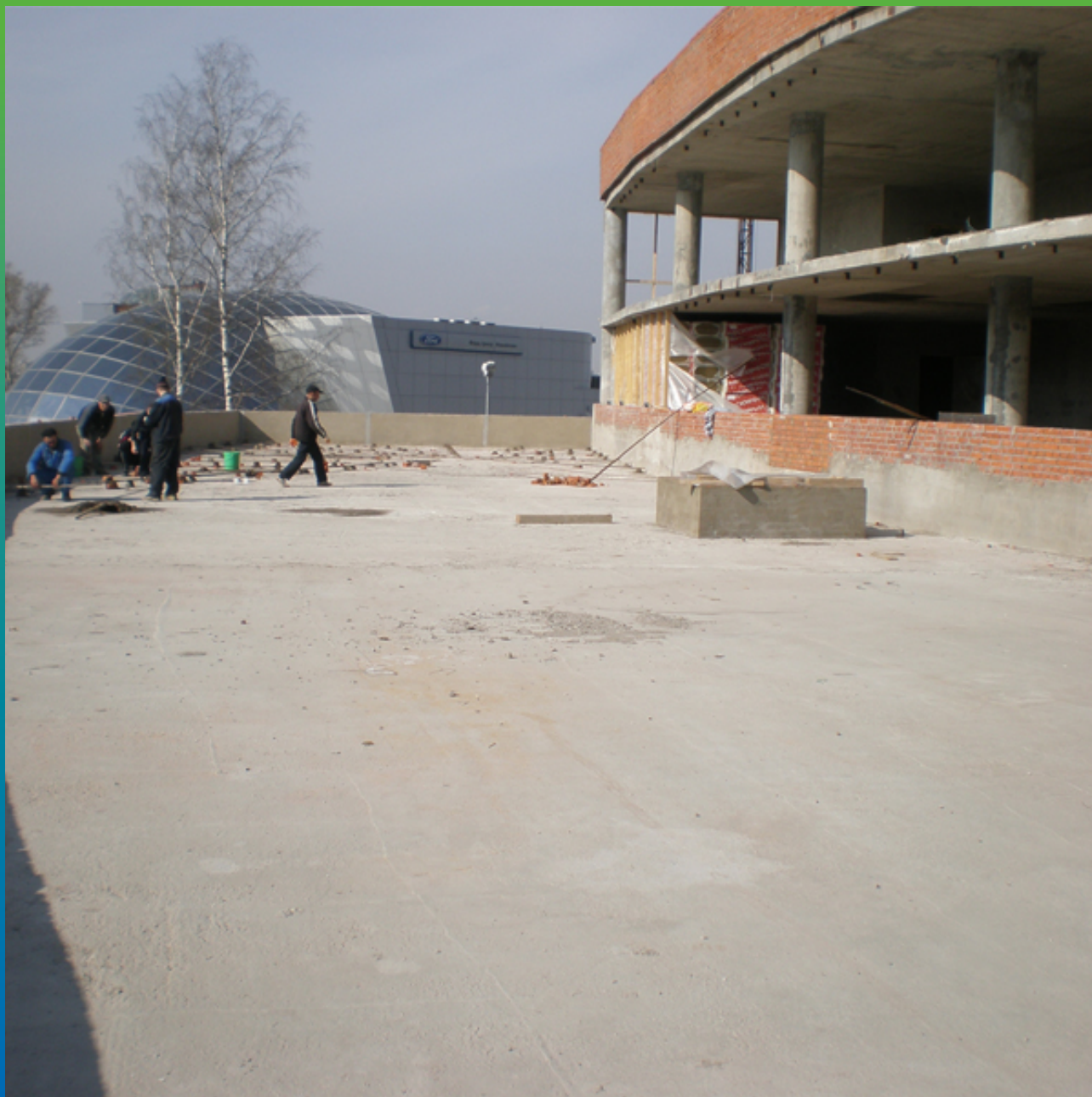
Общий вид объекта перед началом работ
