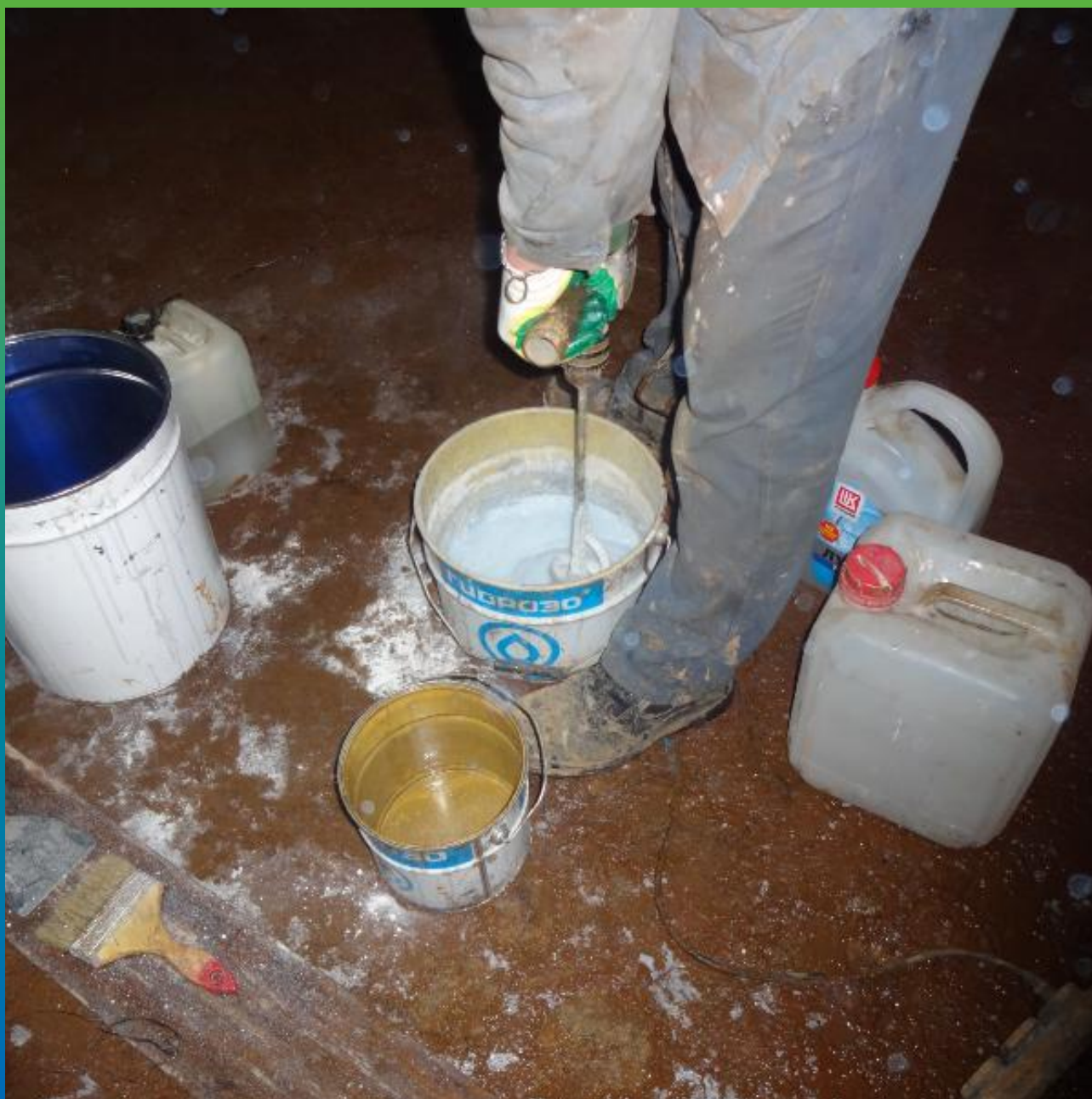
Загущение клея Манопокс 372 составом Манопокс Тикс
