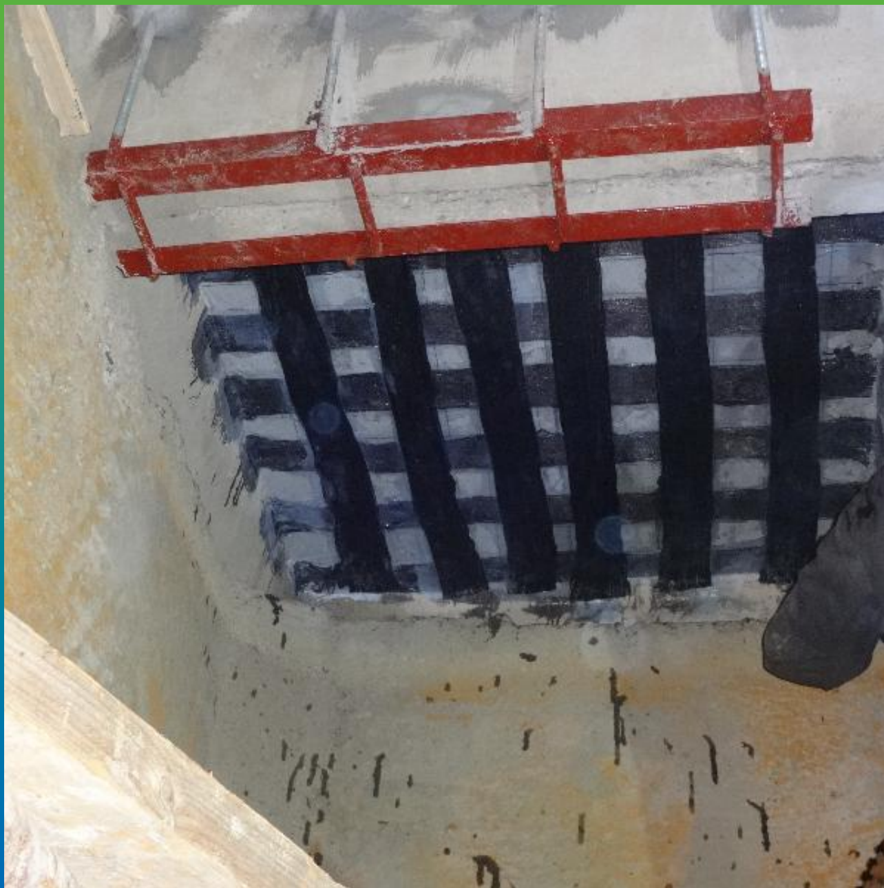
Вид смонтированного участка системой ФАП
