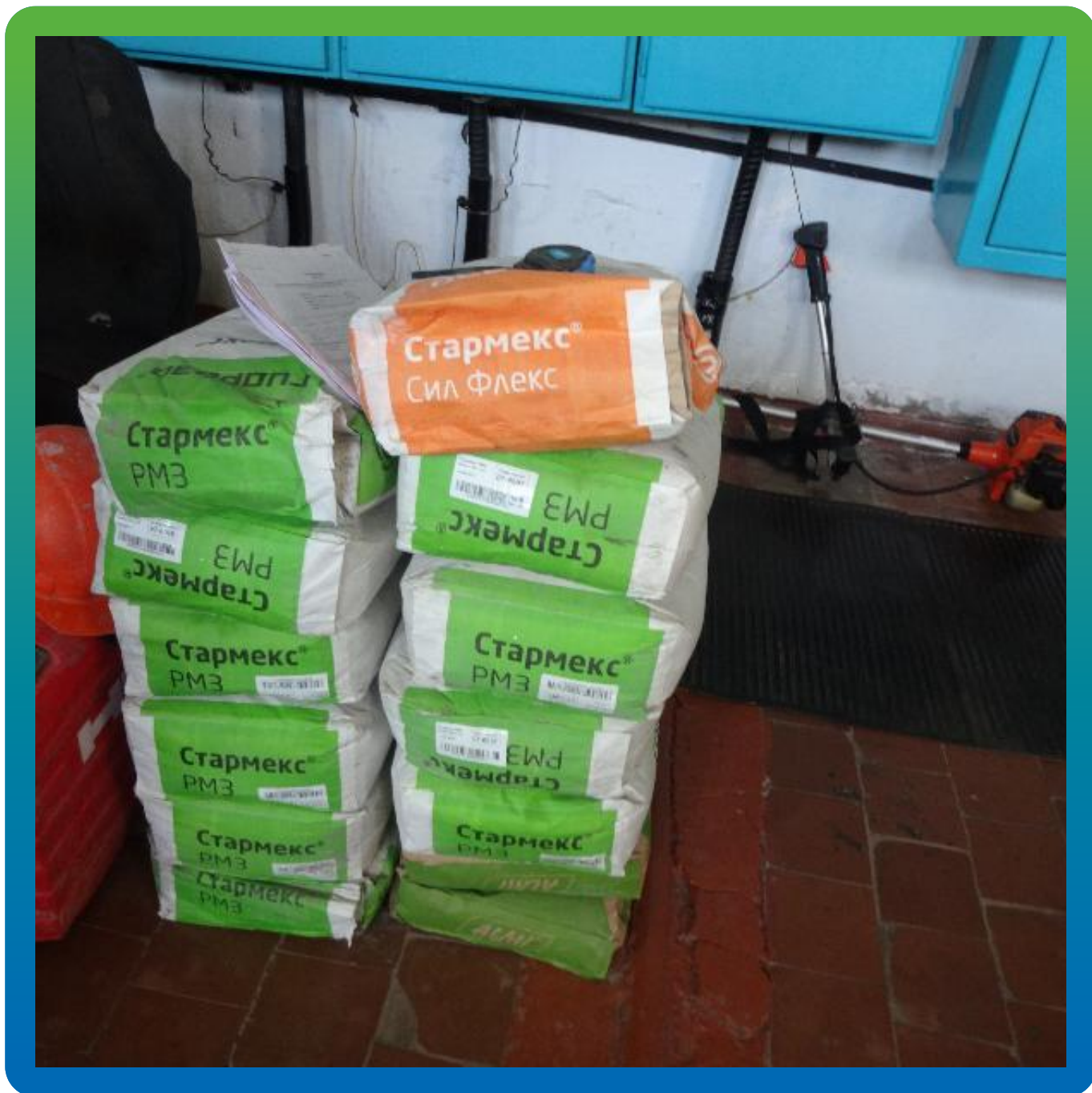
Материалы Гидрозо на объекте
