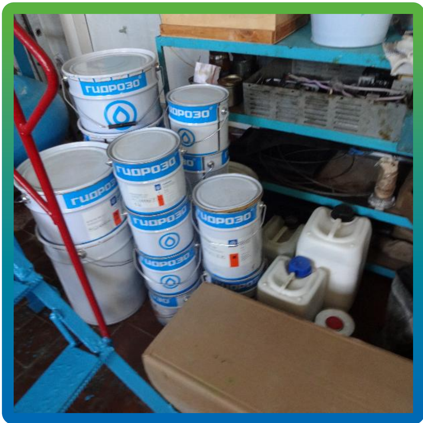
Материалы Гидрозо на объекте
