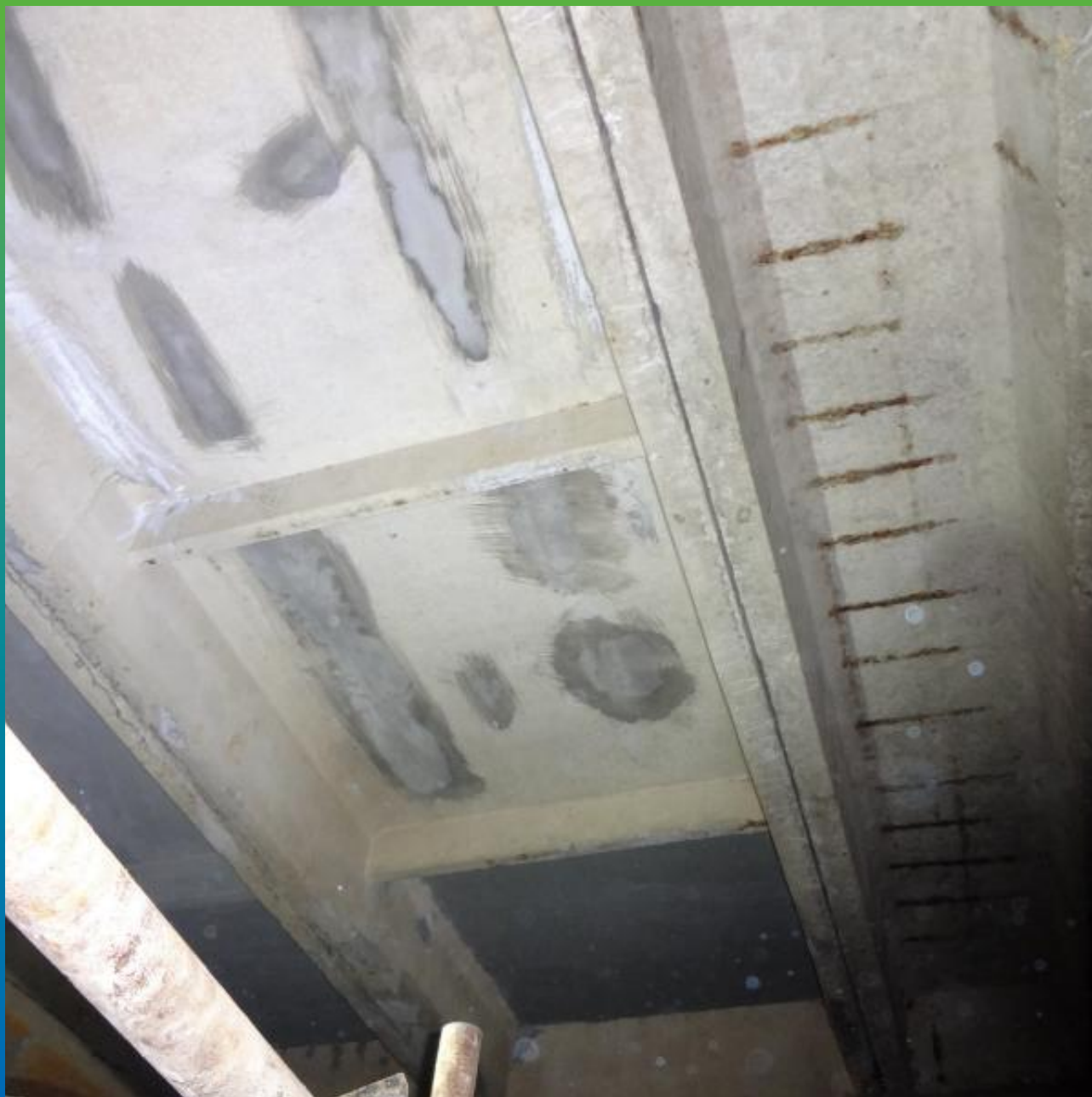
Ремонт поверхности эпоксидным ремонтным составом Манопкс 331
