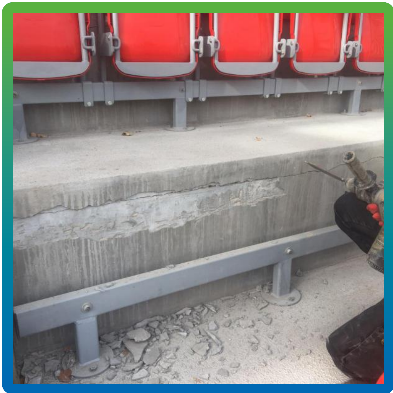
Подготовка к инъектированию Манопокс 352 ЛВ
