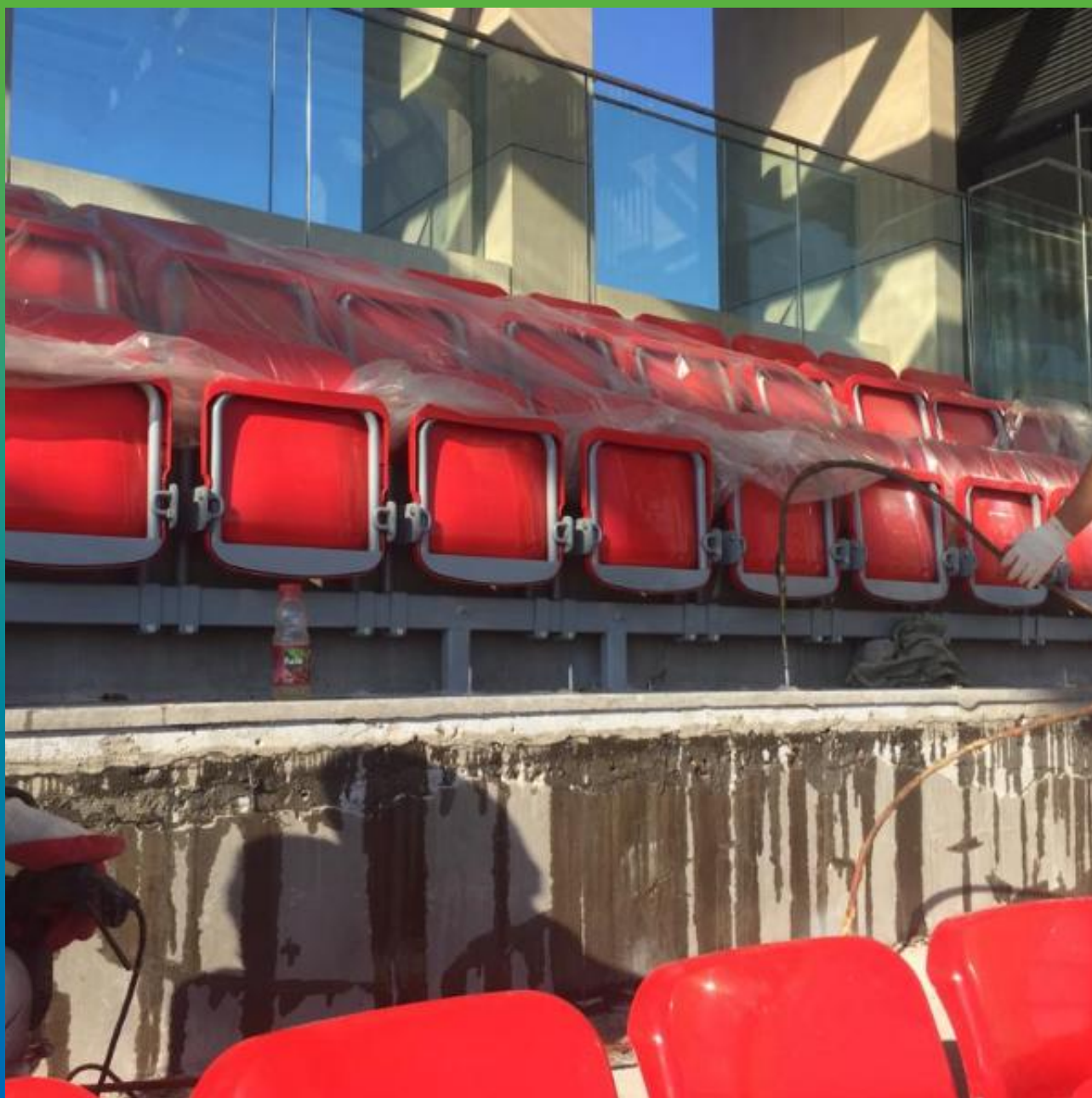
Вид после инъектирования Манопкса 352 ЛВ
