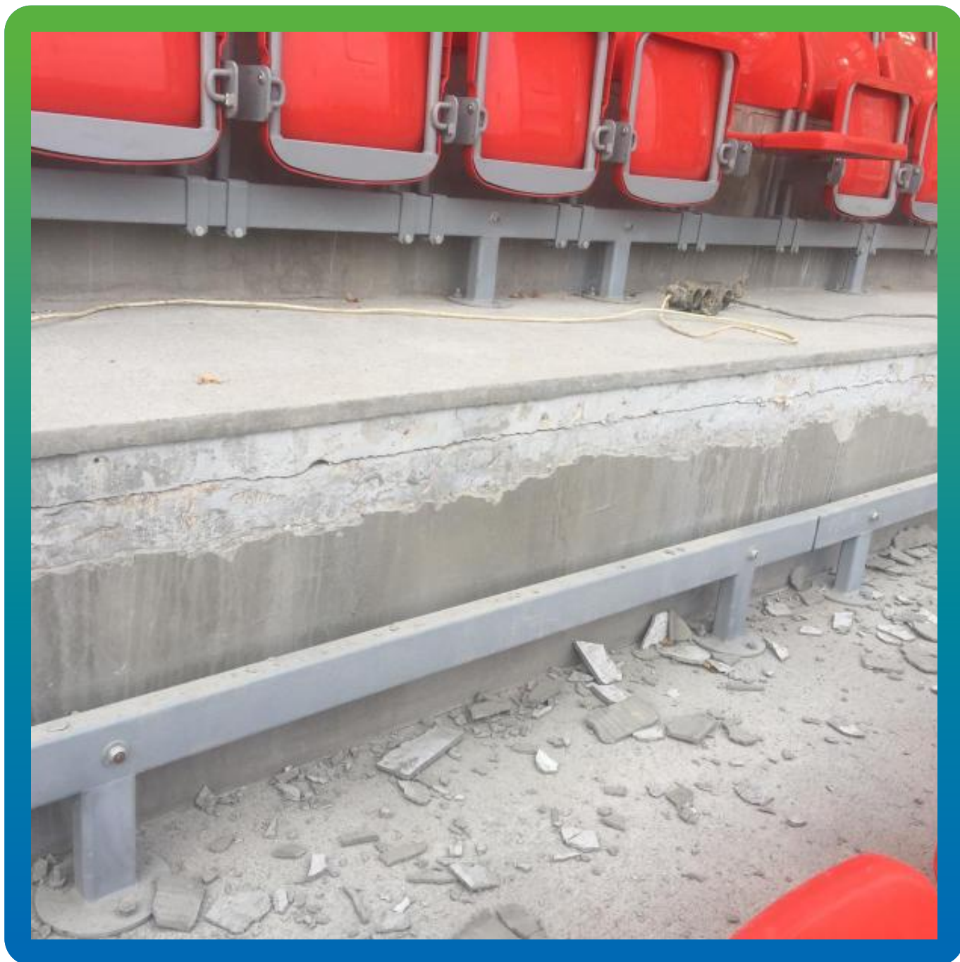
Подготовка к инъектированию Манопокс 352 ЛВ
