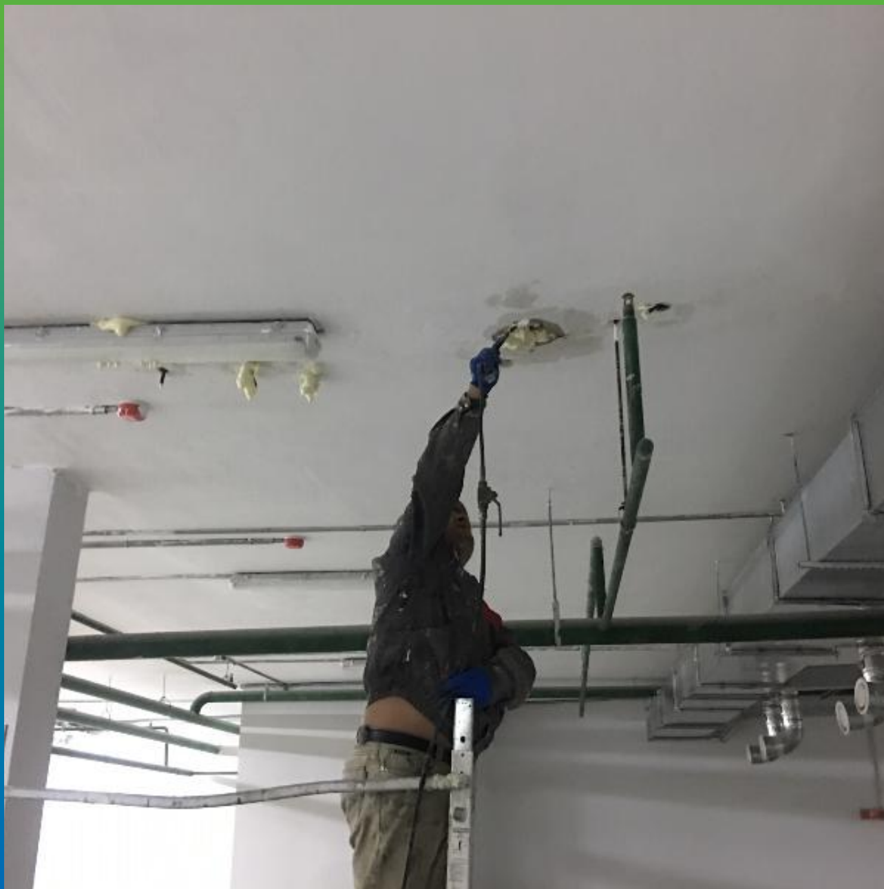
Инъектирование трещин Манопур 143
