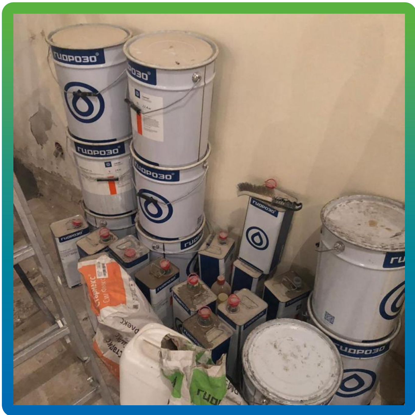
Материалы Гидрозо на объекте
