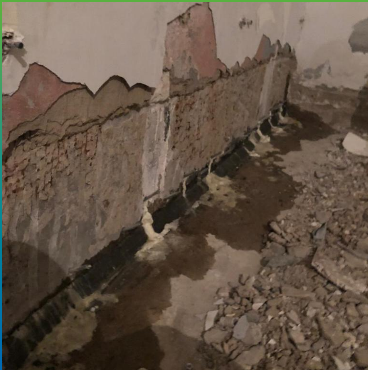
Инъектирование примыкания
