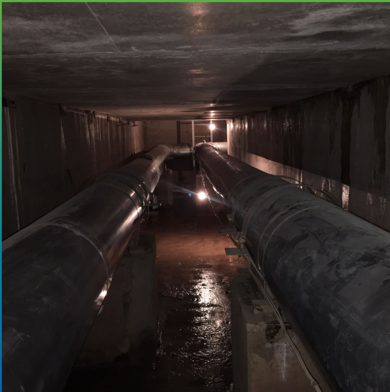
Вид коллектора изнутри
