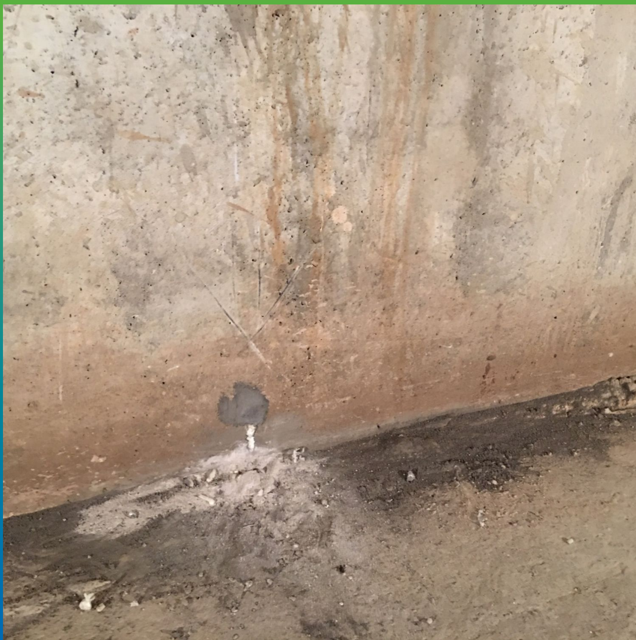
Заделка отверстий от пакеров
