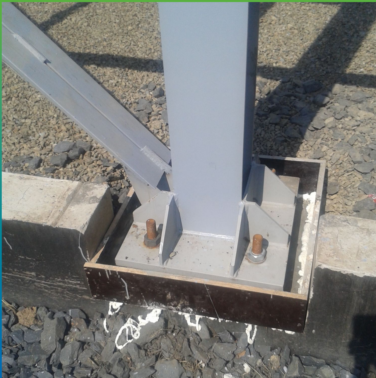
База колонны до подливки Стармекс ФМ7
