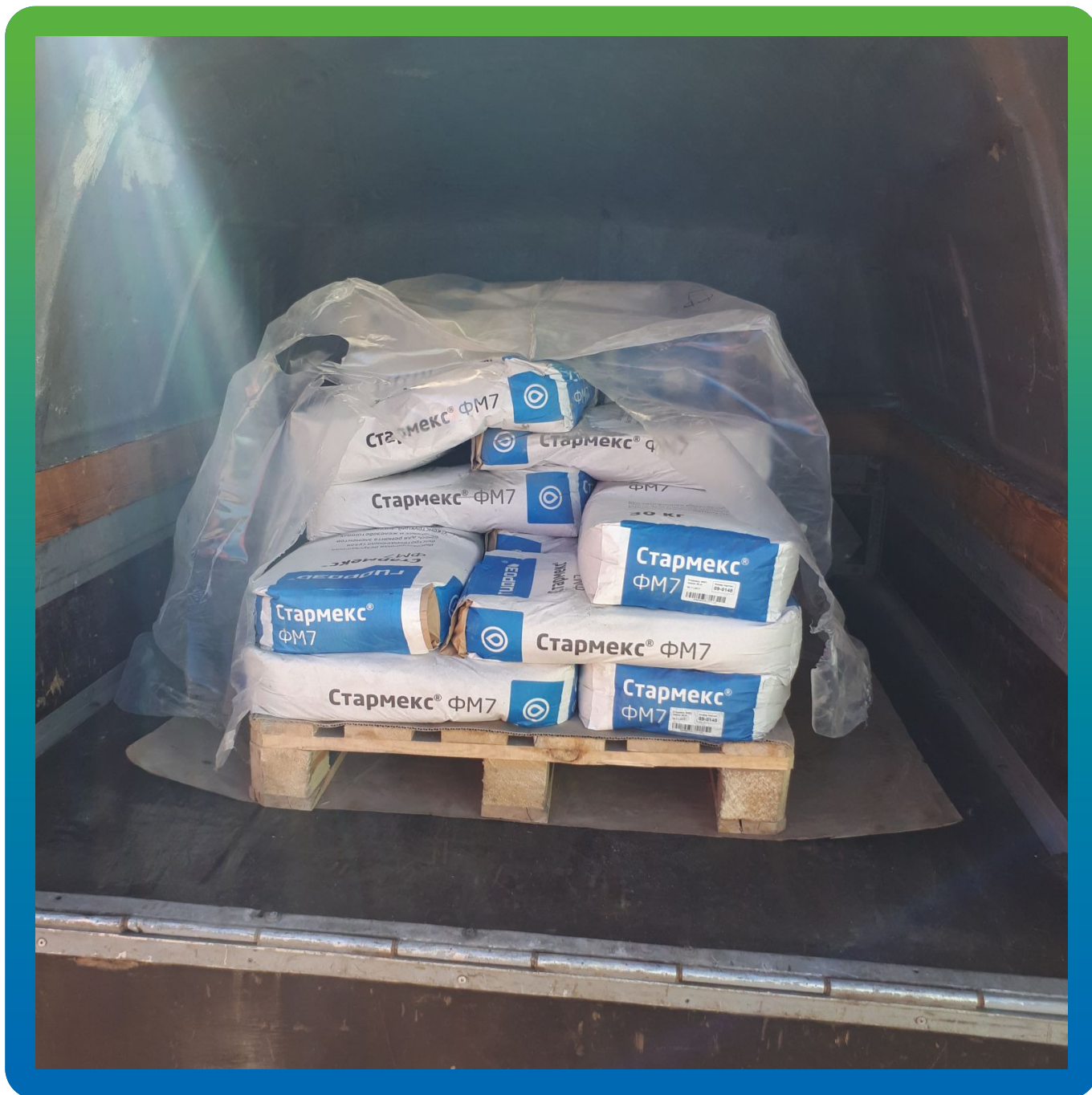
Анкеровочный состав Стармекс ФМ7 на объекте
