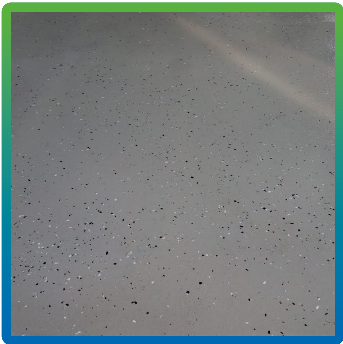
Финишный вид покрытия с добавлением цветных чипсов
