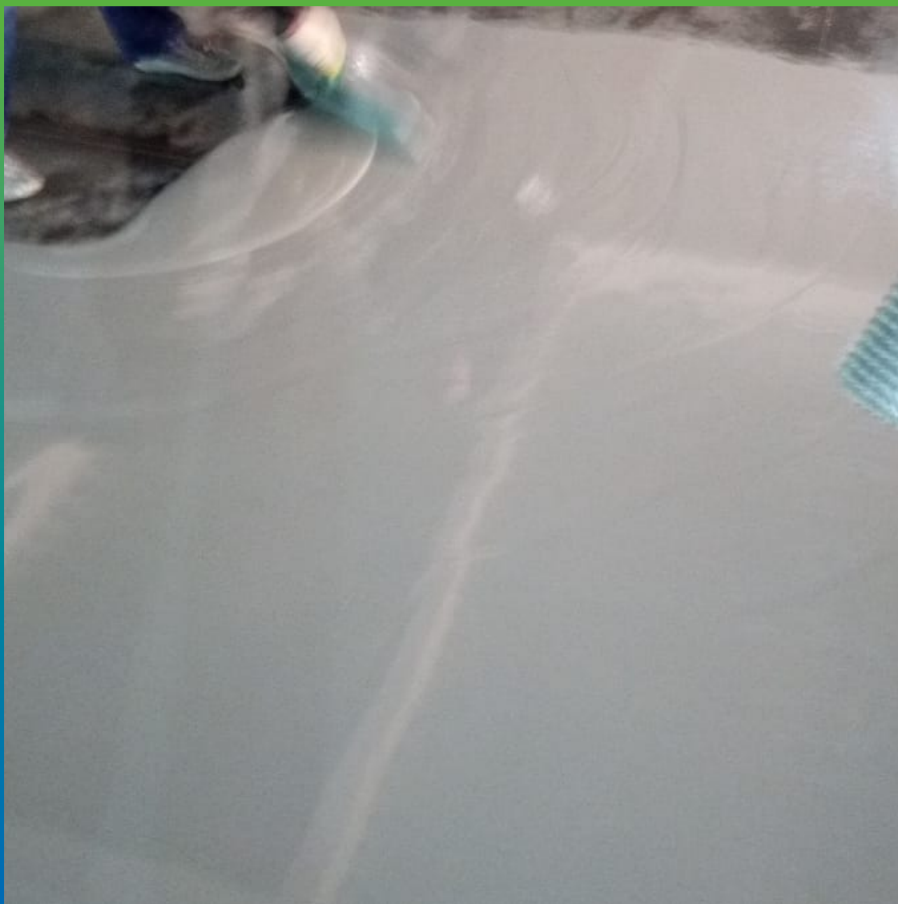
Нанесение базового эпоксидного покрытия
