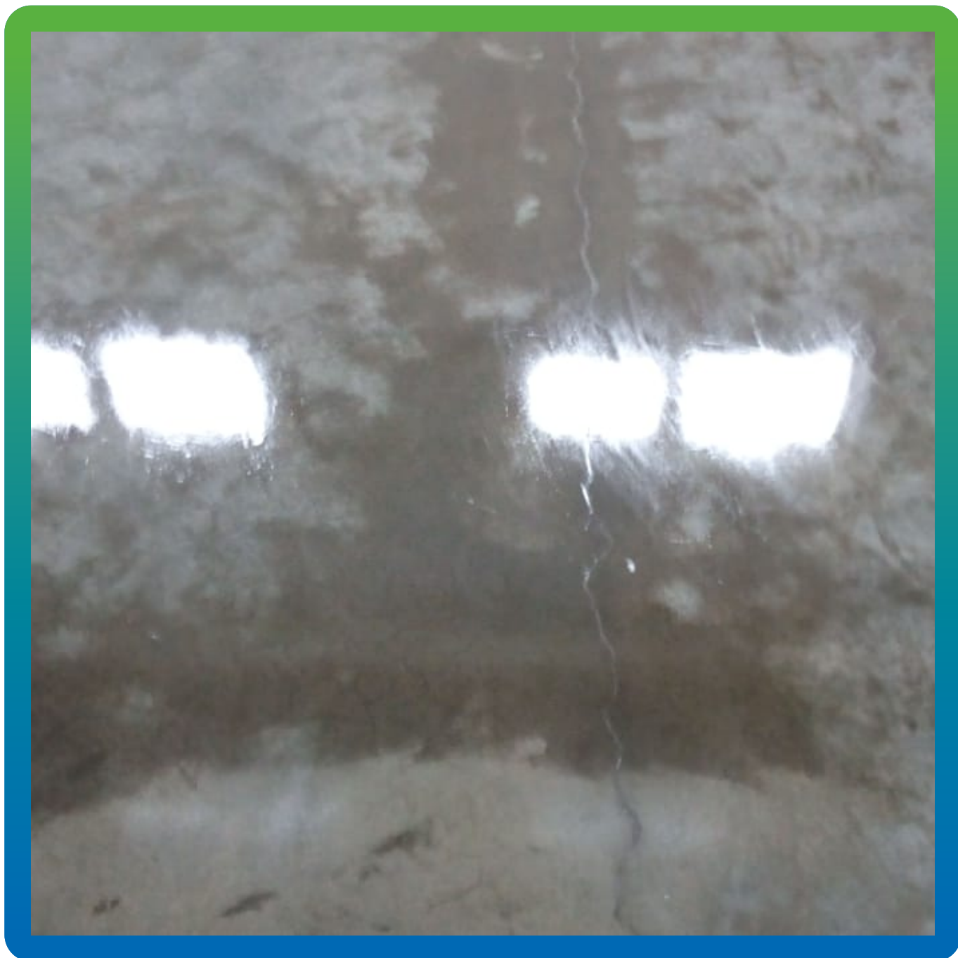
Заделка трещин грунтовкой ДенсТоп ЭП 100 с песком ДенсТоп Филлер 004
