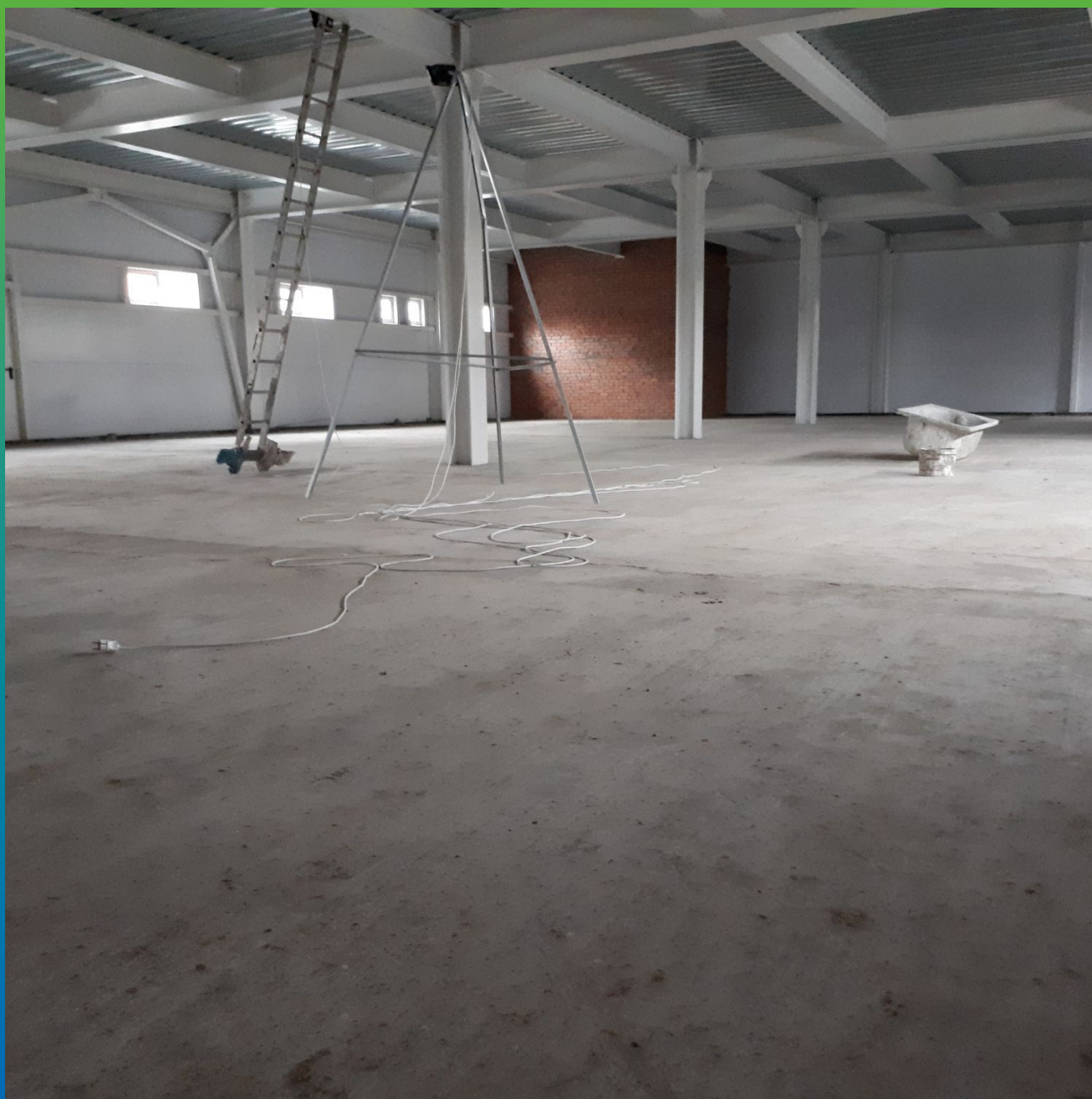
Вид пола до нанесения полимерных покрытий
