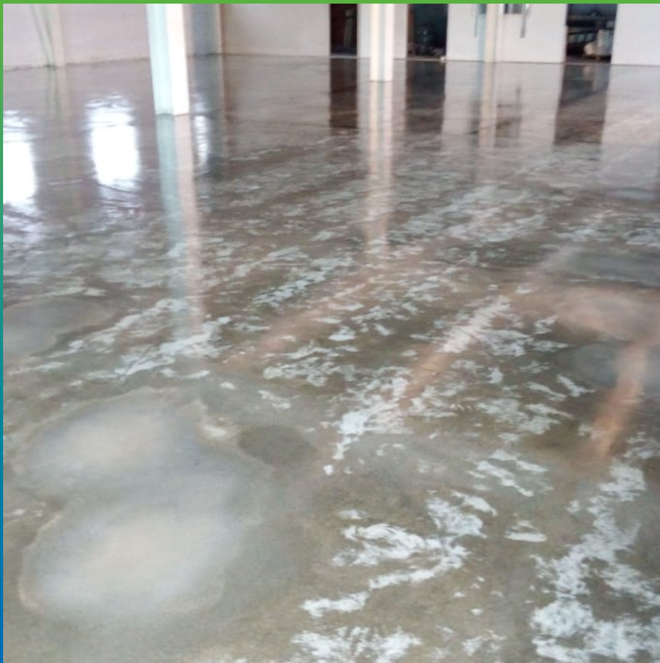
Вид загрунтованной поверхности
