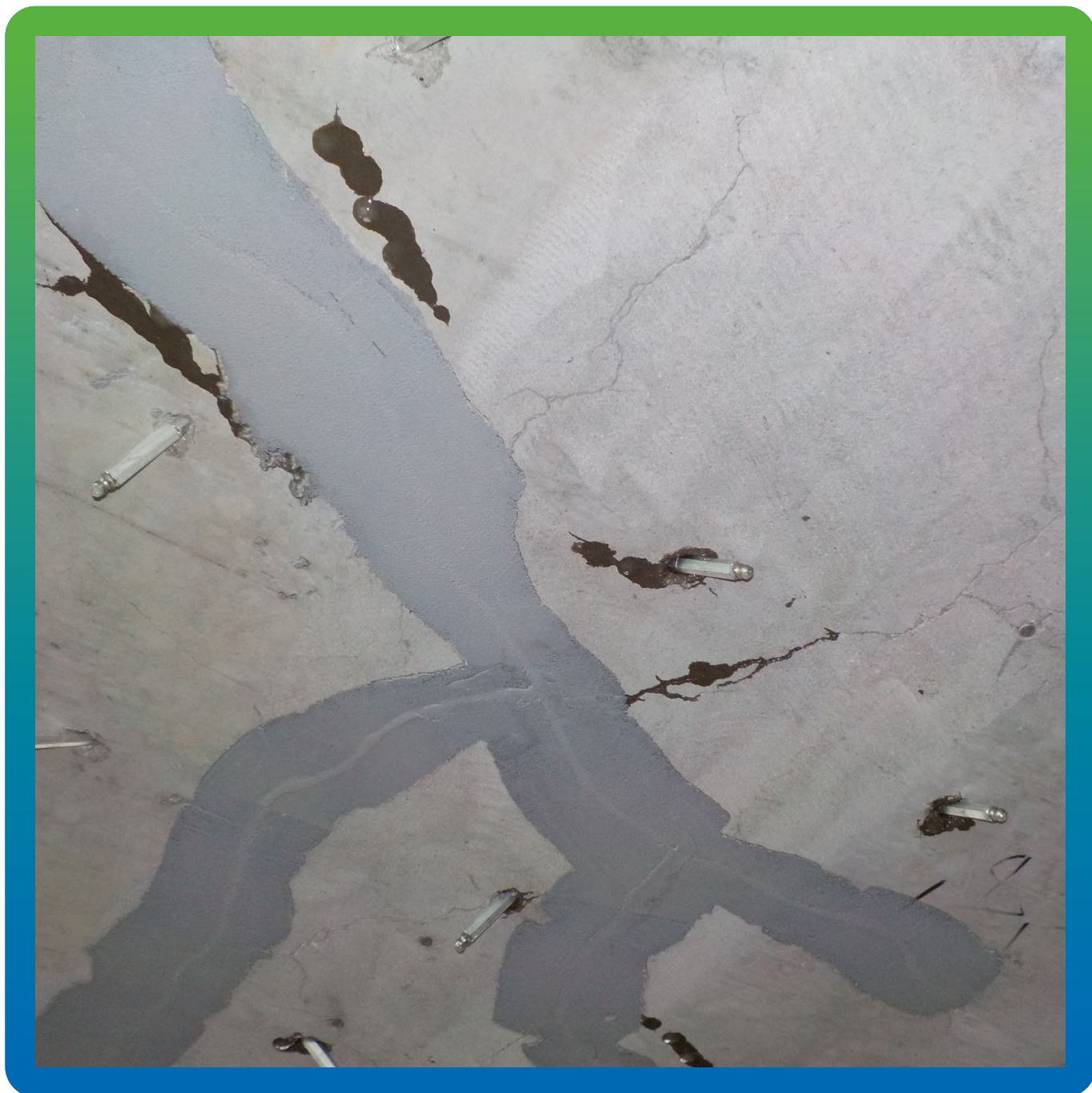
Ремонт и инъектирование трещин
