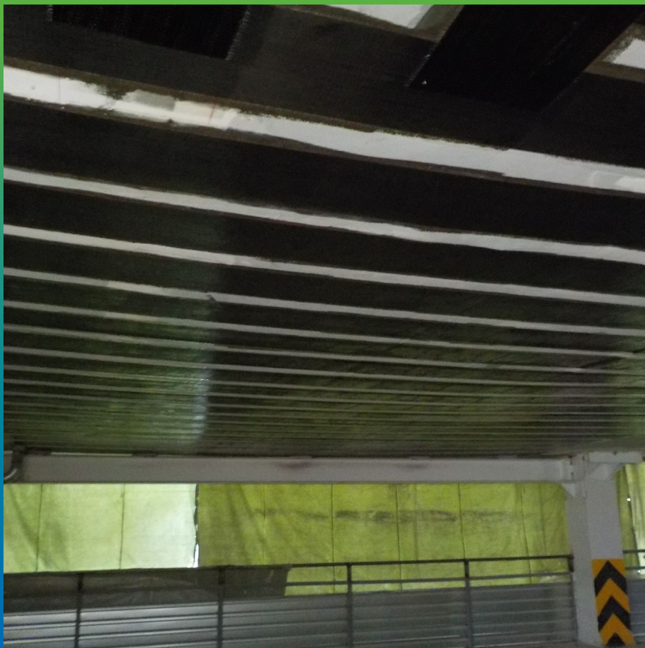
Вид на усиленную плиту перекрытия
