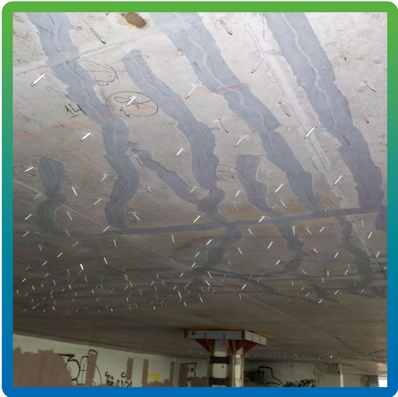
Установка пакеров и заклеивание трещин для прокачивания Манопокс 352 ЛВ
