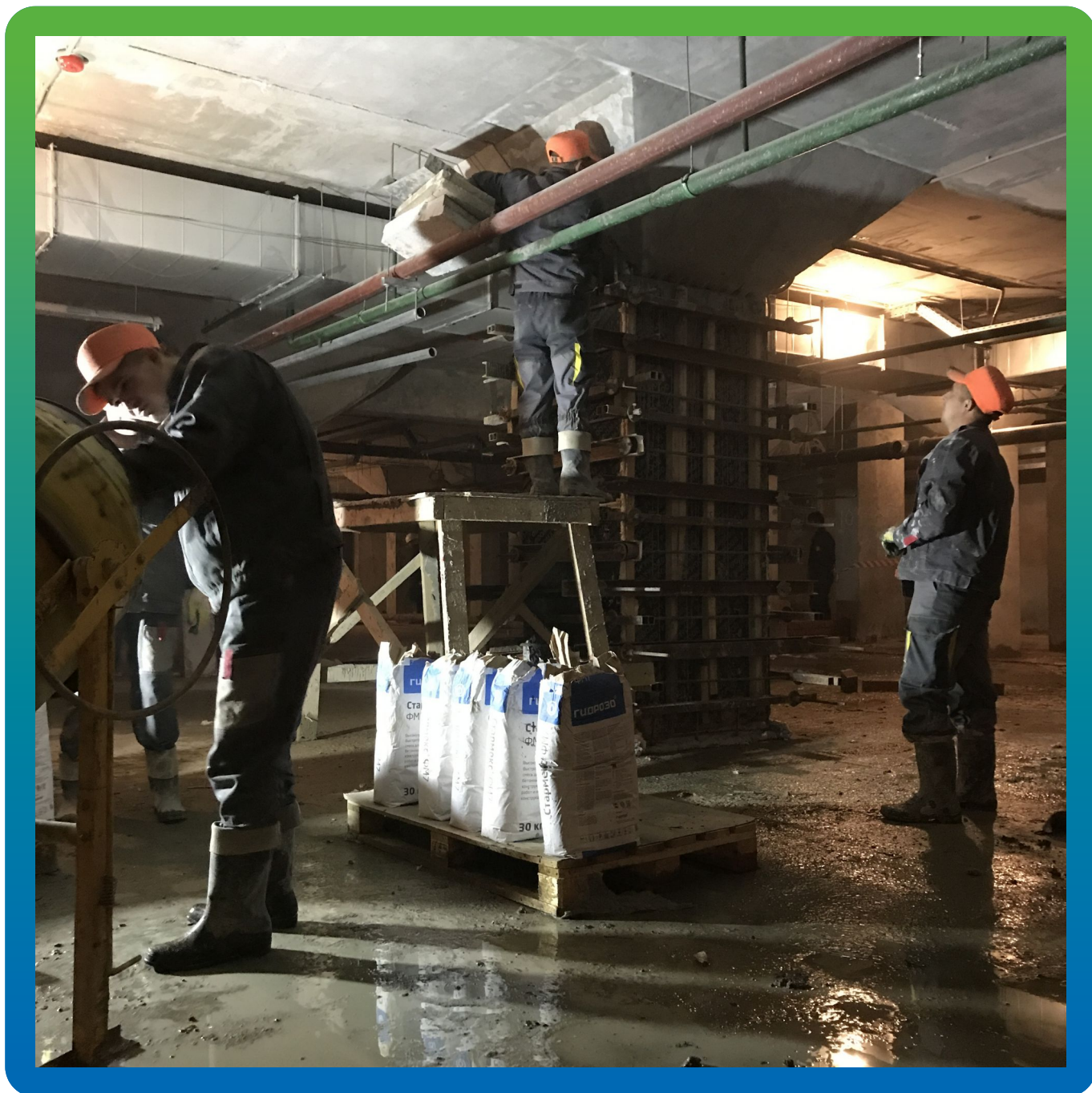
Приготовление состава и заливка в опалубку
