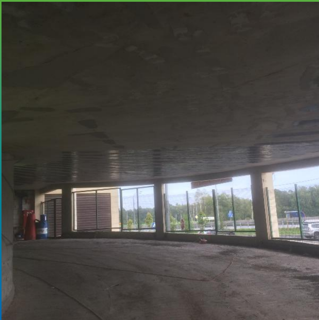
Усиление в зоне заезда
