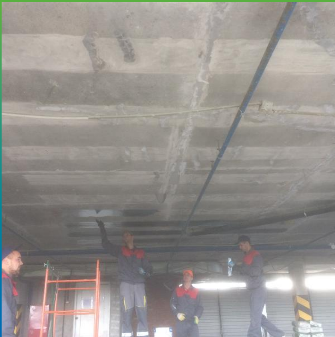
Нанесение ФАП на подготовленную поверхность плиты перекрытия
