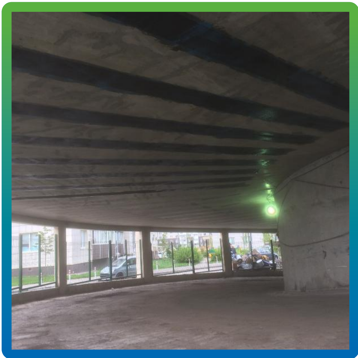
Усиленная плита в зоне выезда из паркинга
