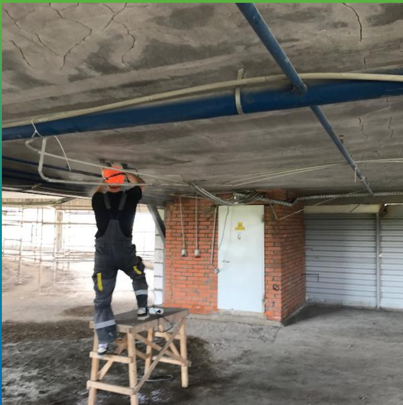
Подготовка поверхности методом полировки
