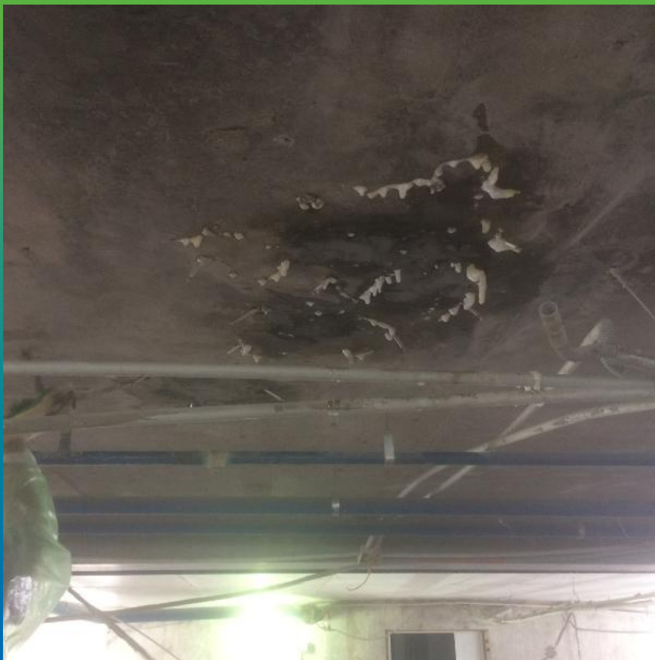
Инъектирование в плиту перекрытия
