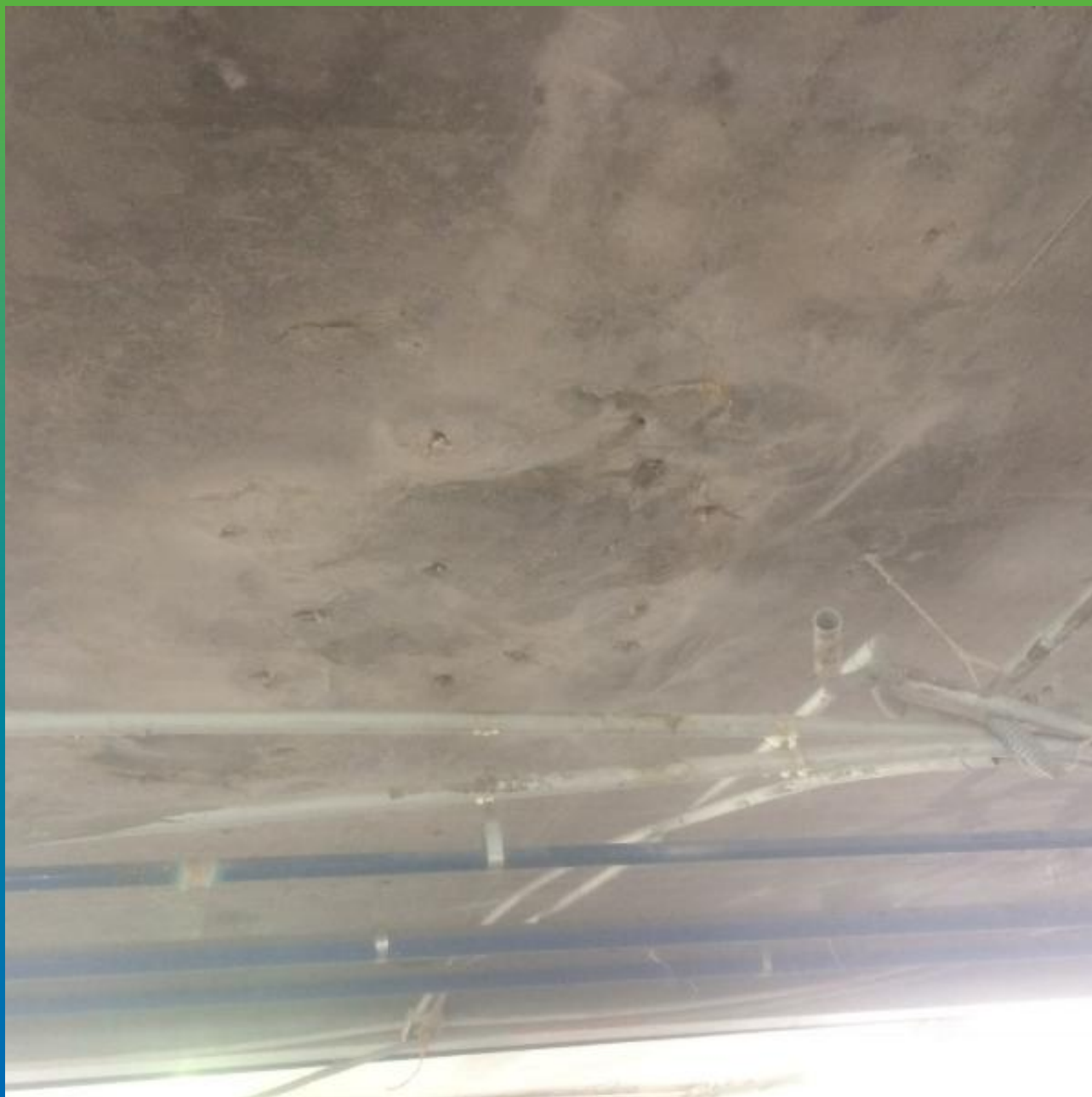
Проинъецированная плита
