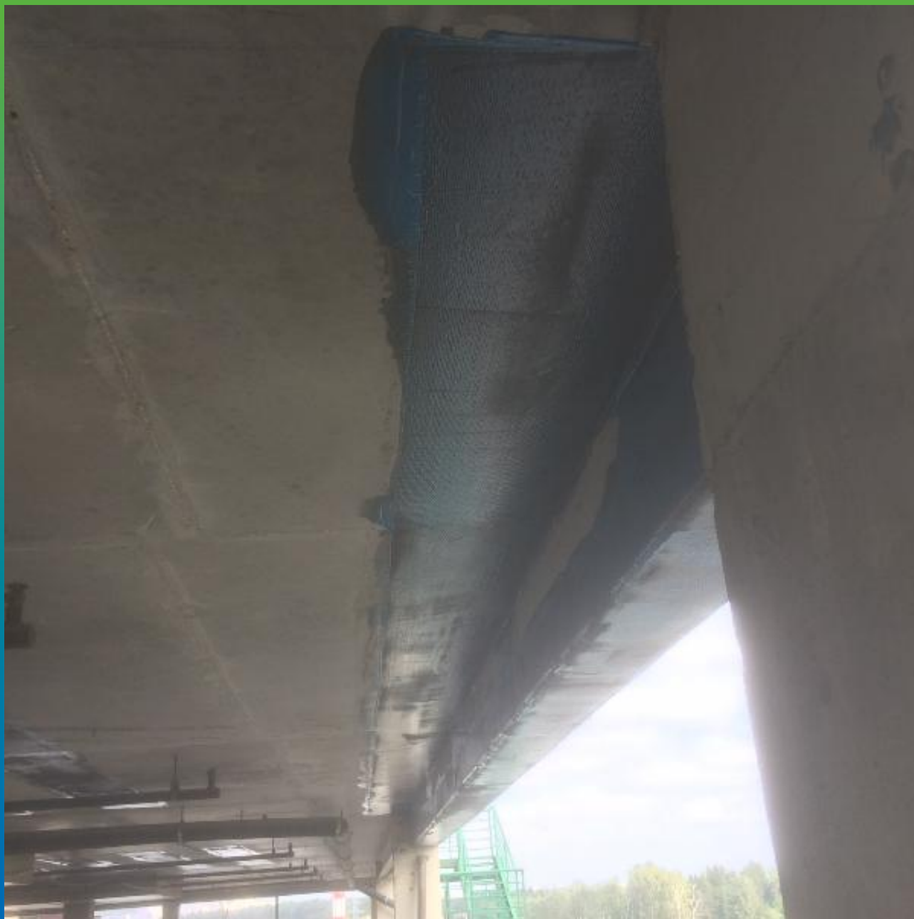
Усиление несущей конструкции паркинга
