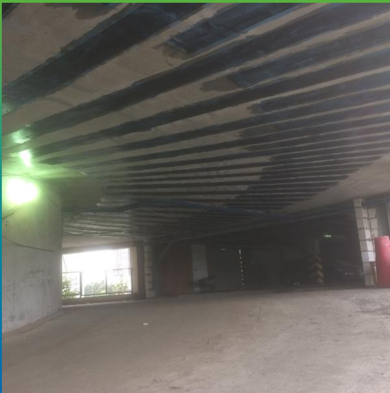
Усиленная плита в зоне въезда в паркинг
