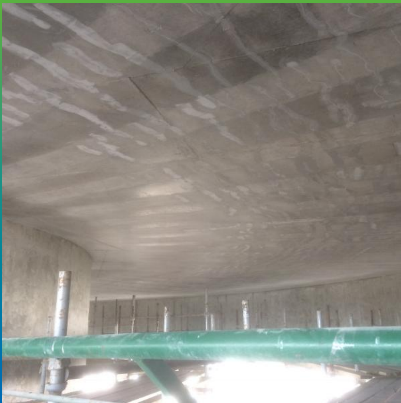
Подготовленная для нанесения ФАП поверхность
