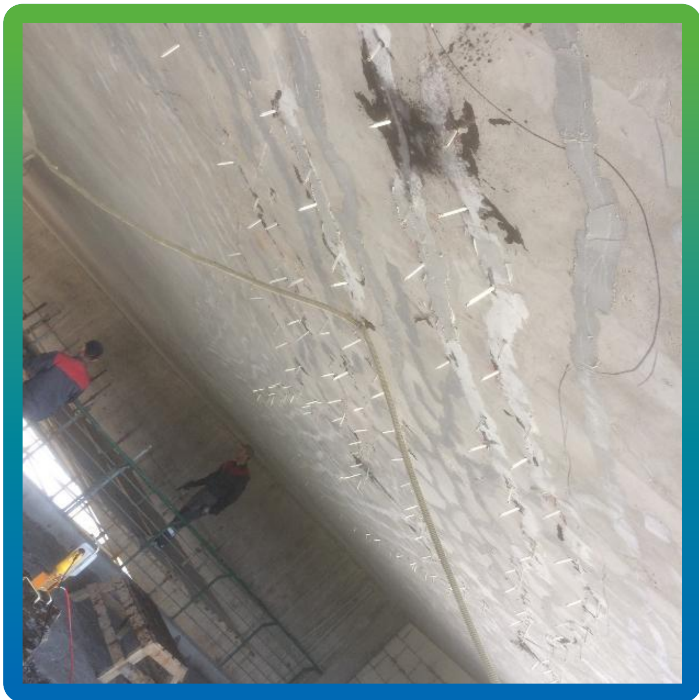
Установленные пакеры вдоль трещин
