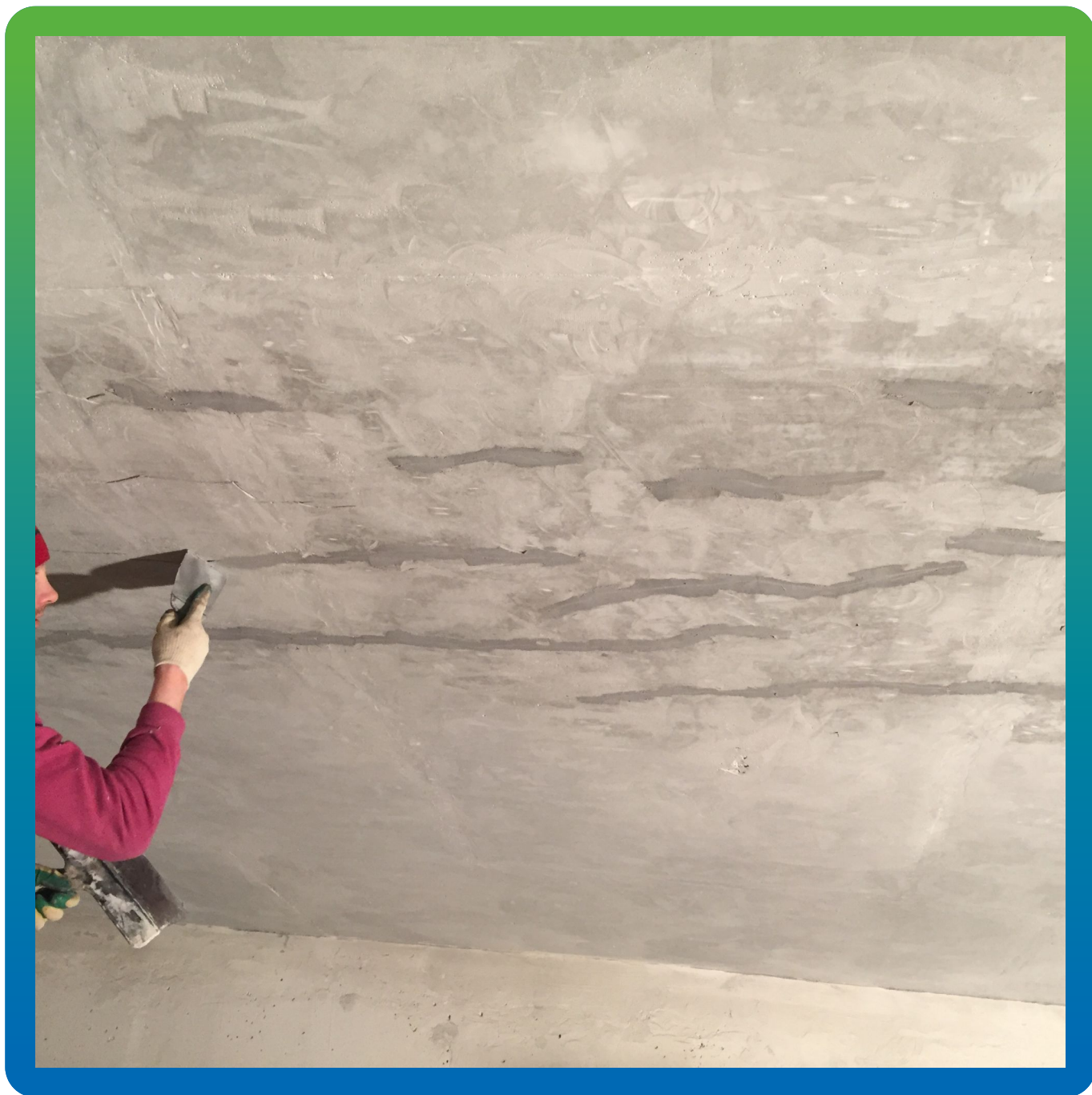
Ремонт трещин
