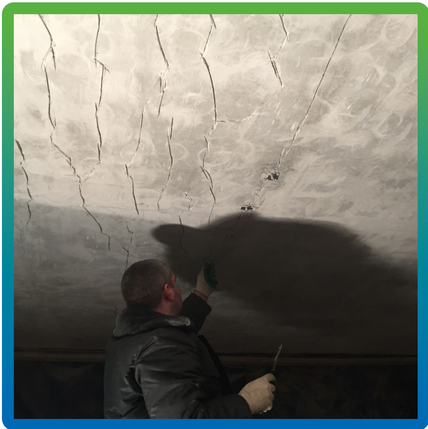
Расшитые трещины
