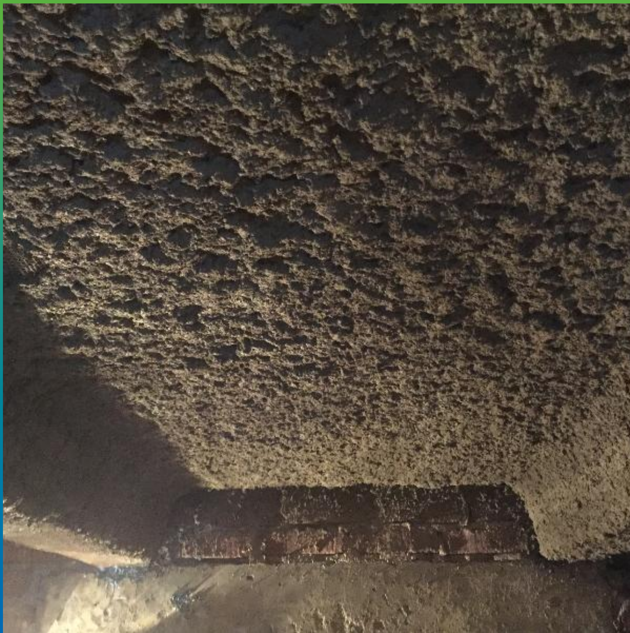
Нанесенный огнезащитный состав
