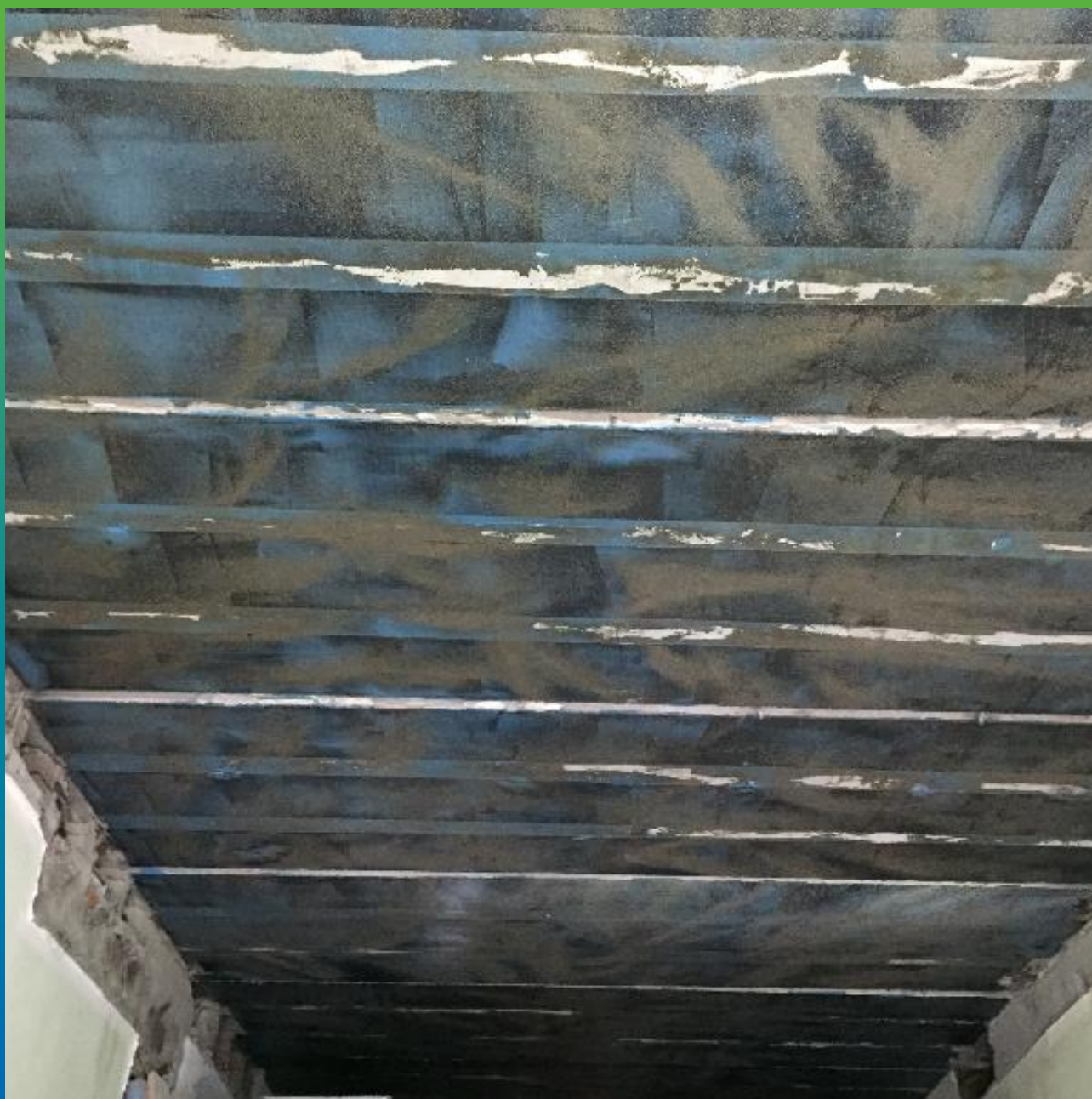
Усиление композитной системой Гидрозо
