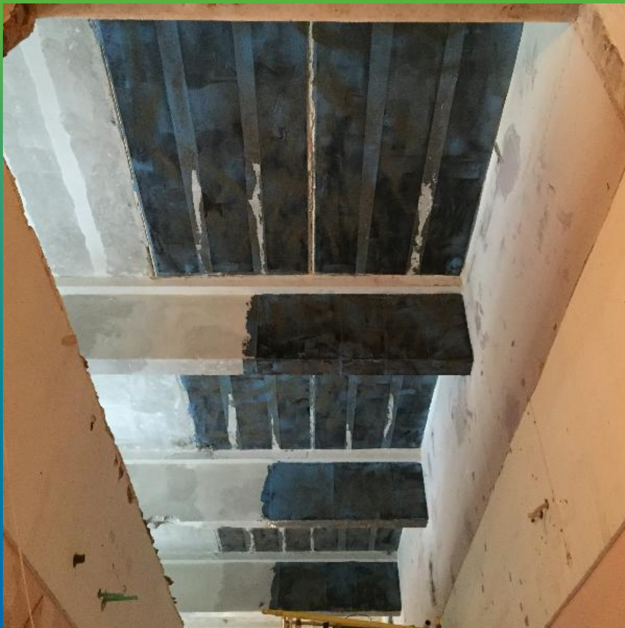
Усиление балок и плит перекрытий
