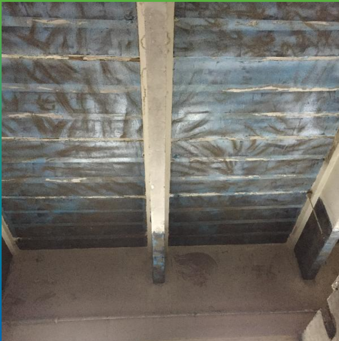
Усиление несущей конструкции
