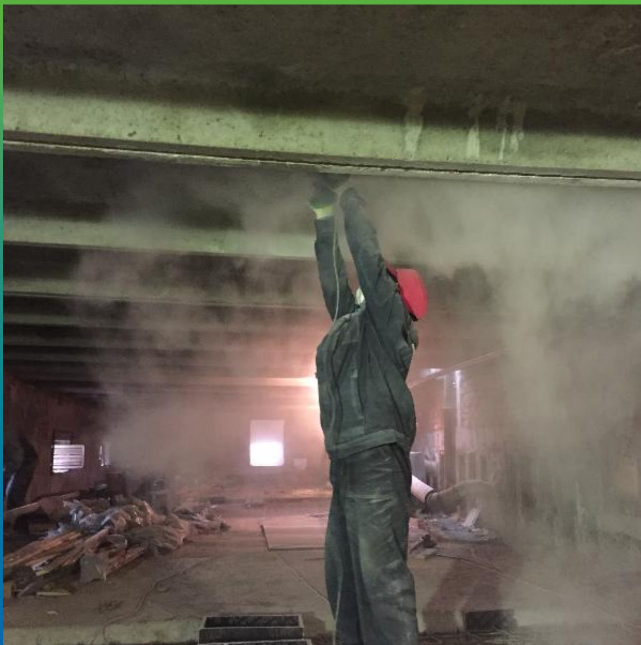
Полировка поверхности железобетона
