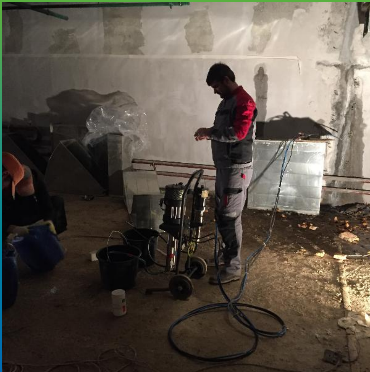
Подготовка Акрилатного двухкомпонентного насоса БМ 1425 с привлечением инженера компании Гидрозо
