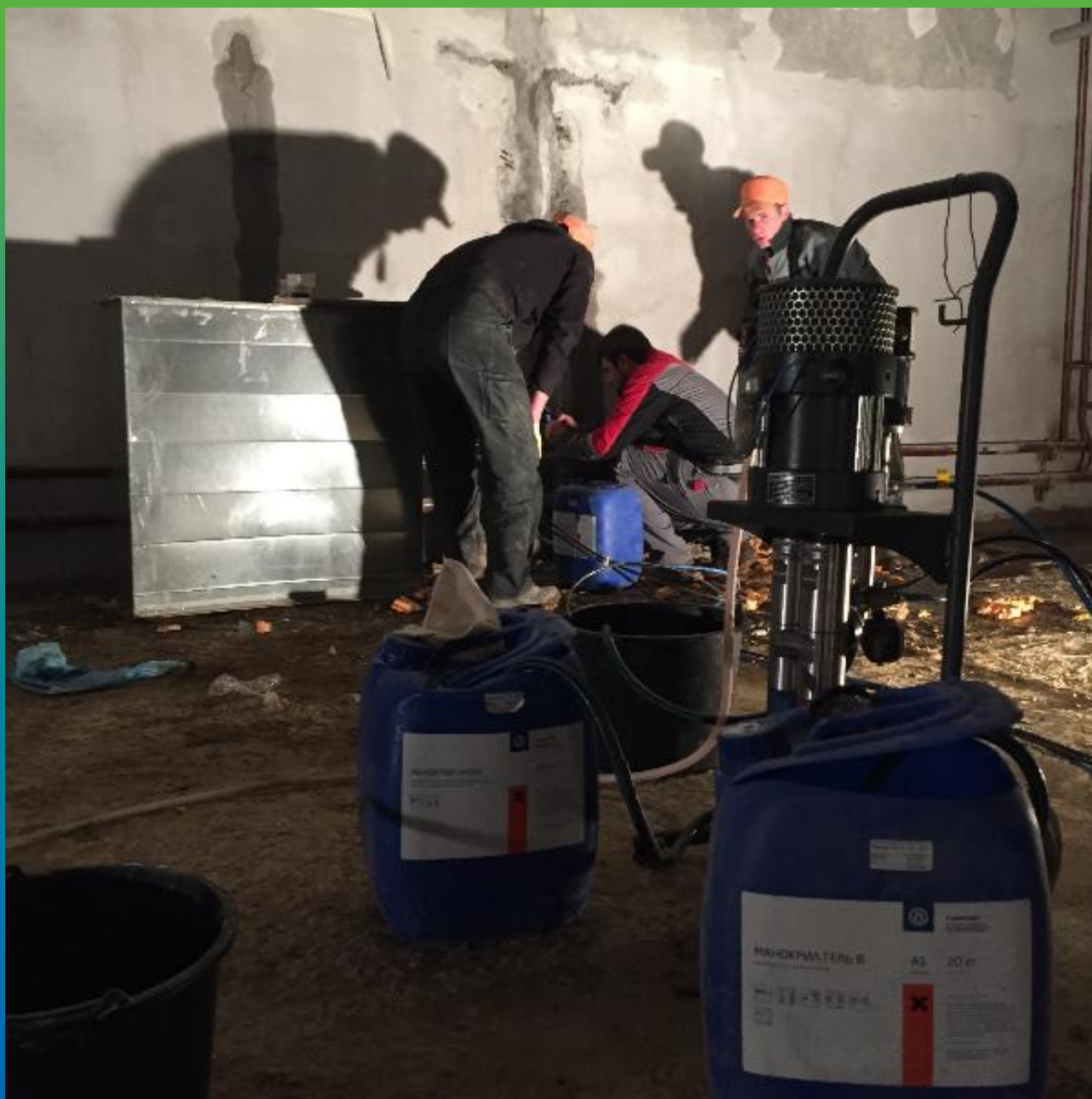
Готовые к работе акрилатный насос БМ 1425 и гель Манокрил Гель В
