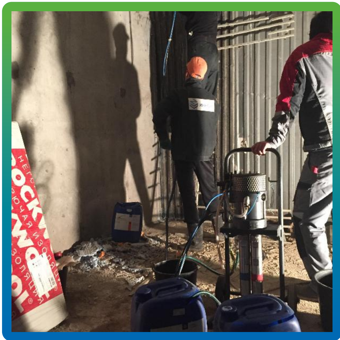
Инъектирование акрилатного геля Манокрил Гель В через пакеры
