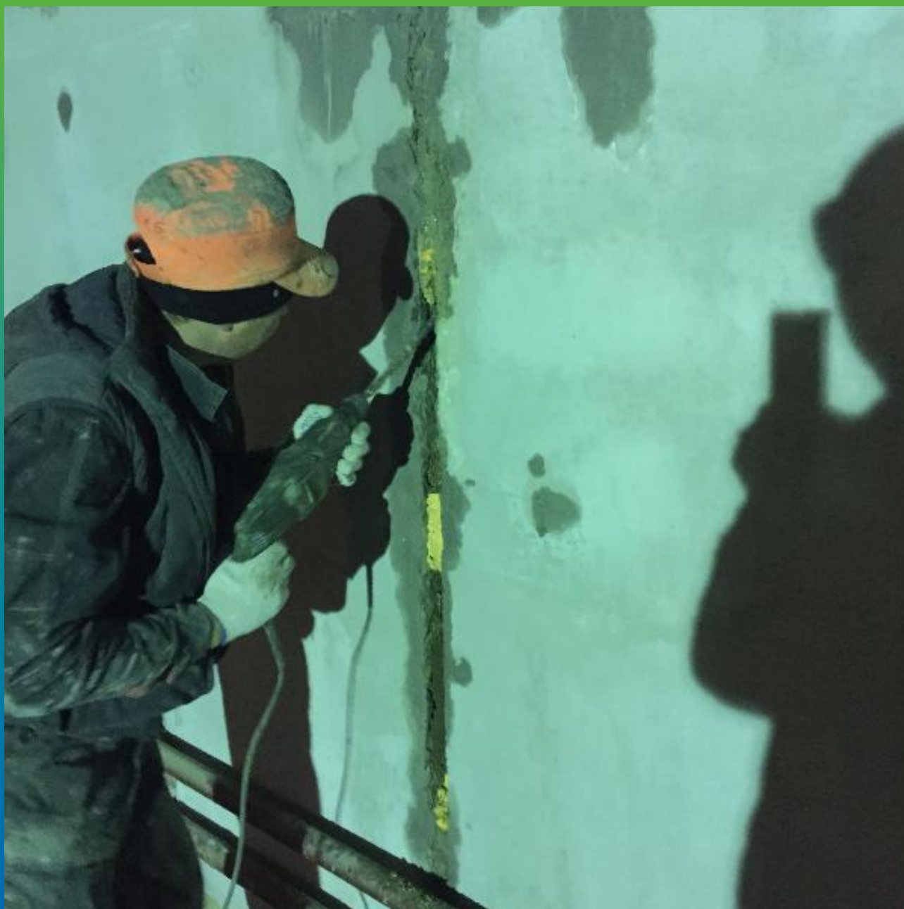
Расшивка и подготовка деформационного шва
