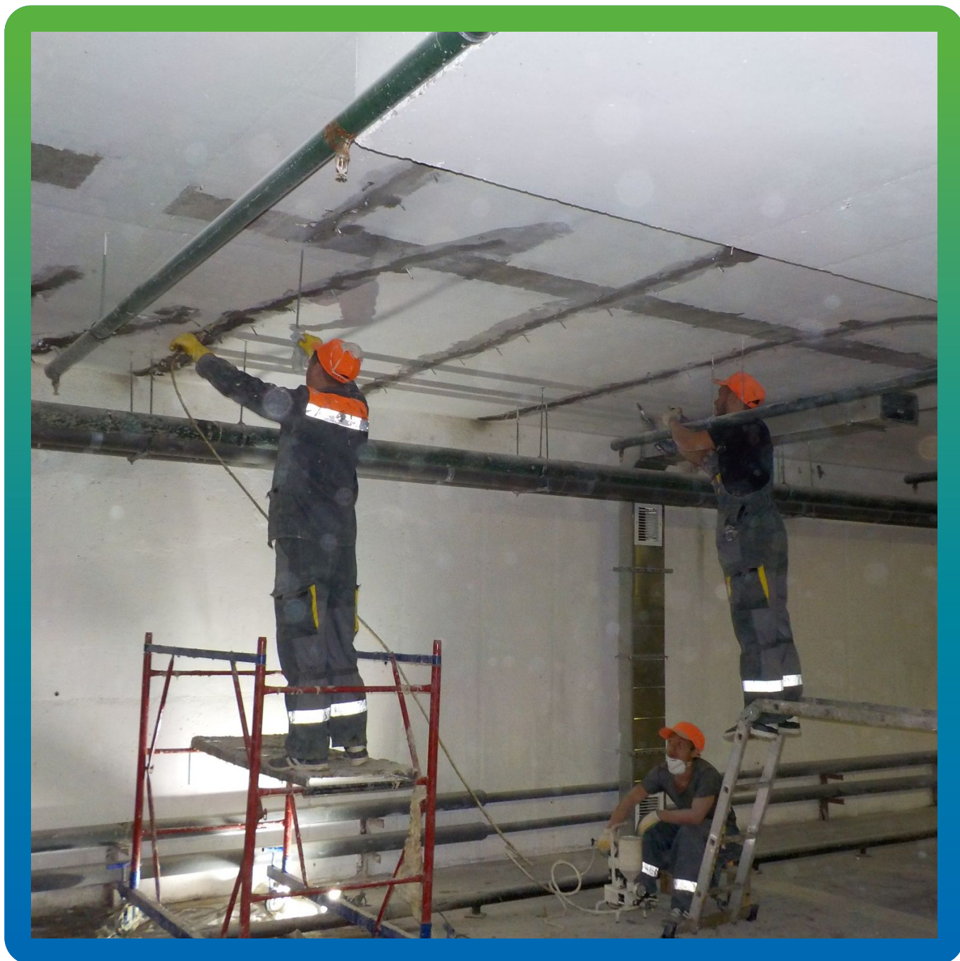
Инъектирование примыкания Манопур С при помощи насоса БМ 0401
