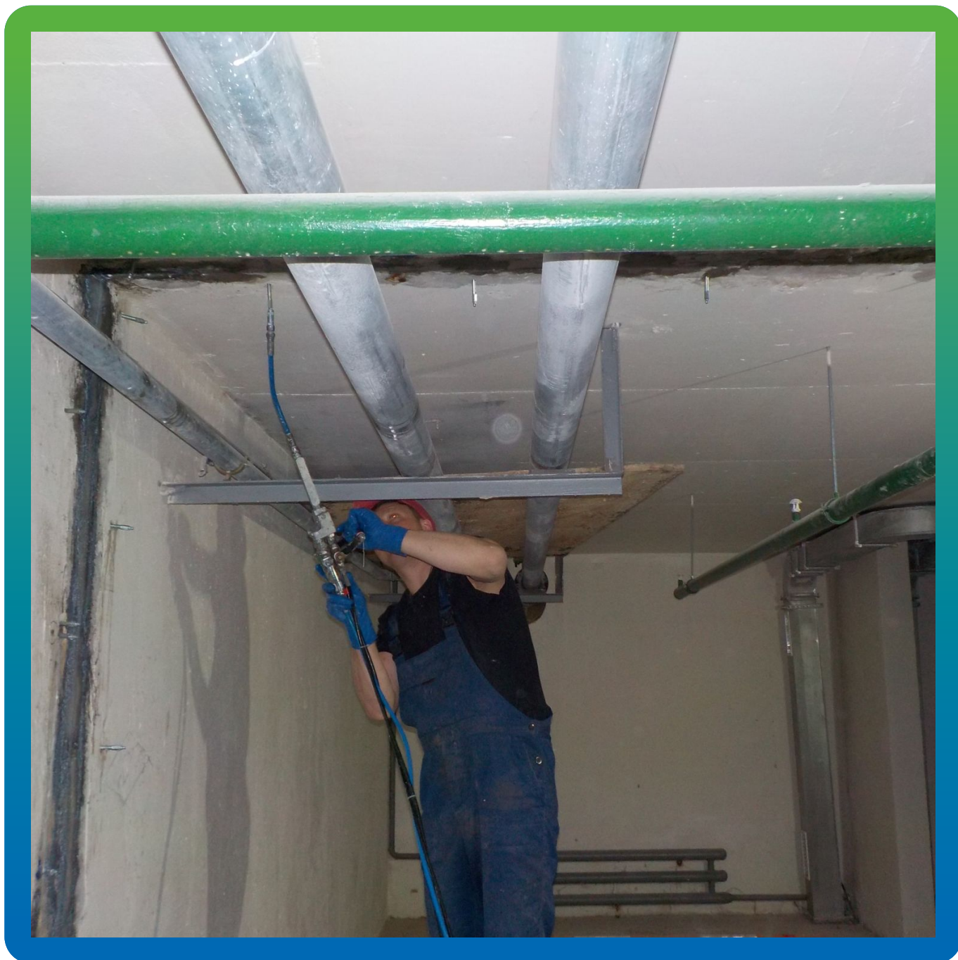
Инъектирование шва между плитами перекрытия
