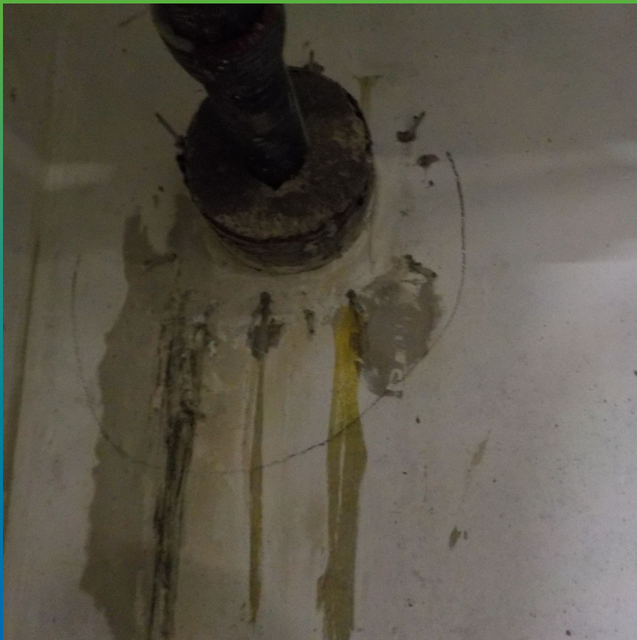
Инъектирование входа коммуникаций
