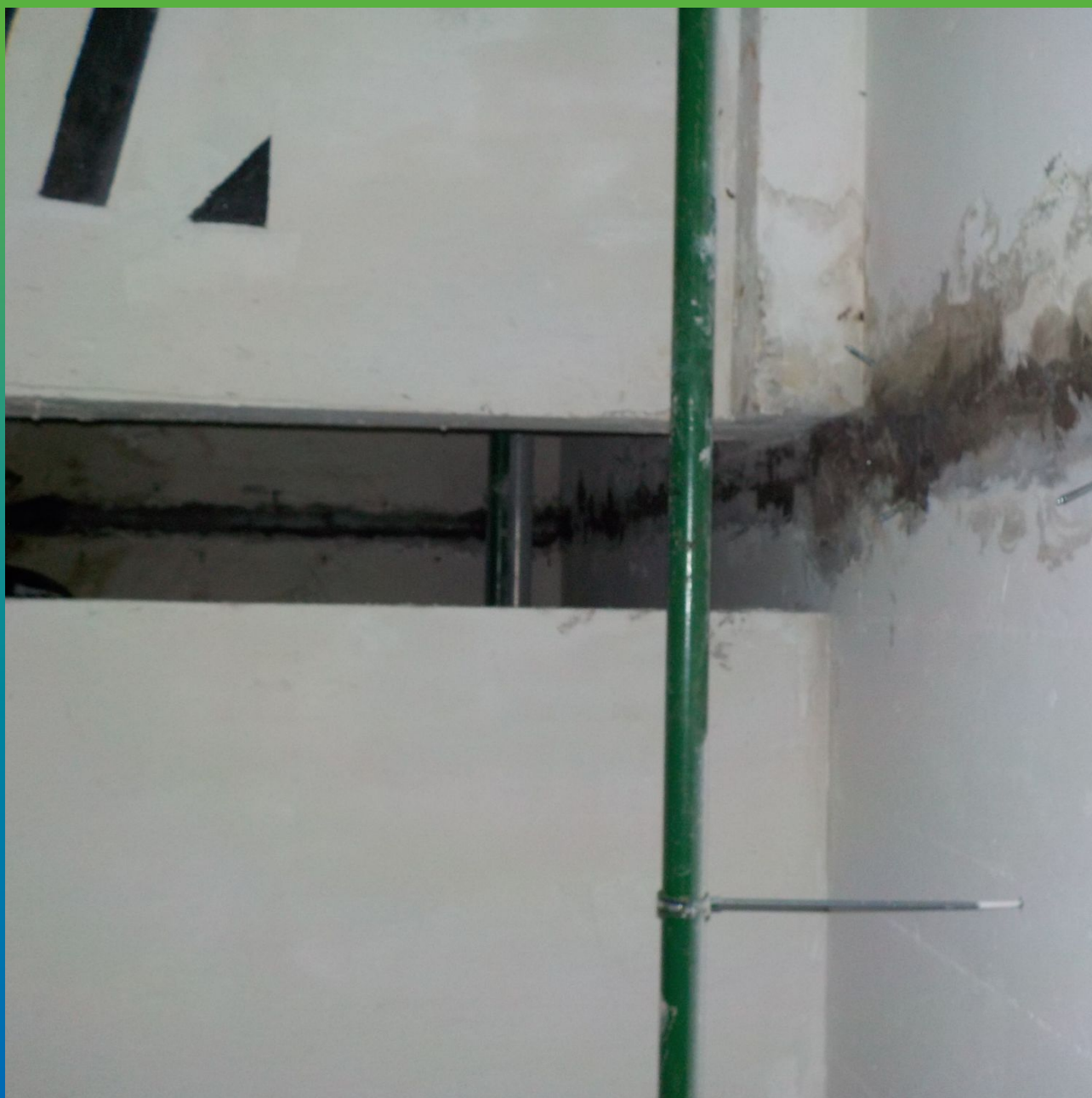
Шов под инъектирование гелем
