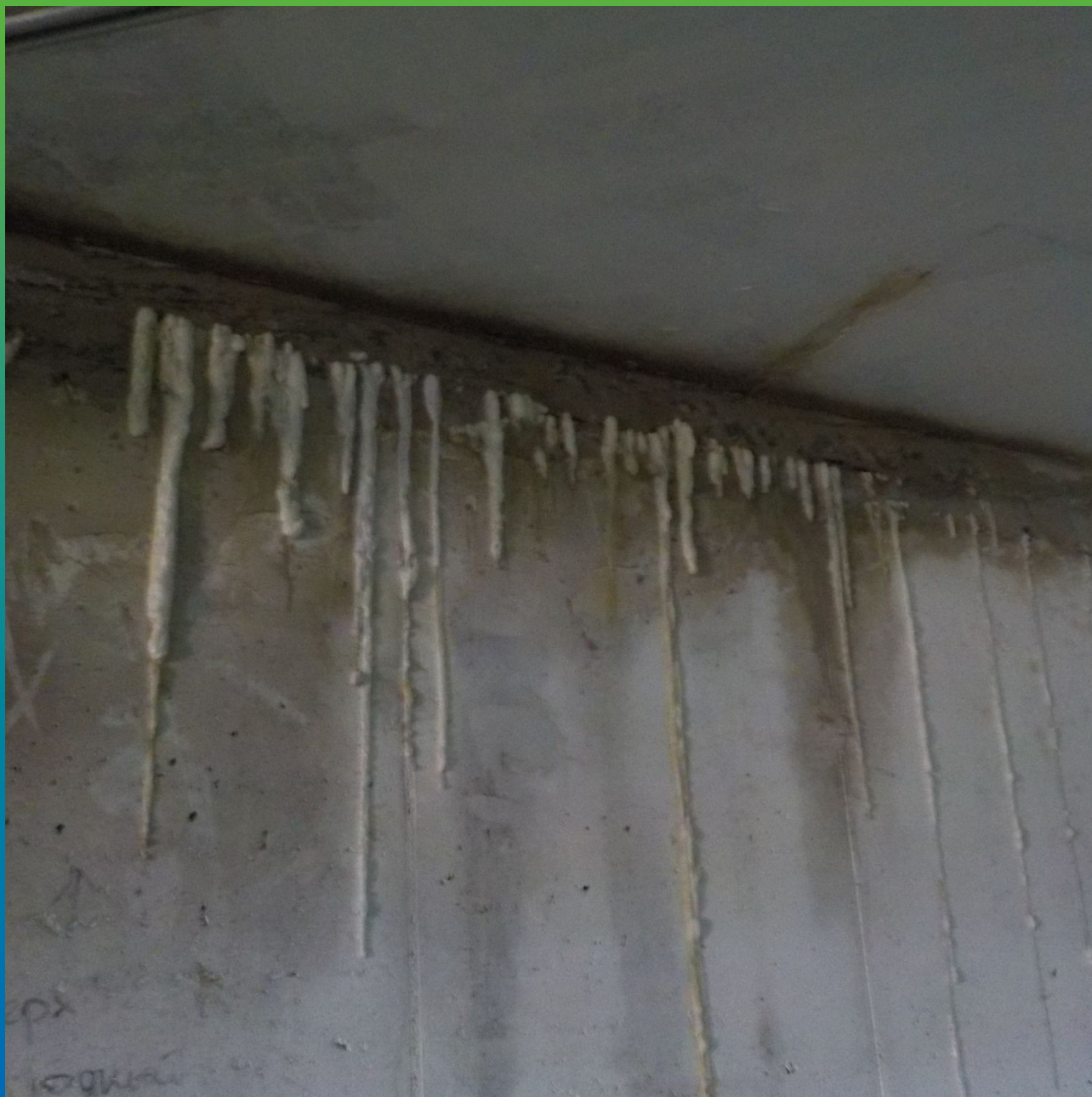
Проинъектированное примыкание Манопур С
