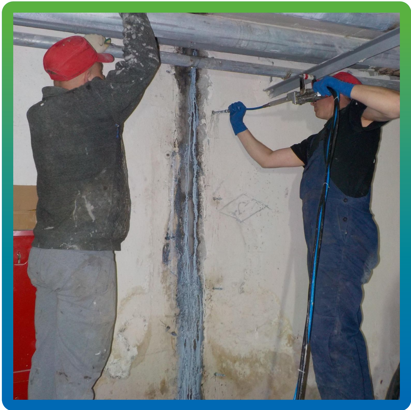
Инъектирование вертикального шва
