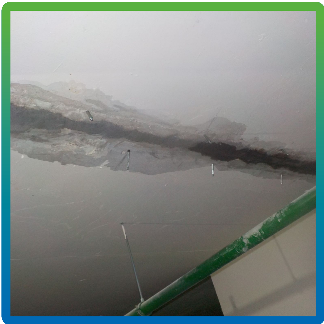
Пакеры в плите перекрытия для инъектирования
