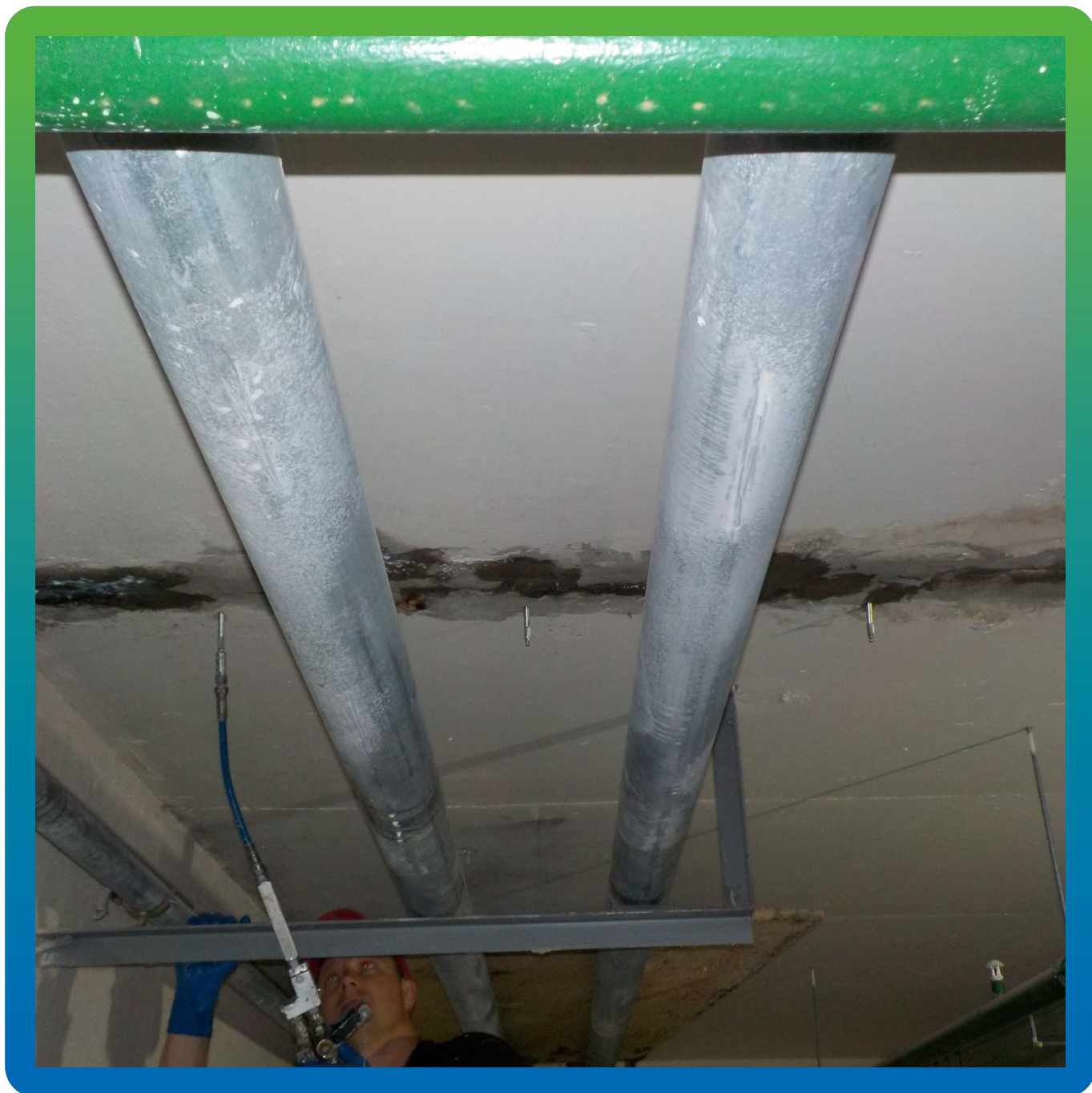
Инъектирование в плиту перекрытия
