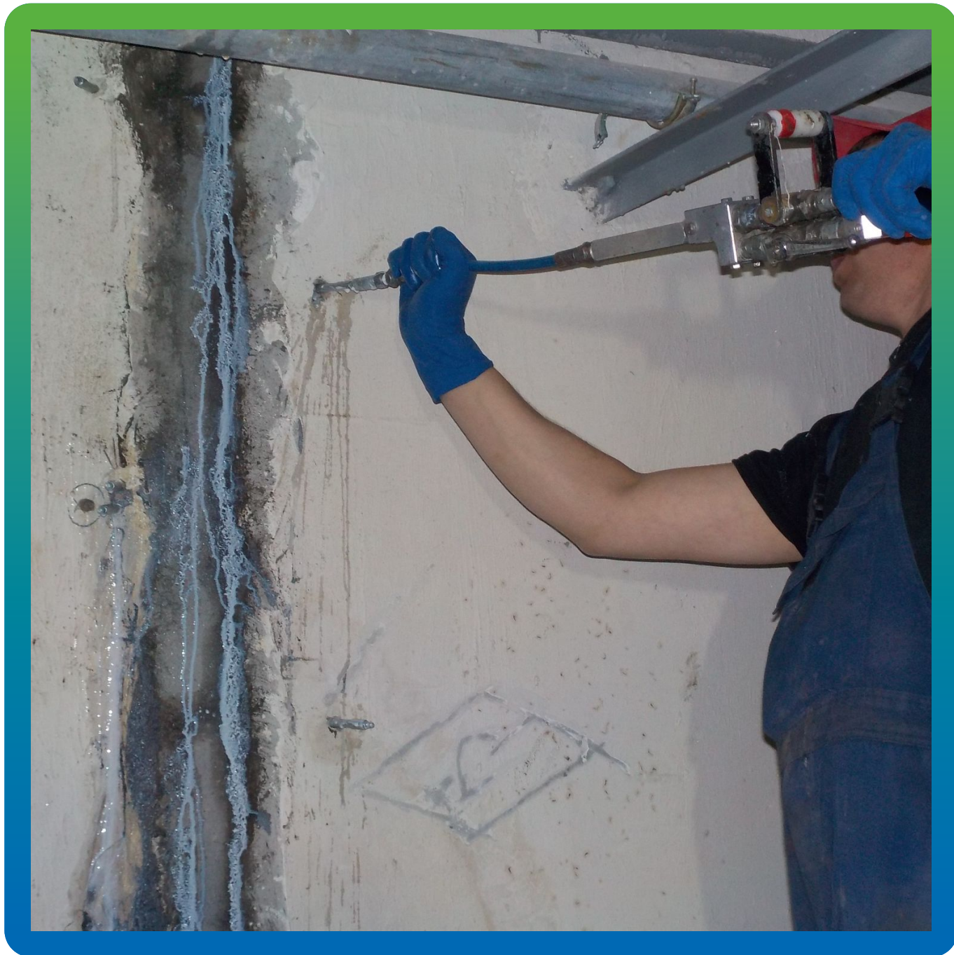
Инъектирование Манокрил Гель В с Манокрил Флекс через пакер
