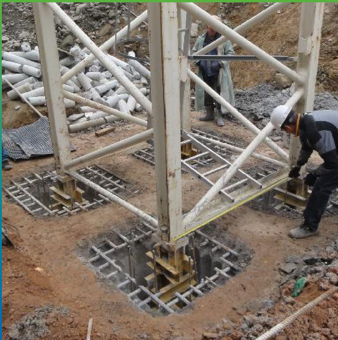
Основание башенного крана
