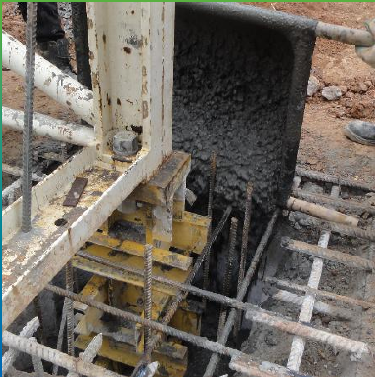
Анкеровка основания крана спомощью Стармекс ФМ7
