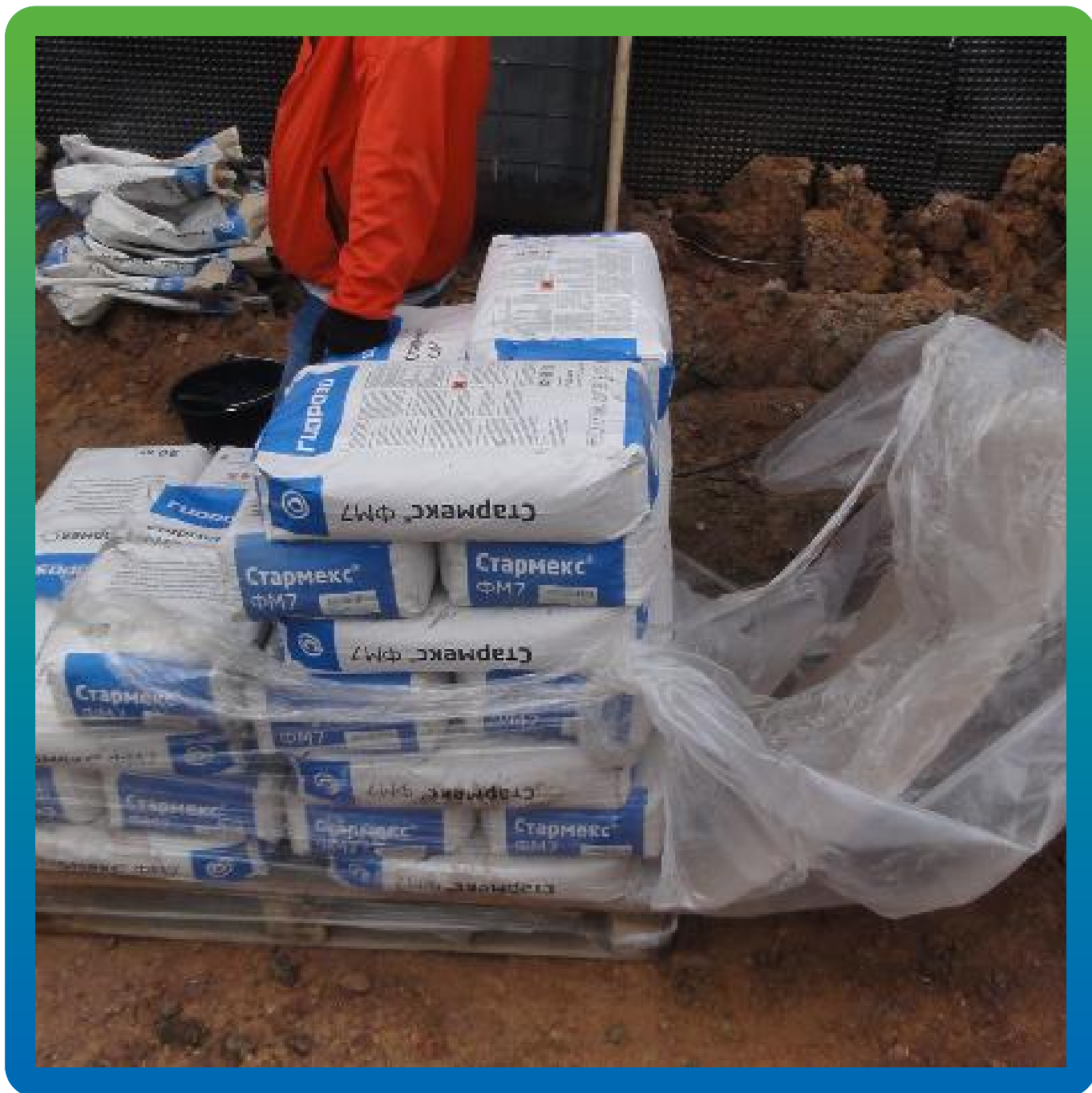
Безусадочный подливочный состав Стармекс ФМ7 на объекте
