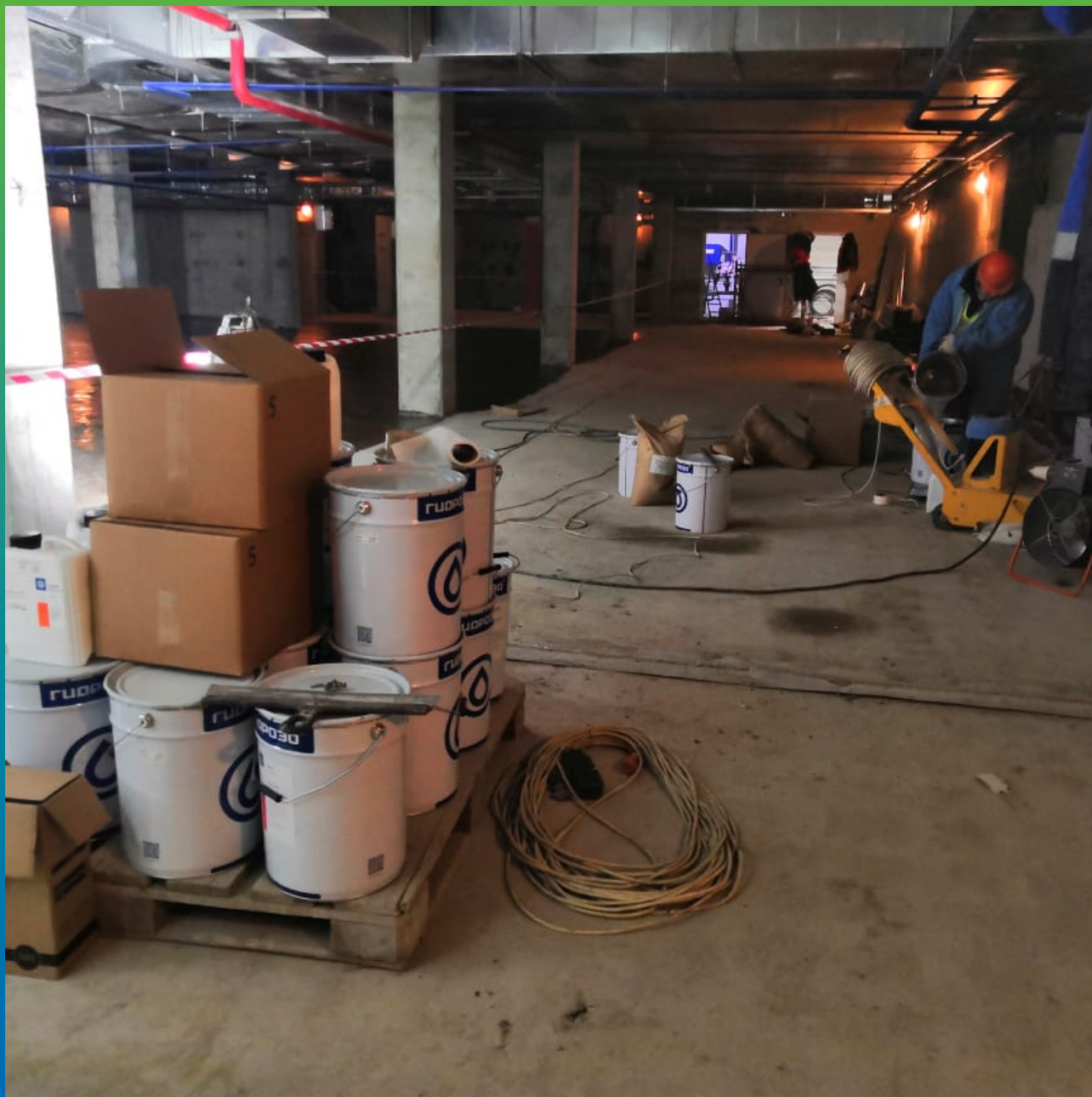
Материалы Гидрозо на объекте
