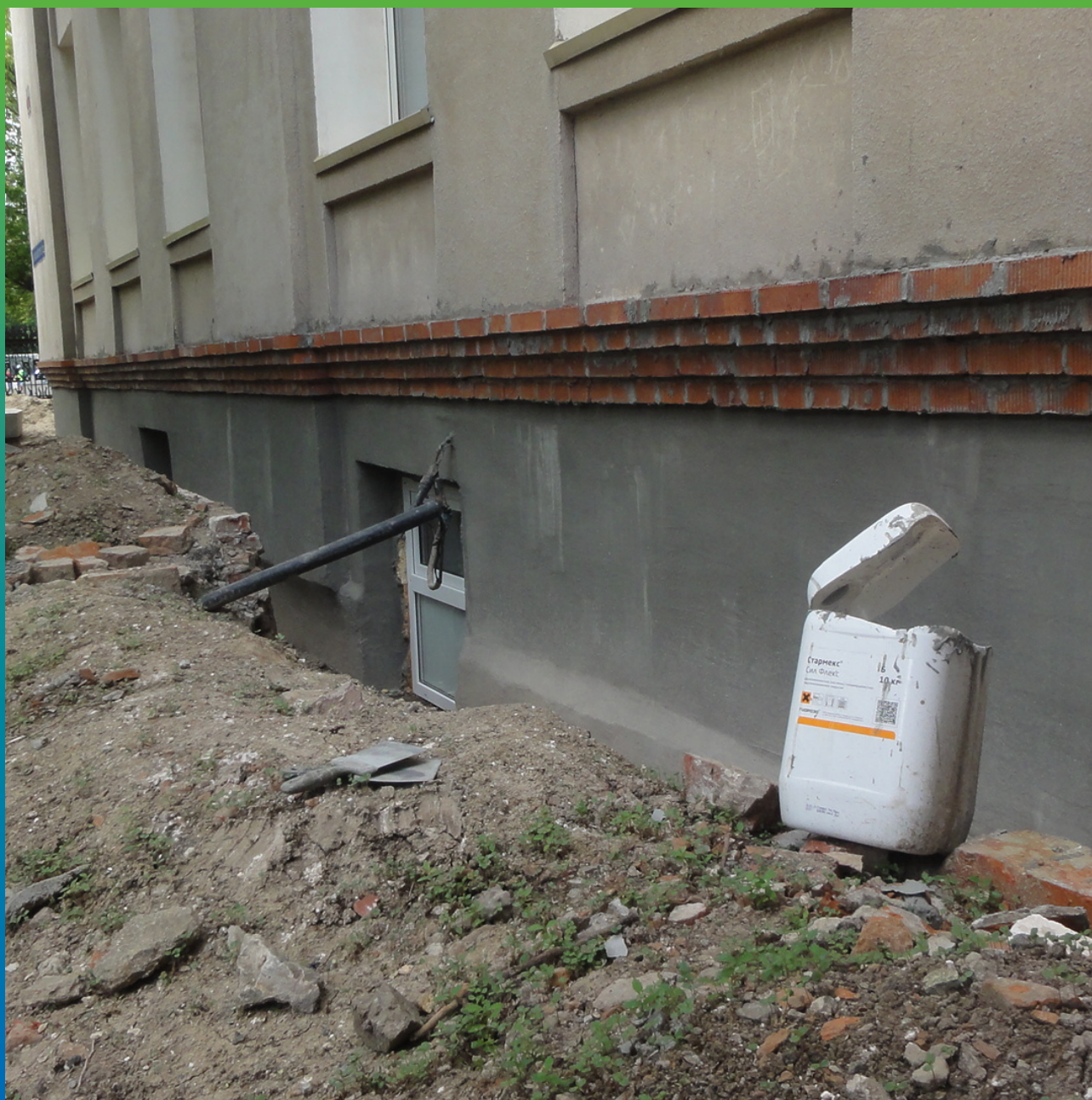
Финальный вид. Цокольная часть обработана эластичным гидроизоляционным составом Стармекс Сил Флекс
