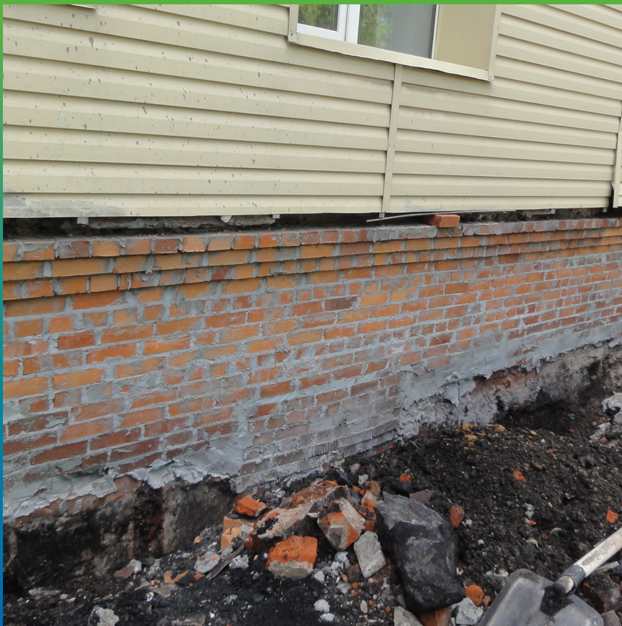
Вид отремонтированной кладки цоколя
