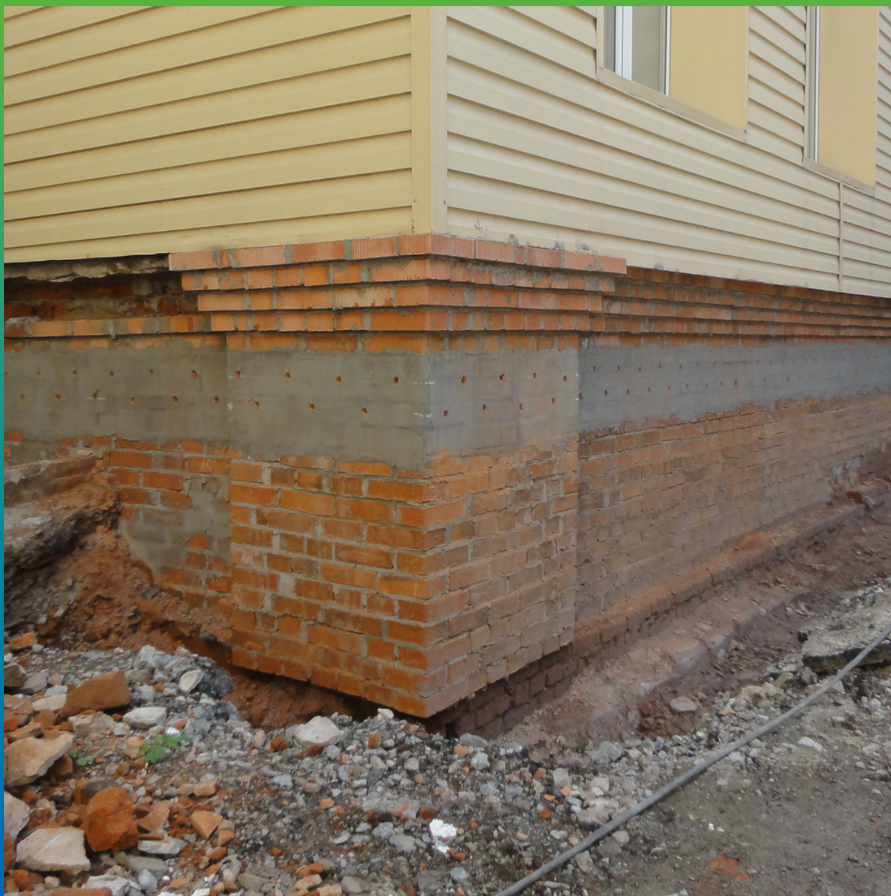
Вид готовых шпуров под инъектирование составом Маноцем Гроут
