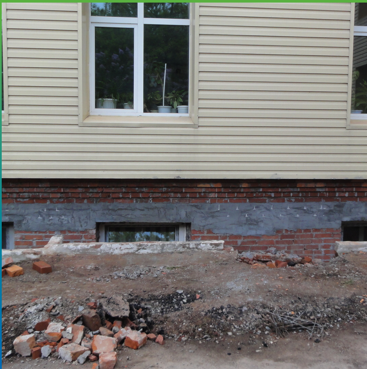
Разметка под устройство шпуров, кирпич оштукатурен с помощью Стармекс РМЗ
