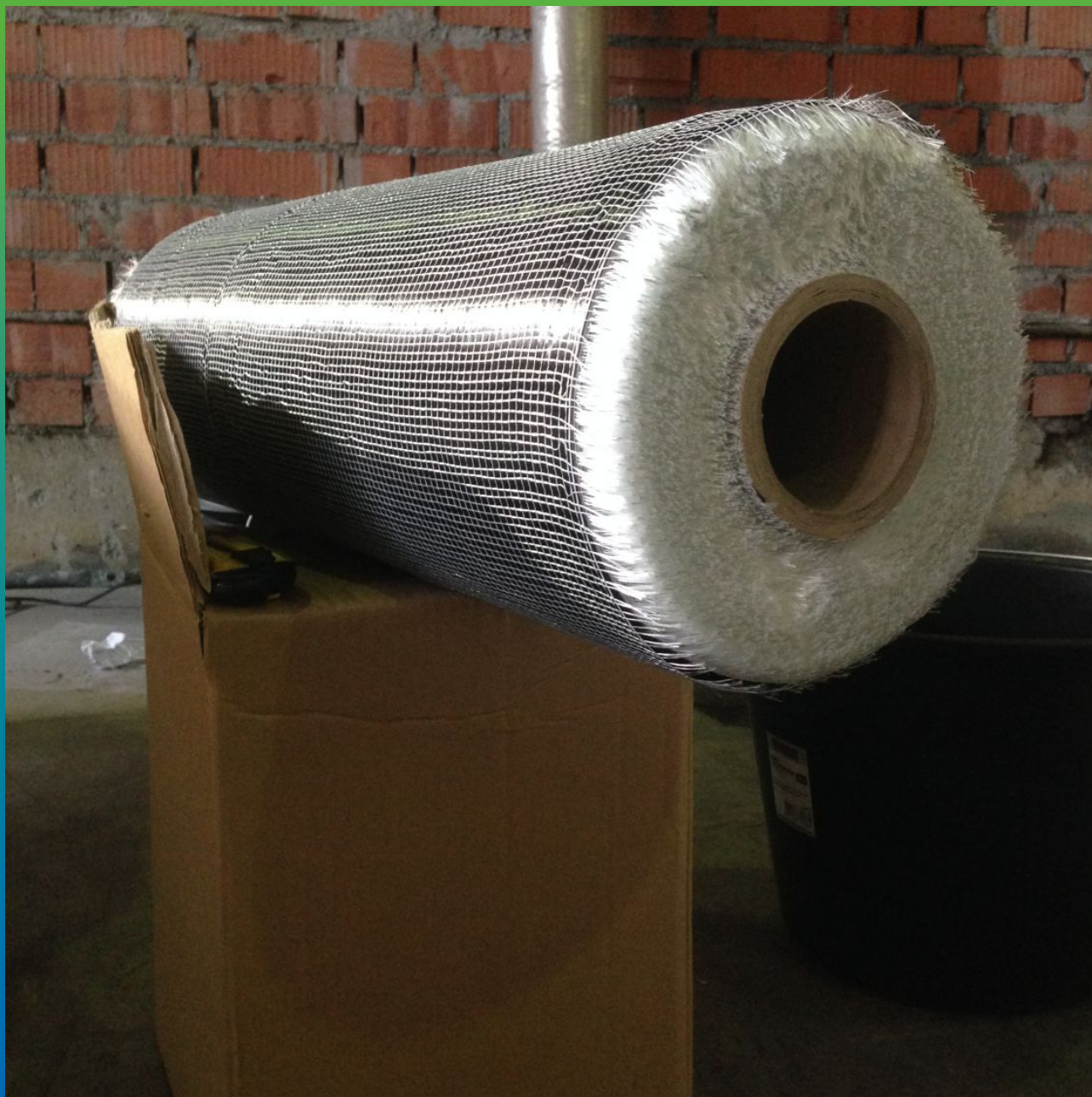
Материалы на рабочем месте. Углеродные холсты Армошел системы КСУ
