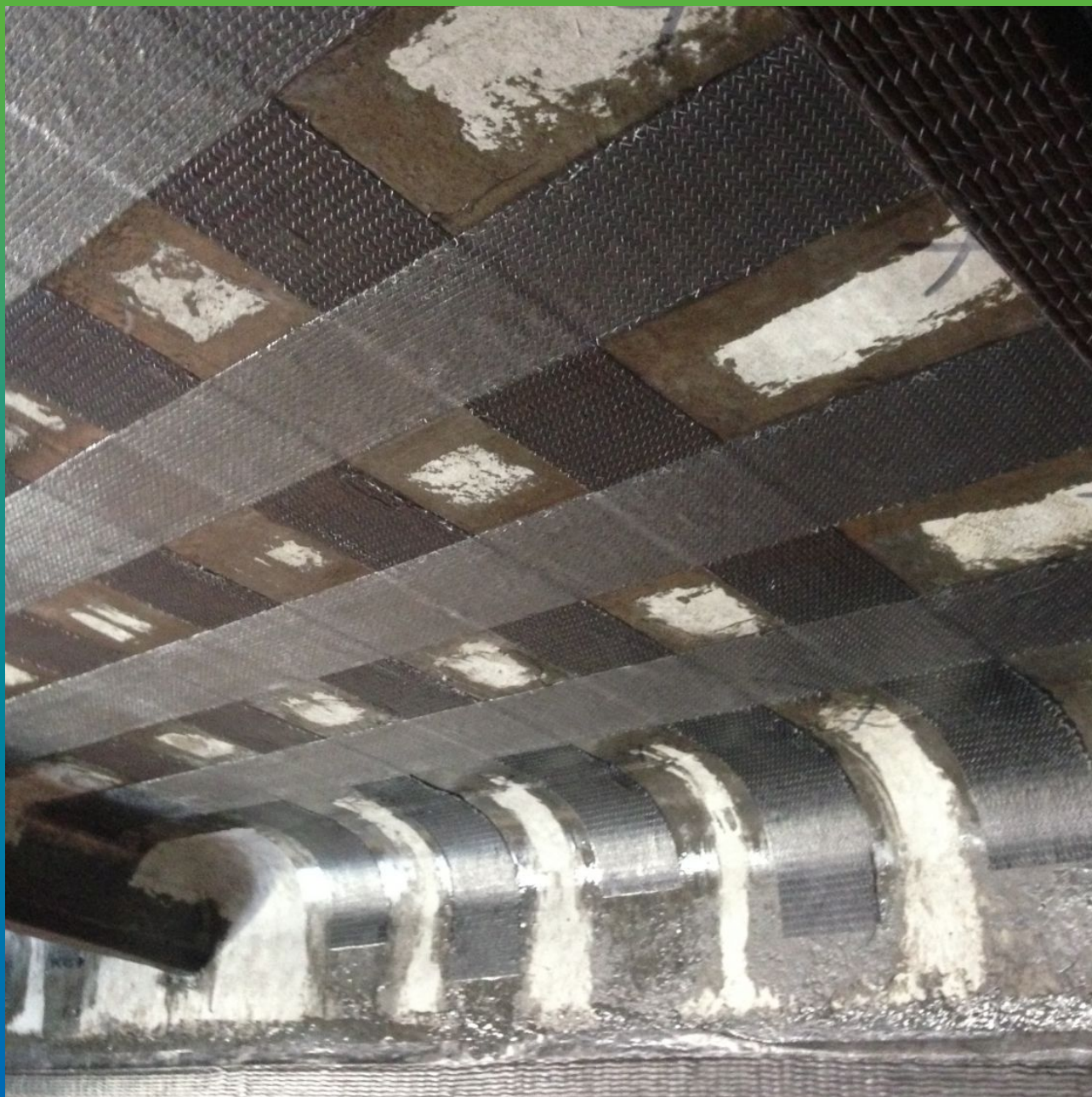
Внешний вид смонтированной поверхности
