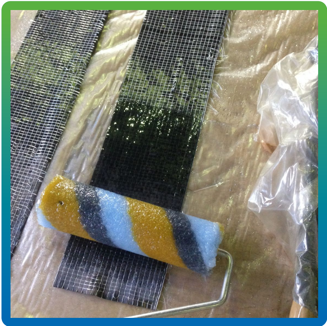
Подготовка материала. Пропитка эпоксидным составом Манопокс 372
