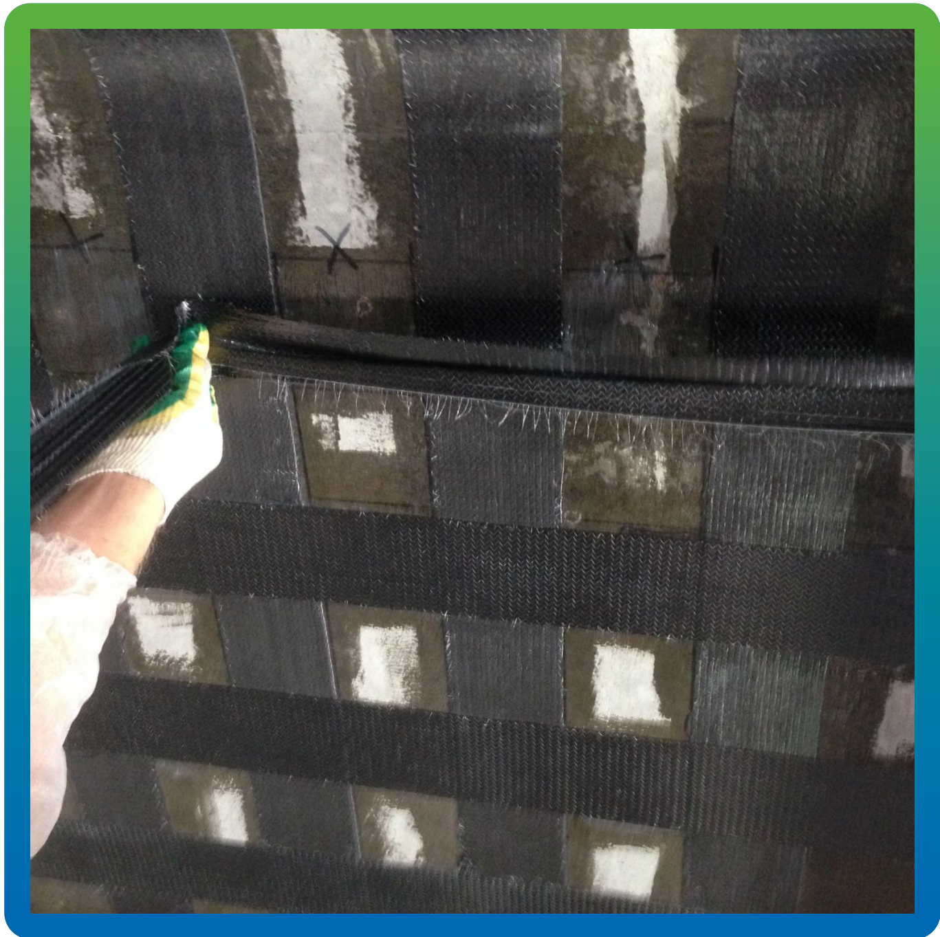
Монтаж пропитанного углеродного волокна
