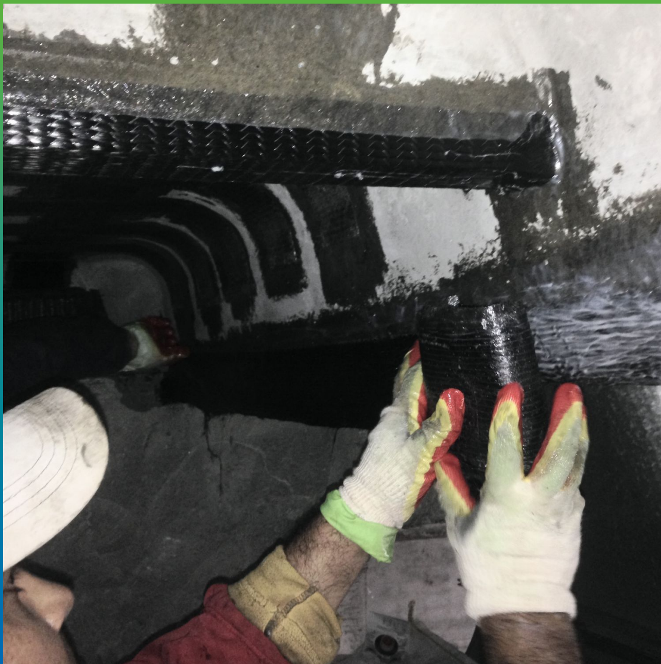
Монтаж третьего слоя холста Армошел
