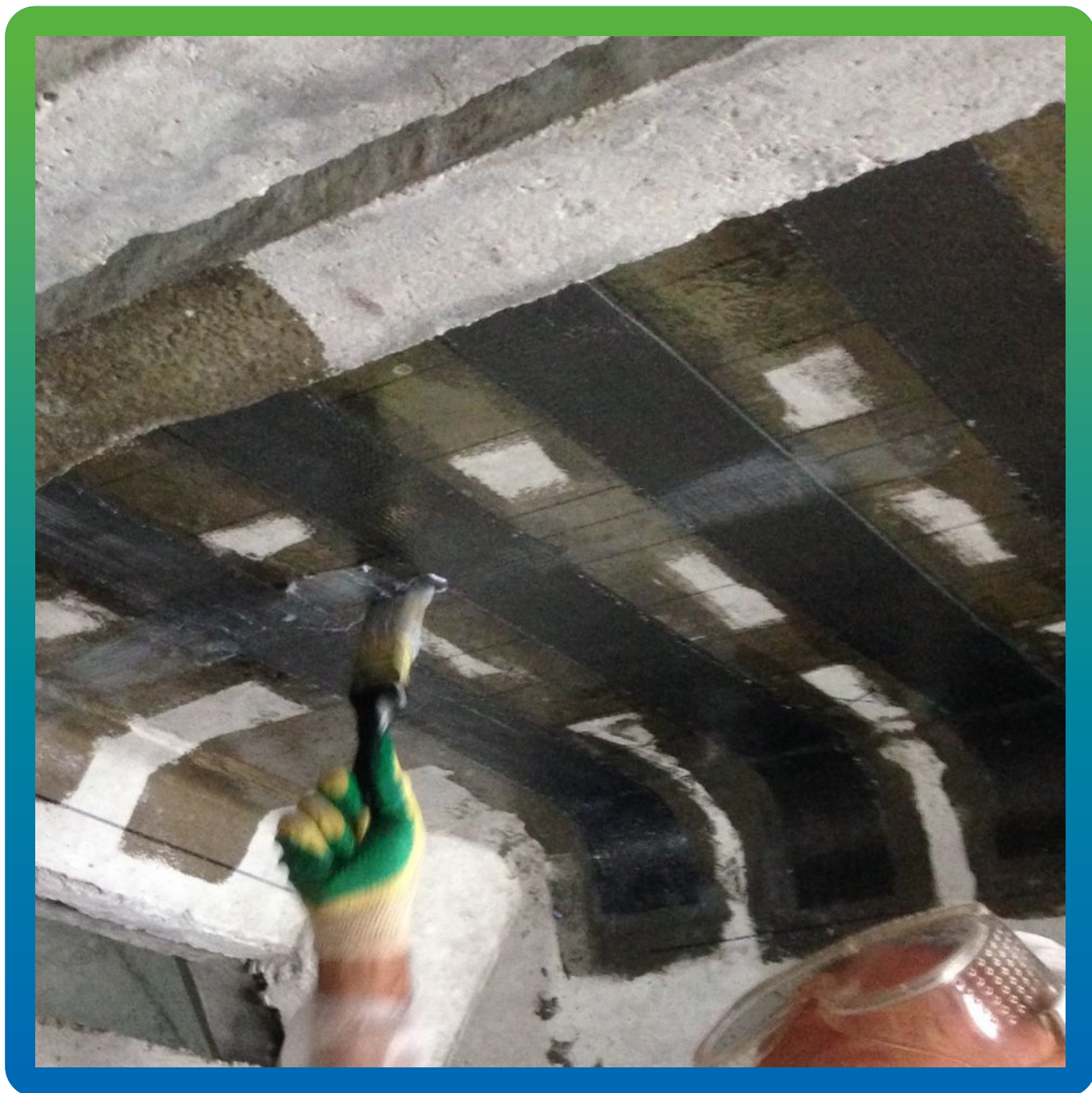
Нанесение загущенного клея Манопокс 372 на загрунтованное основание
