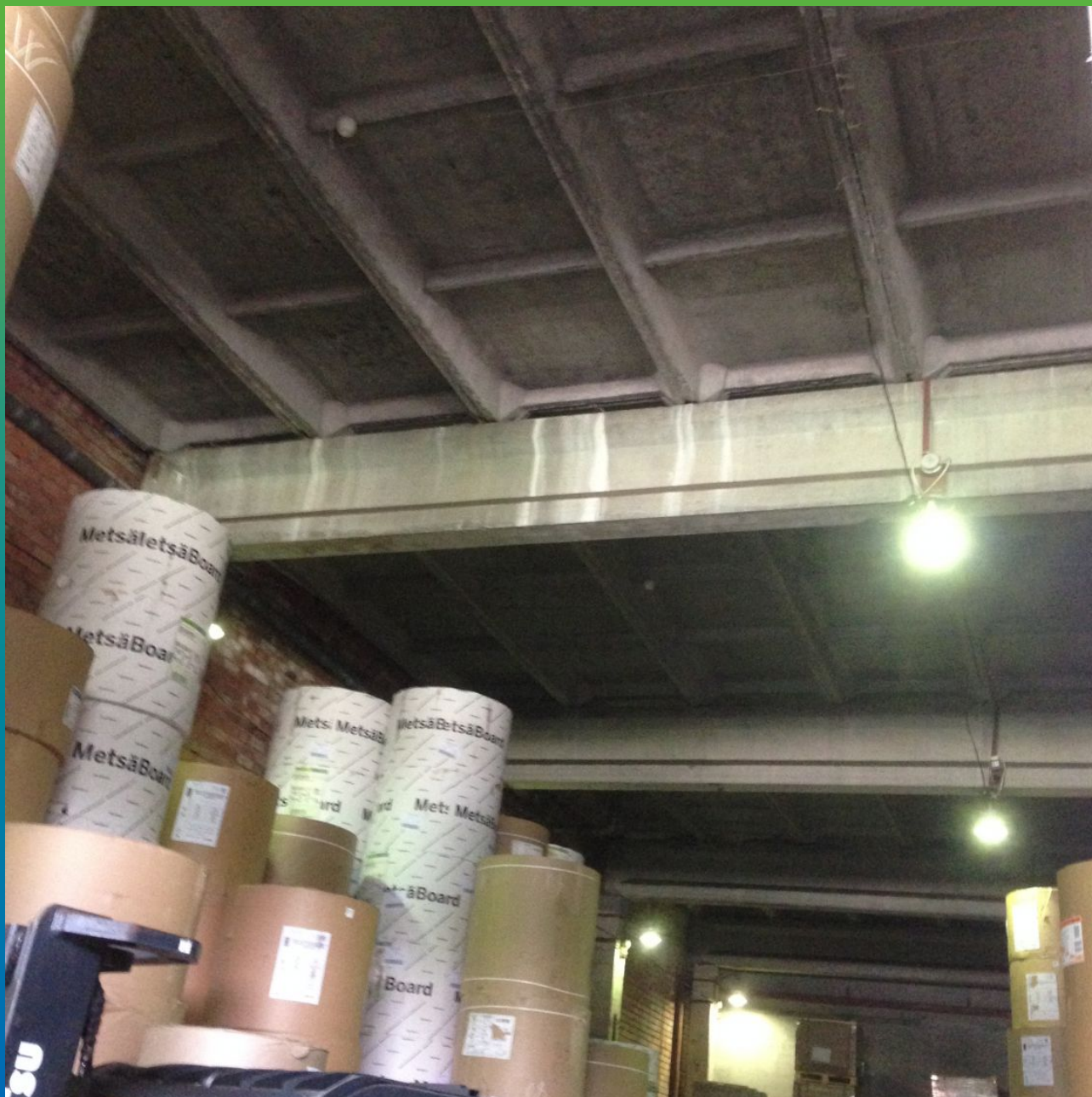
Частный вид. Усиляемые плиты покрытия при перепрофилировании части здания
