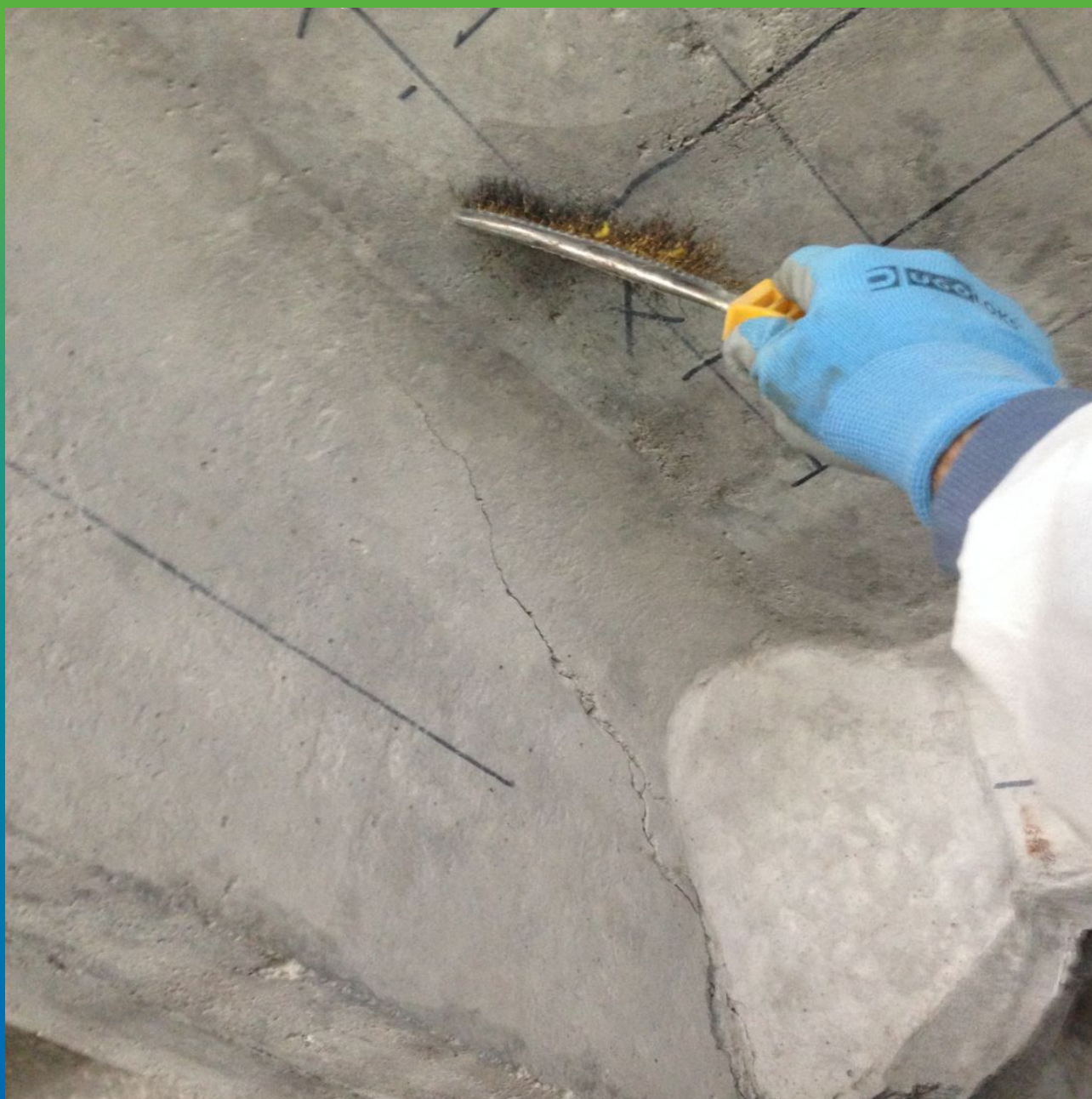
Подготовка основания. Очистка структурно не прочных слоев.
