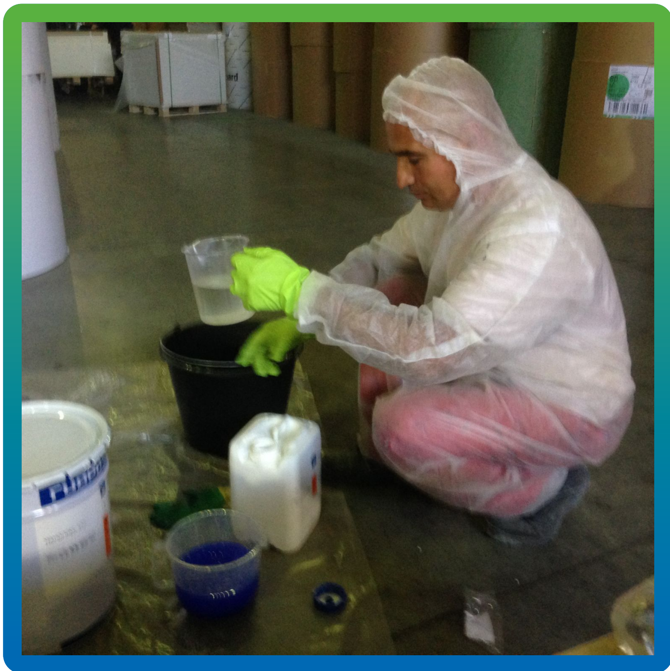
Подготовка материалов. Замешивание Манопокс 372
