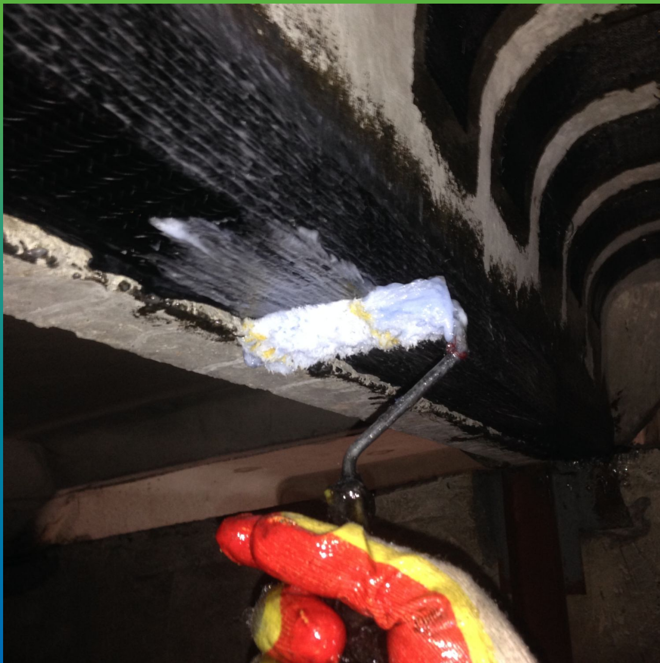
Межслойное нанесение Манопокс 372 + Манопокс Тикс
