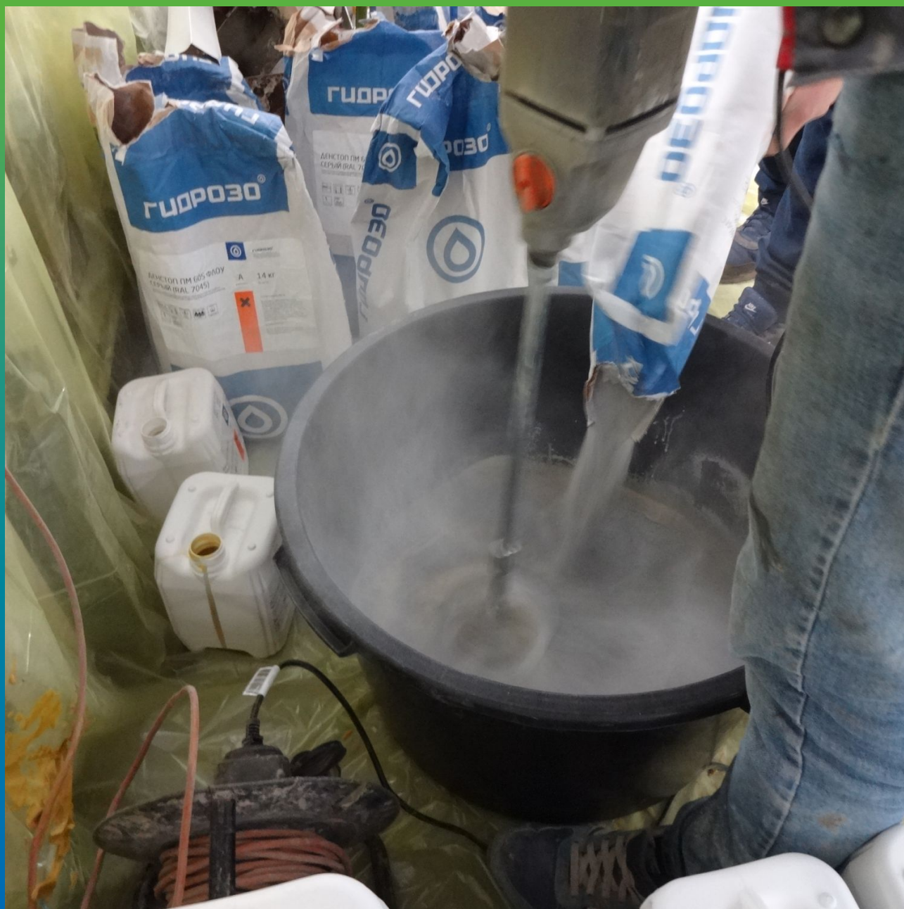
Смешивание 3-х компонентного полимерцементные покрытия ДенсТоп 605 Флоу
