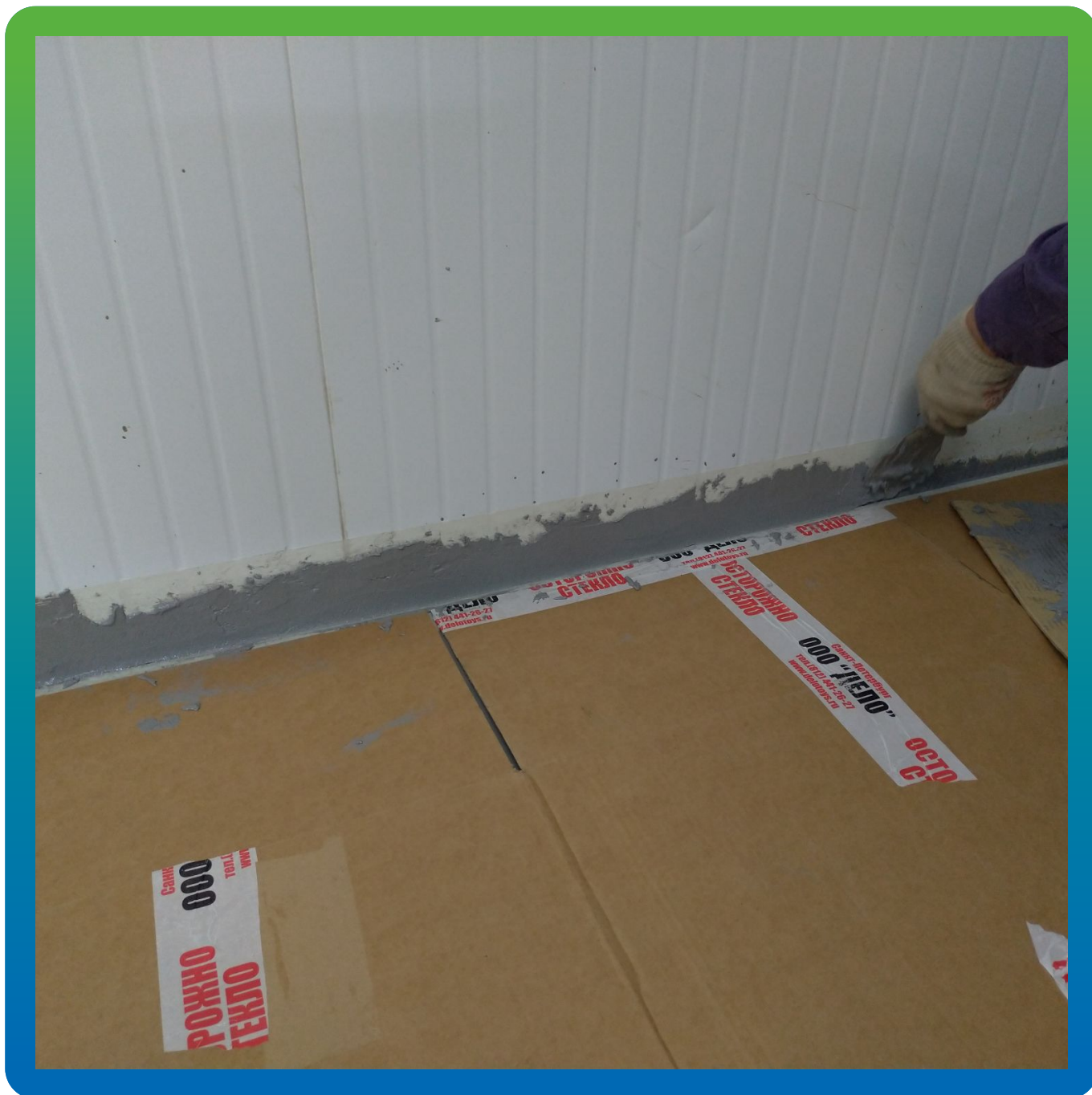
Устройство плинтусов в морозильных камерах
