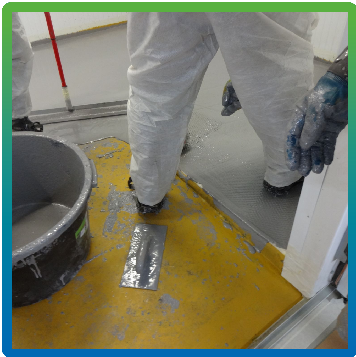
Удаление мельчайших пузырьков игольчатым валиком
