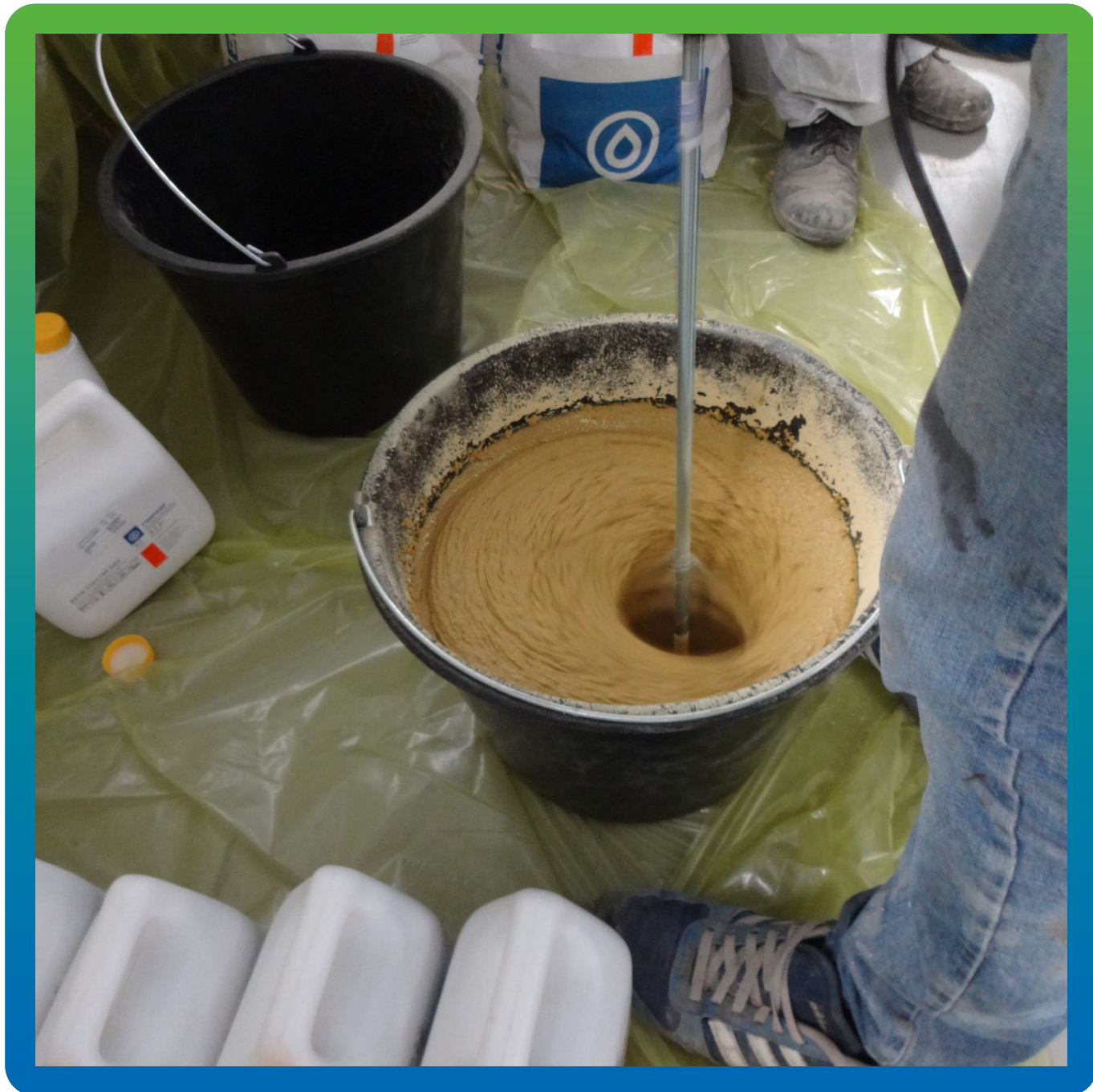
Тщательное перемешивание компонентов грунтовочной системы
