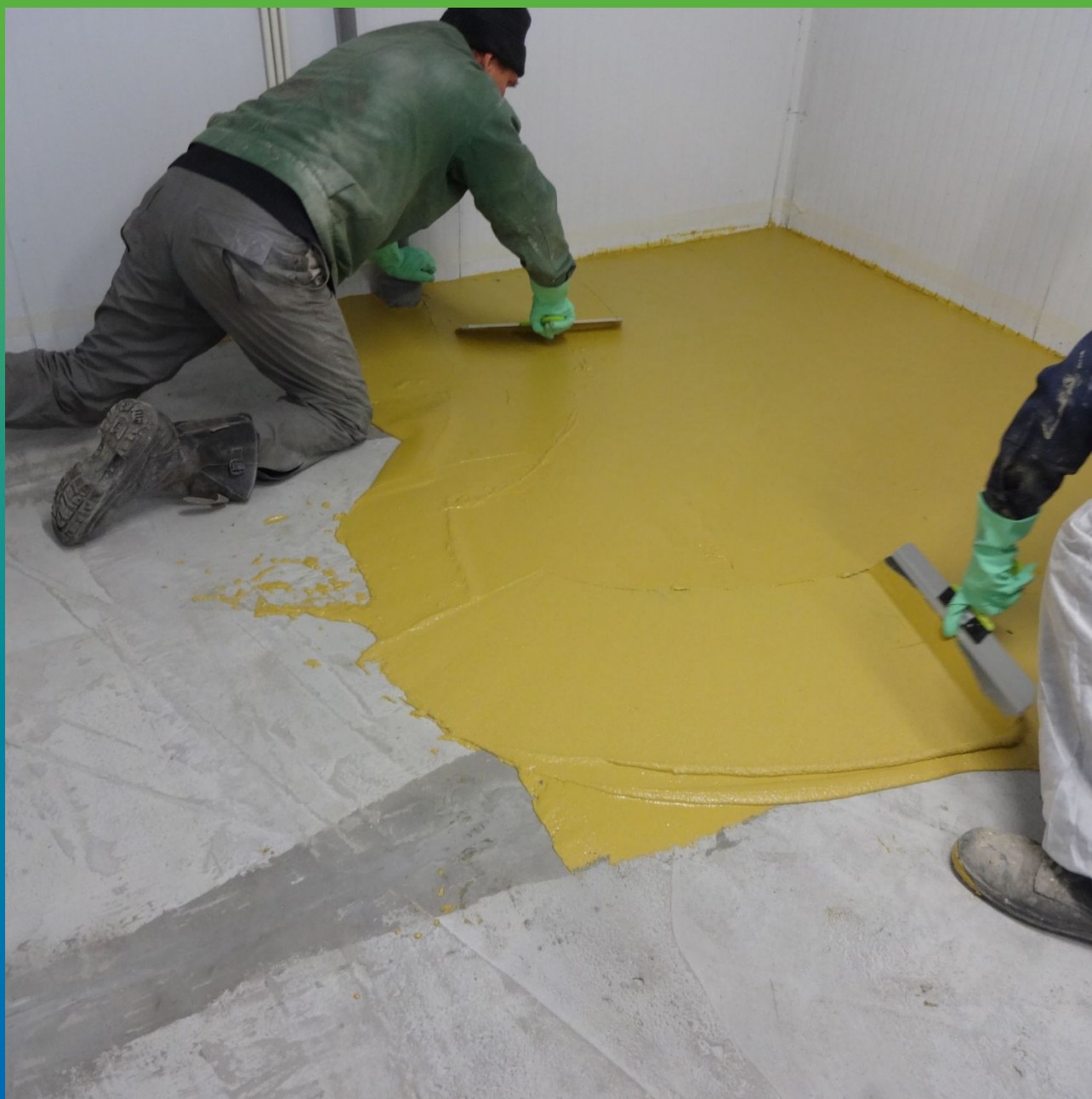
Нанесение шпателями грунта ДенсТоп ПМ 601
