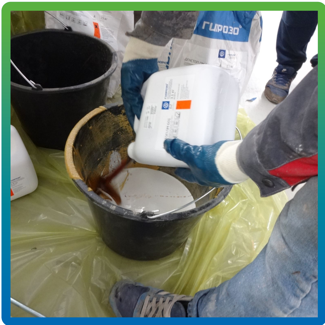
Приготовление 3-компонентного грунтовочного состава ДенТоп ПМ 601
