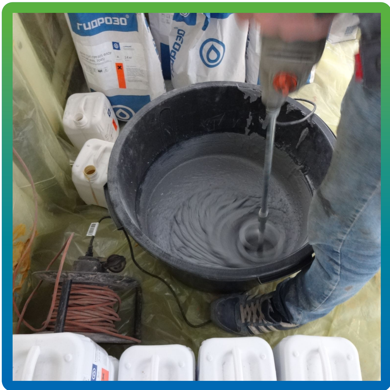
Тщательное перемешивание компонентов
