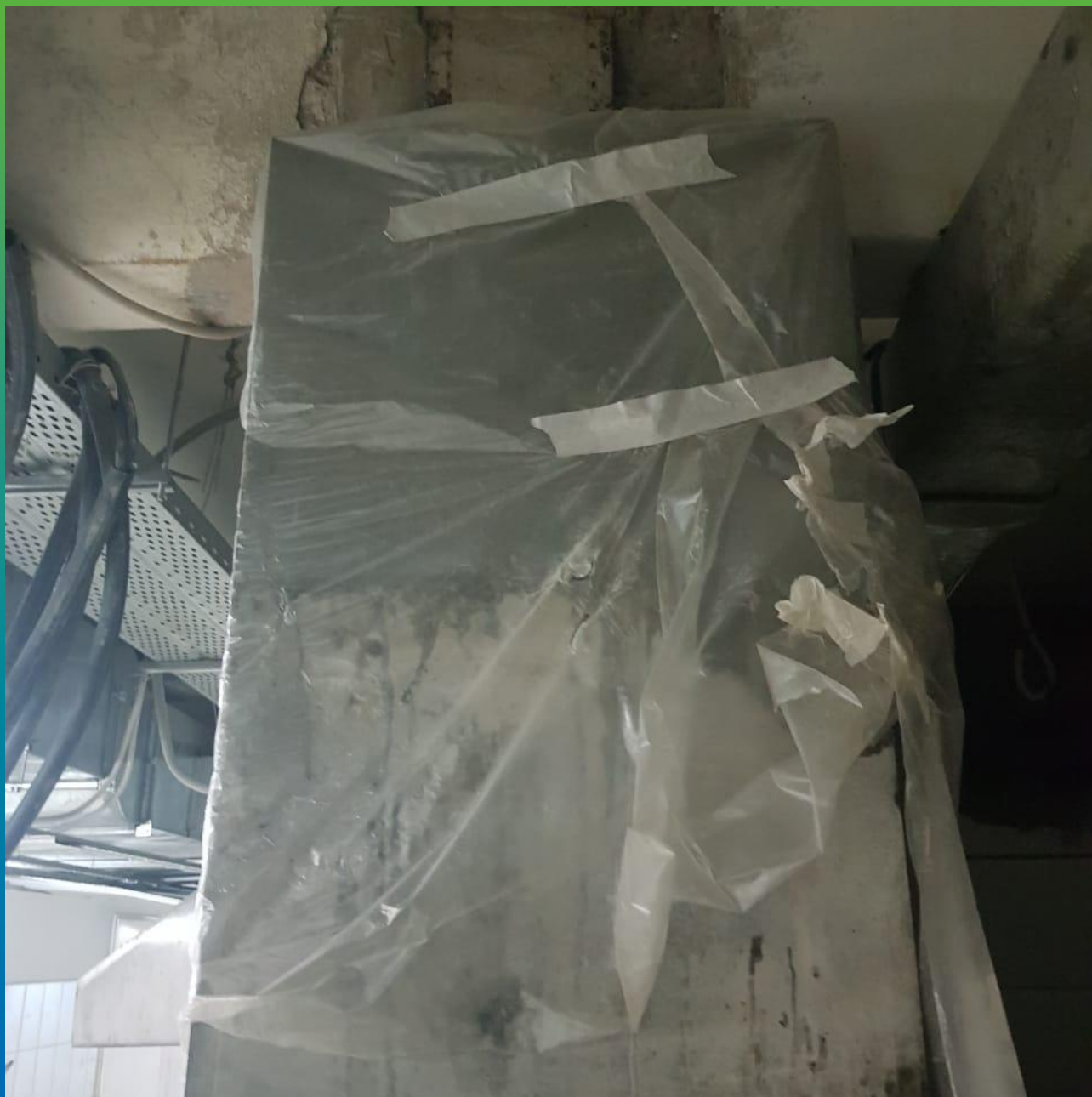
Вид усиленной колоны Стармекс ФМ 7
