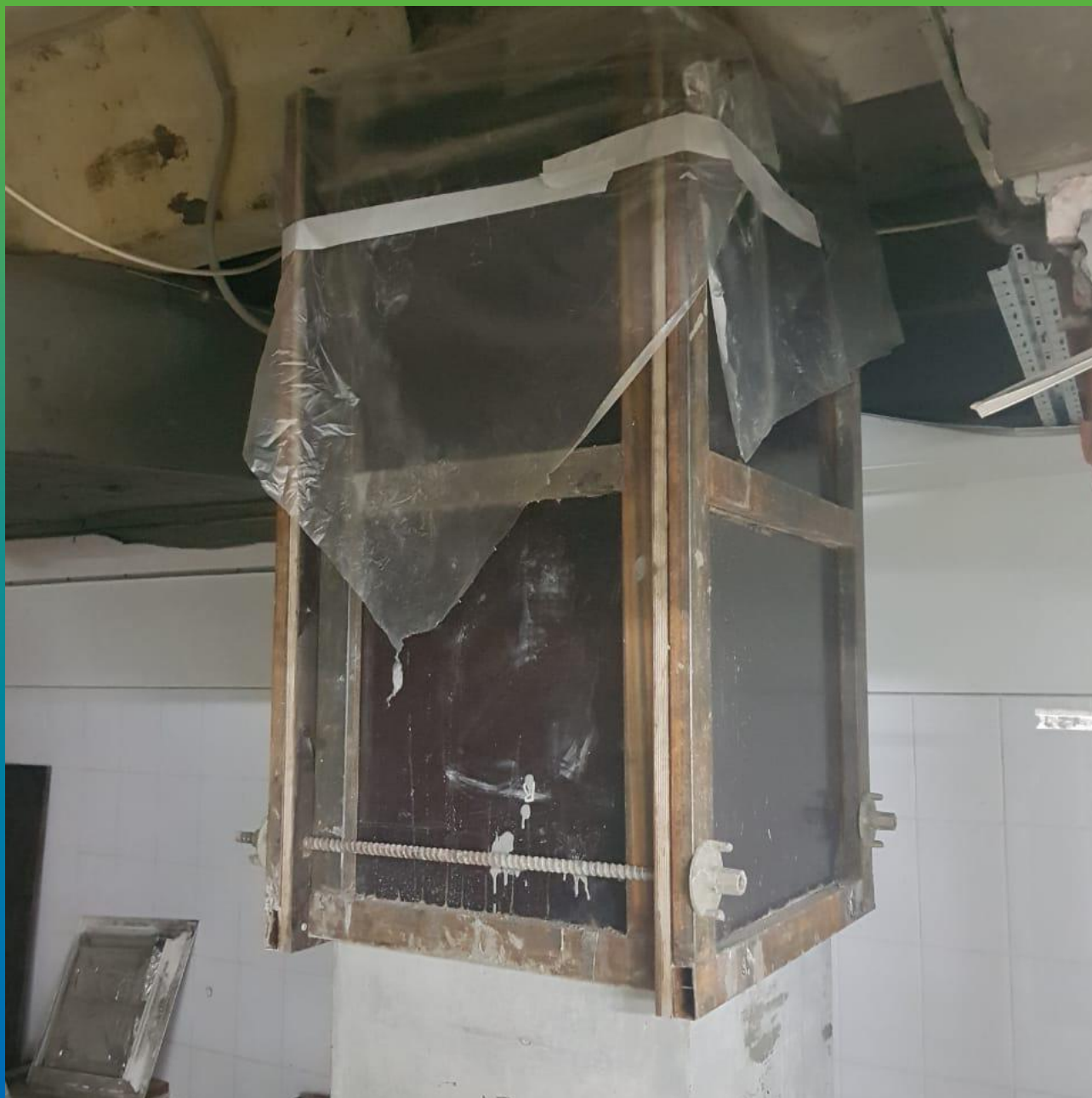
Подготовка колоны перед усидением Стармекс ФМ 7
