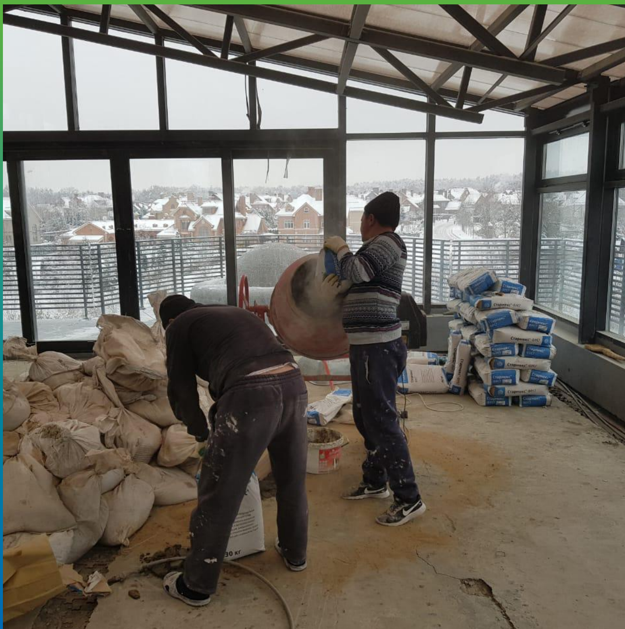
Подготовка раствора Стармикс ФМ 7
