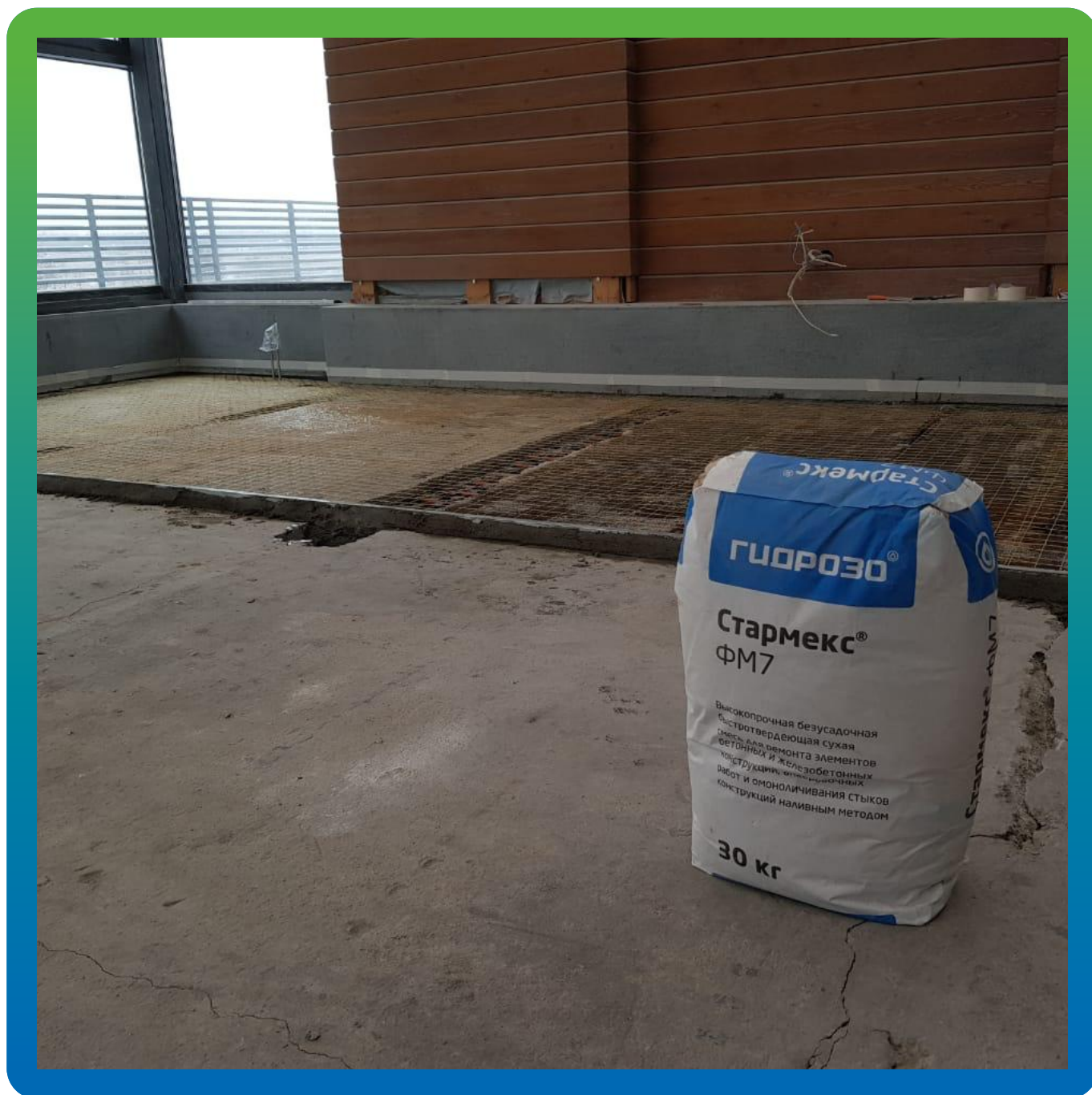
Материал Стармекс ФМ 7 на объекте
