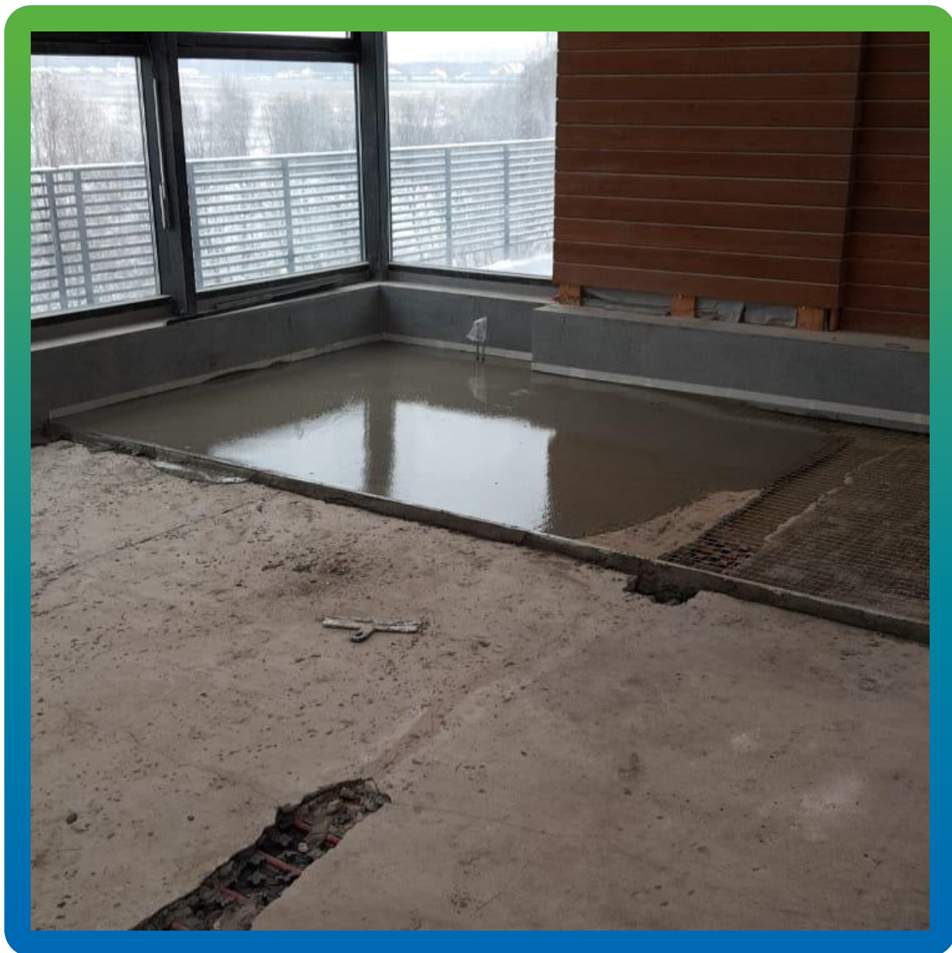
Устройство стяжки на кровли Стармекс ФМ 7
