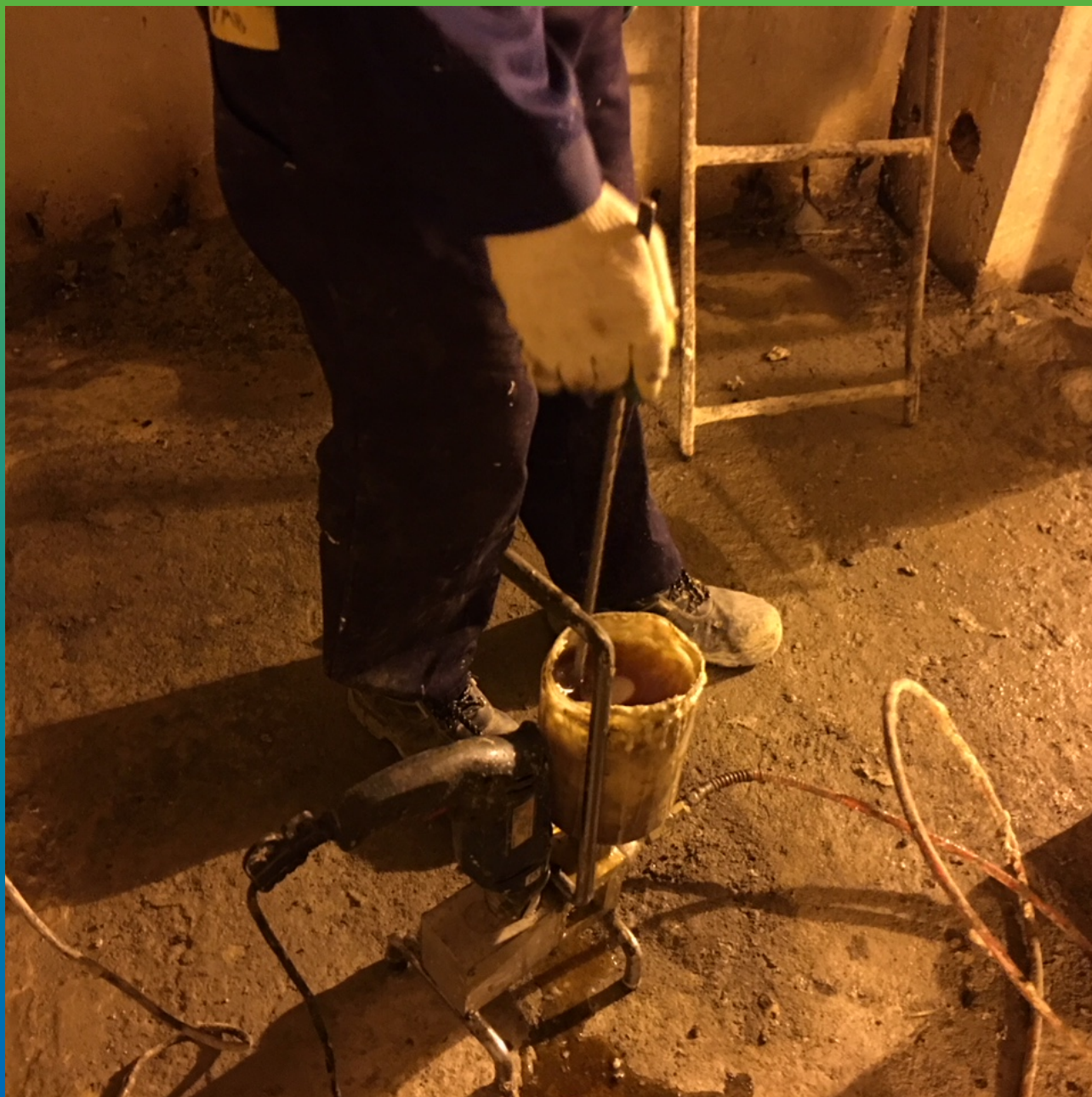
Подготовка к инъектированию Манопур 143
