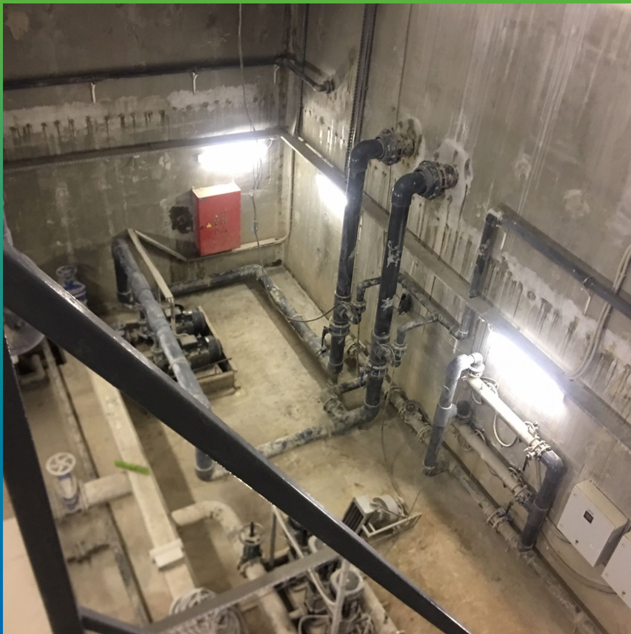
Общий вид отремонтированной КНС
