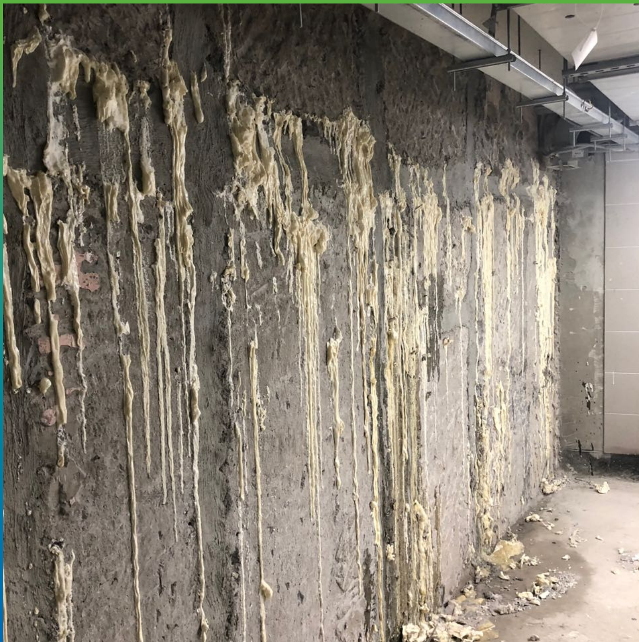
Трещины, после проведения двухстадийного инъецирования
