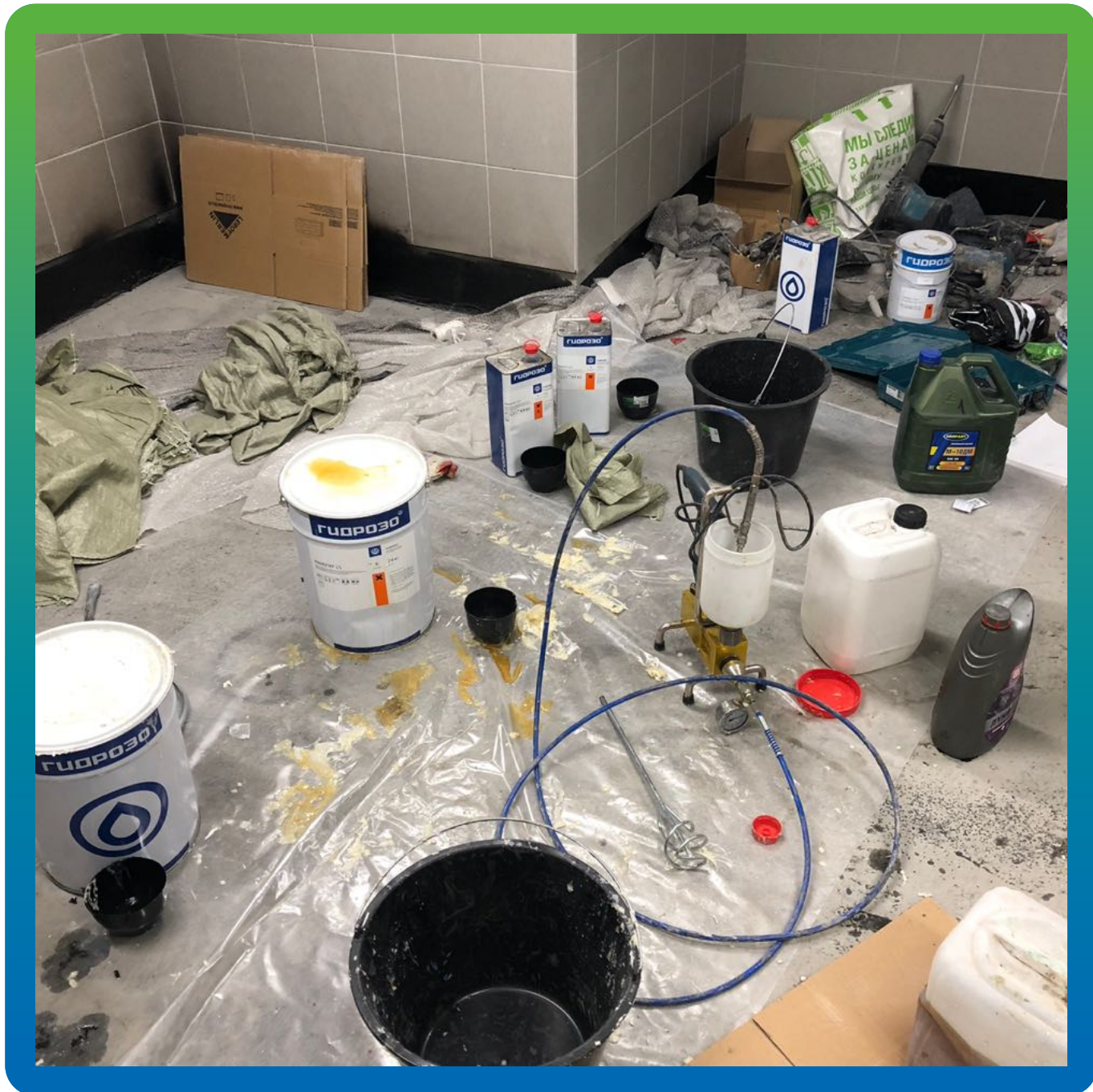
Подготовка материалов и оборудования перед инъектированием
