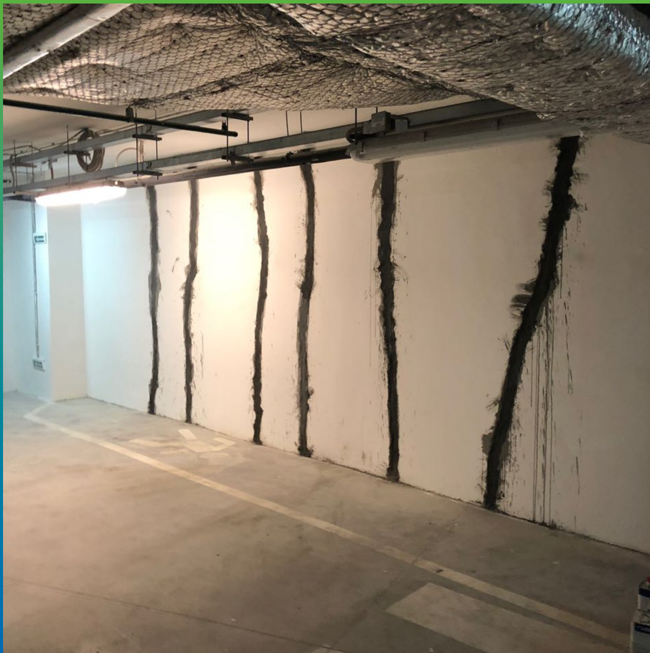
Финишный вид после проведения всех ремонтных работ.
