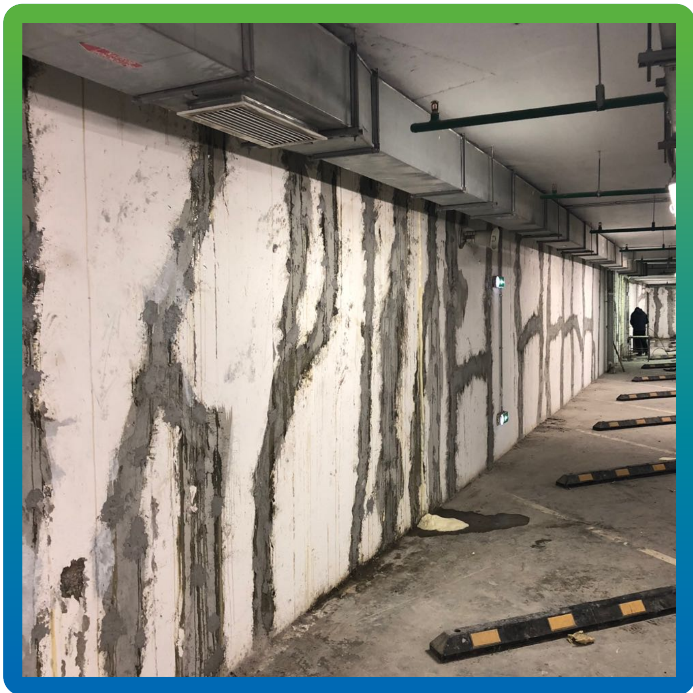
Трещины, после проведения двухстадийного инъецирования
