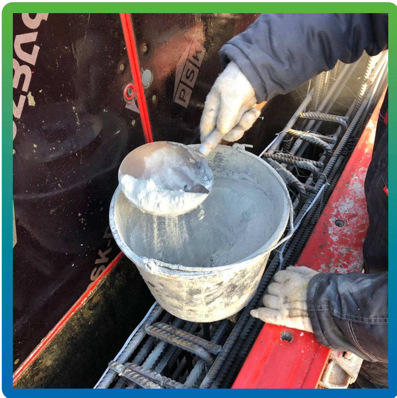
Гидроизоляция холодных швов методом просыпки, Стармекс Сил
