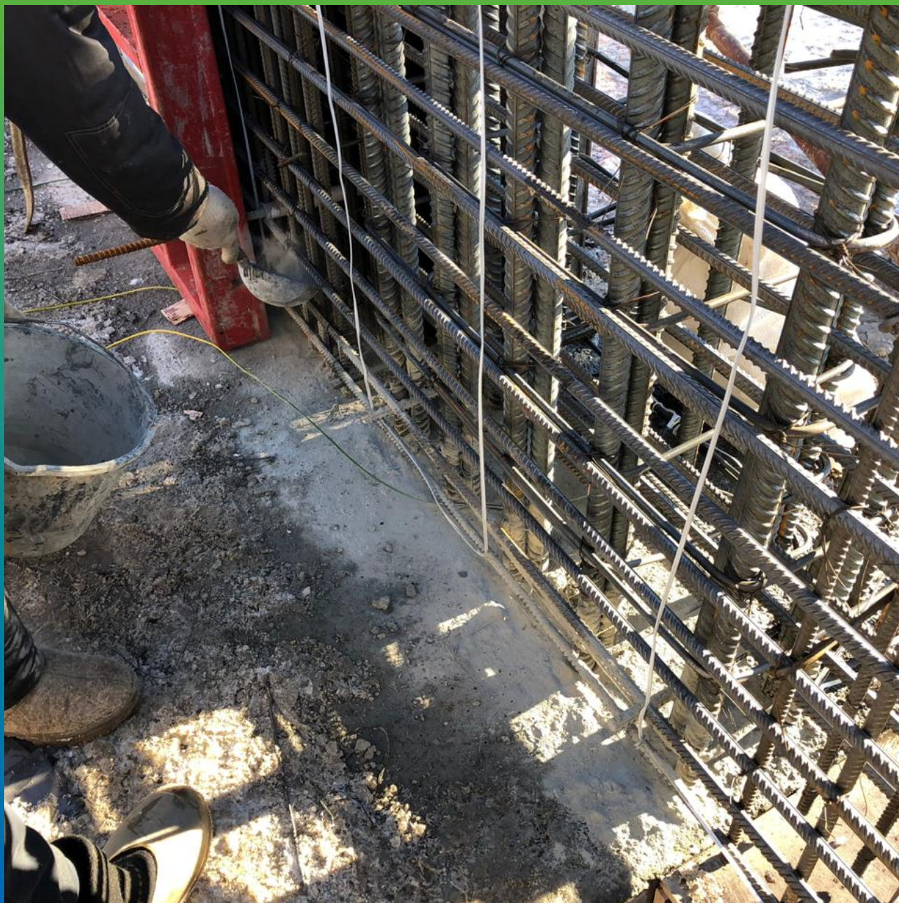
Гидроизоляция холодных швов методом просыпки Стармекс Сил.
