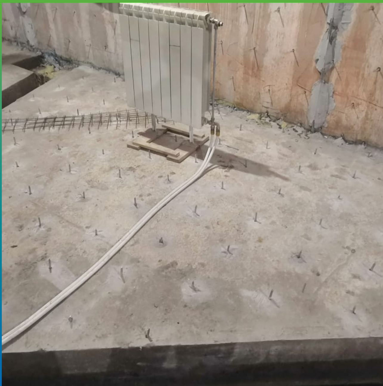
Подготовка к инъектированию.
