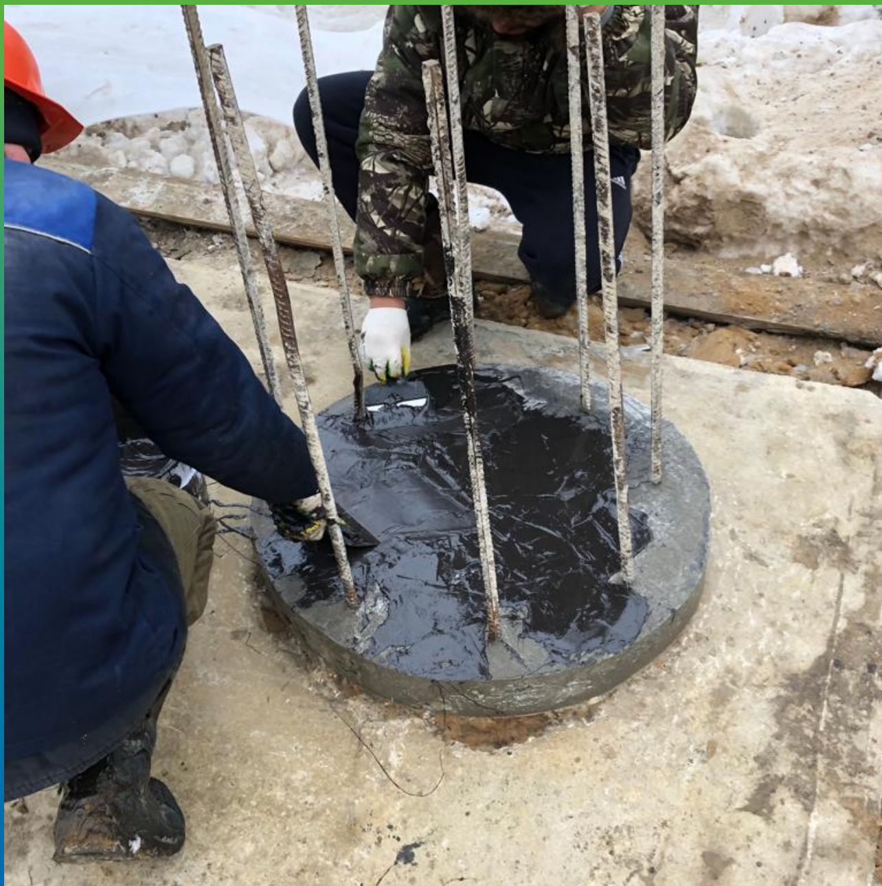
Нанесение ДенсТоп ПС 391
