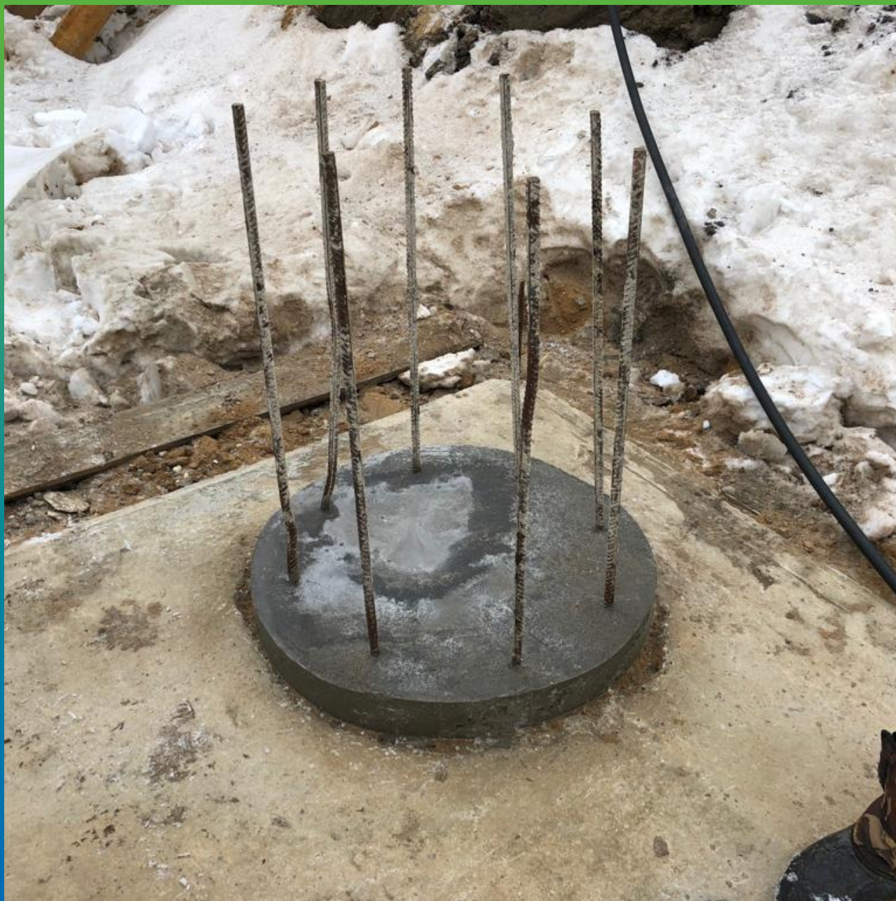
Подготовленное основание для нанесения ДенТоп ПС 391
