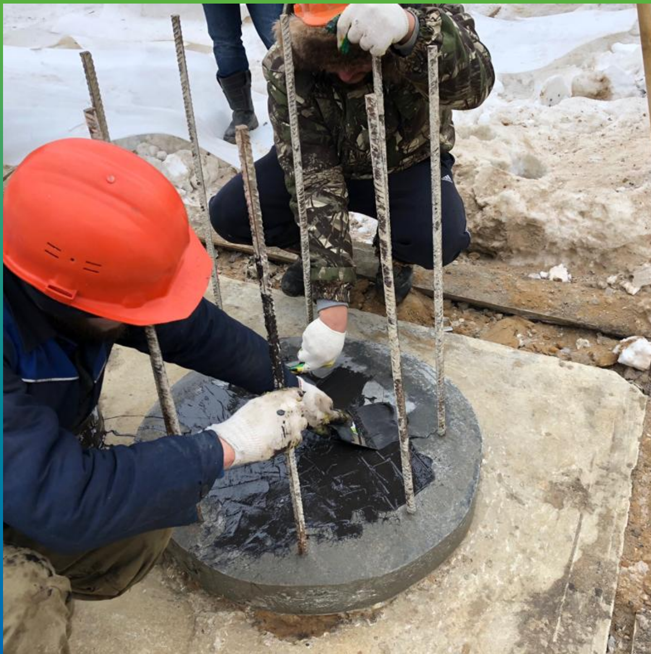
Нанесение ДенТоп ПС 391
