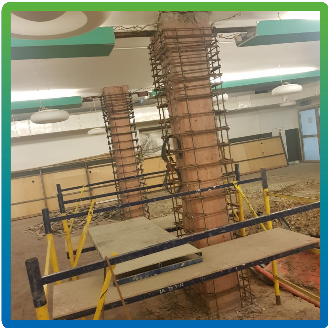
Подготовка к заливке Стармекс ФМ7
