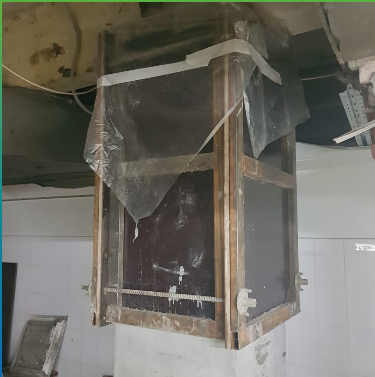
Подготовки опалубки для колонны
