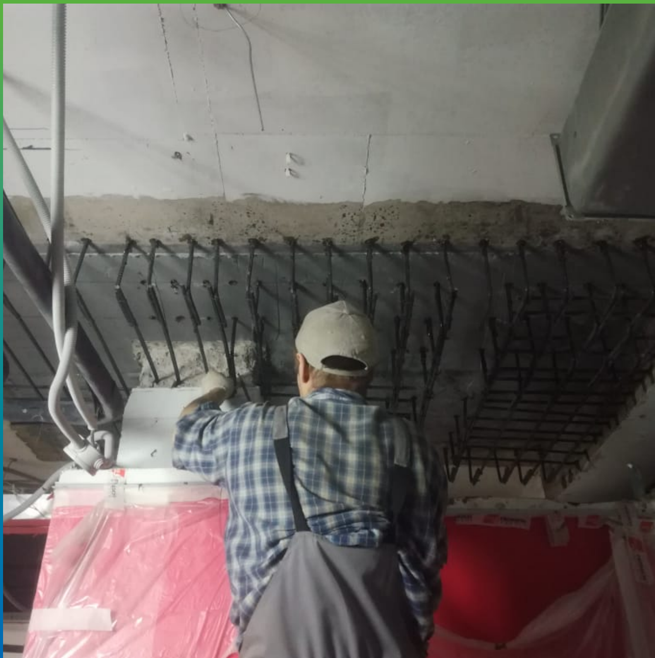
Подготовка к заливке Стармекс ФМ7
