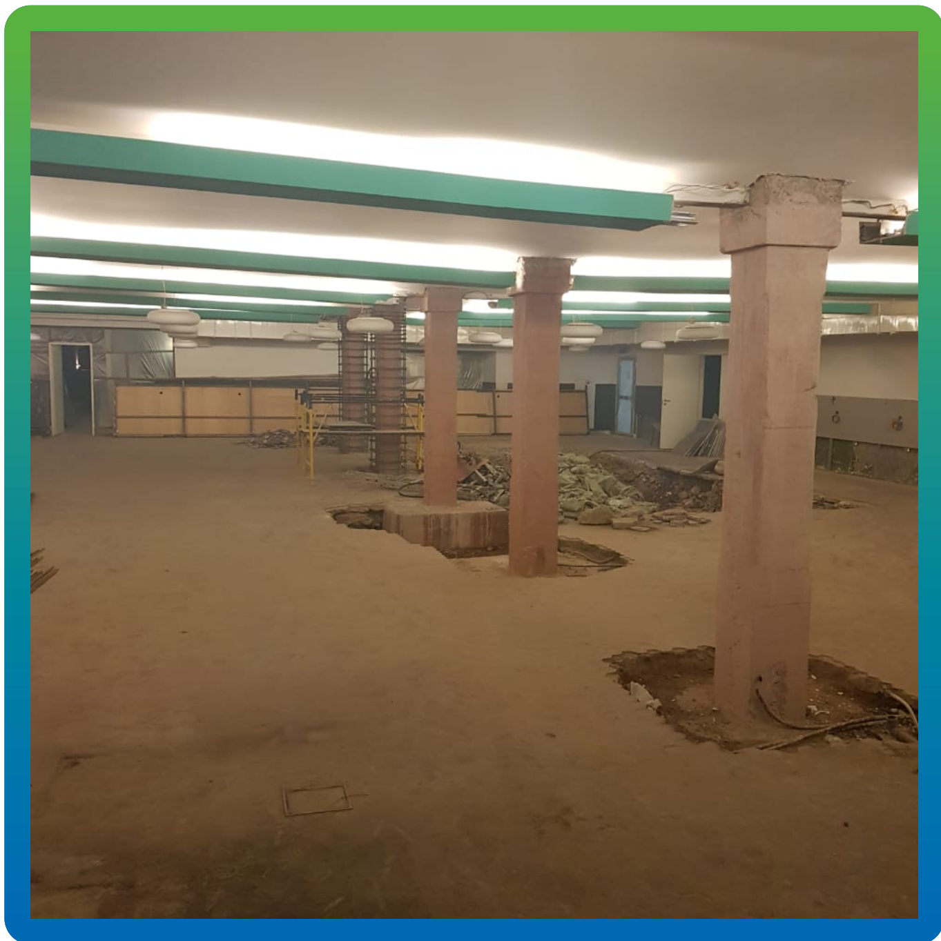
Подготовленные площади для ремонтных работ
