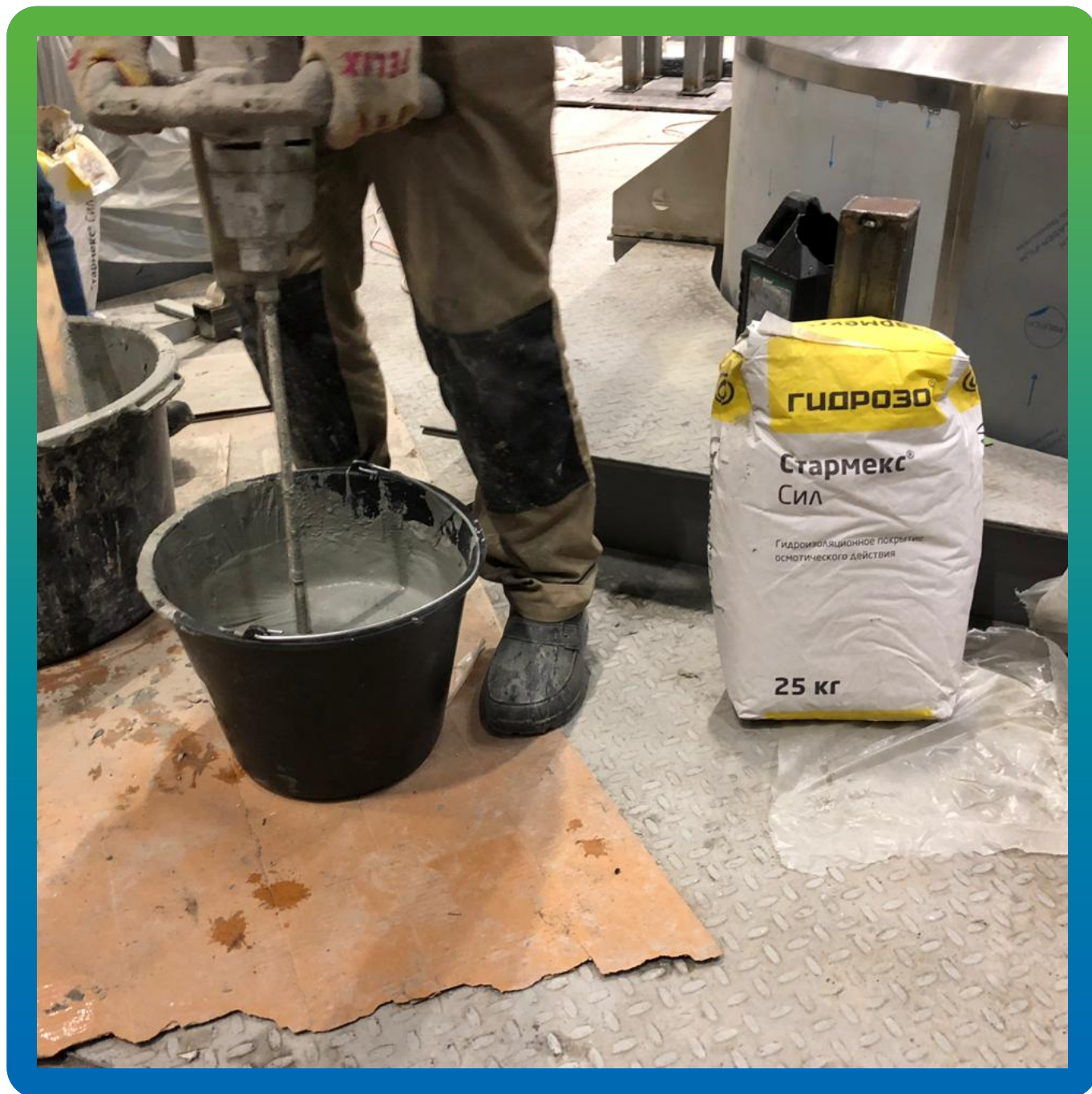
Подготовка гидроизоляционного состава Стармекс Сил
