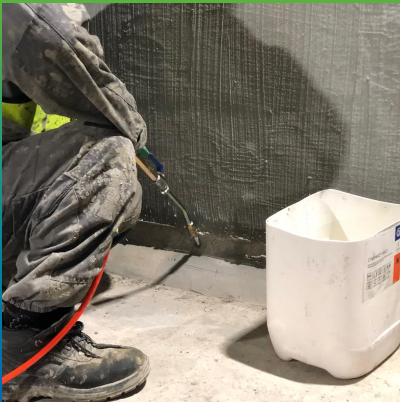
Инъектирование холодного шва составом Манопур 15
