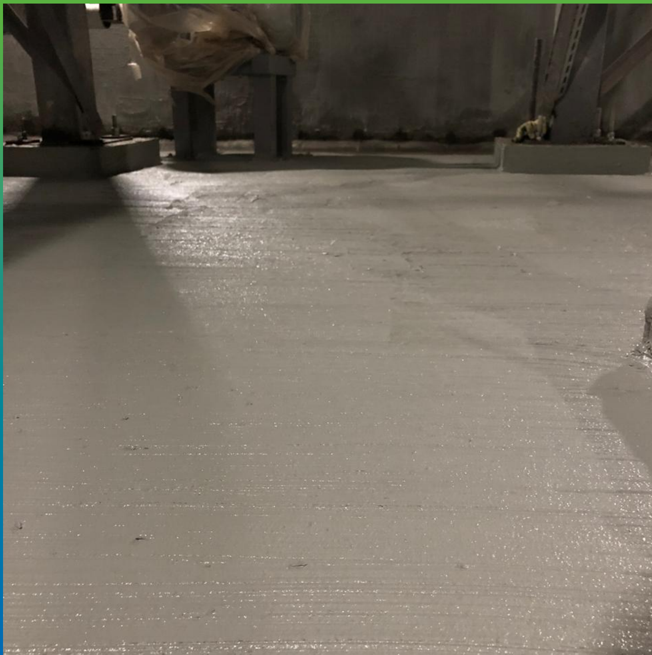
Внешний вид прогидроизолированной поверхности
