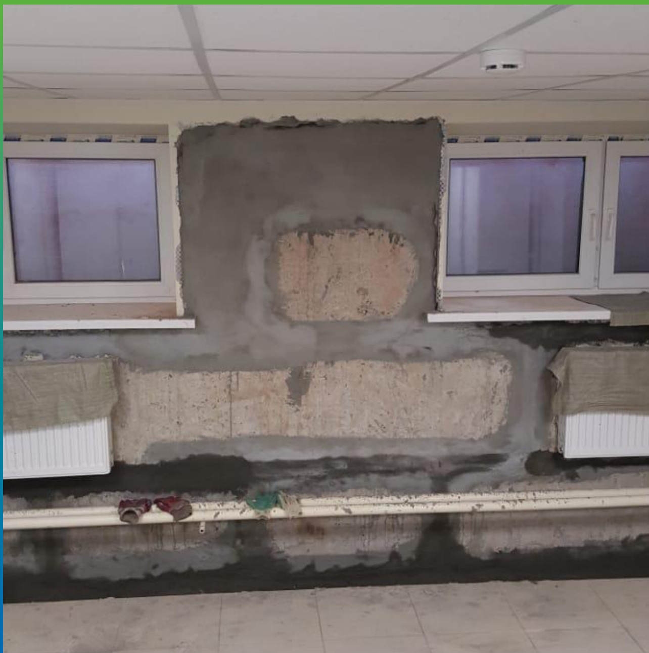
Зачеканенный шов высокопрочным безусадочным ремонтным составом Стармекс РМЗ
