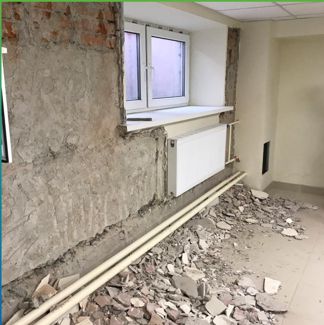
Подготовка основания под проведение гидроизоляционных работ
