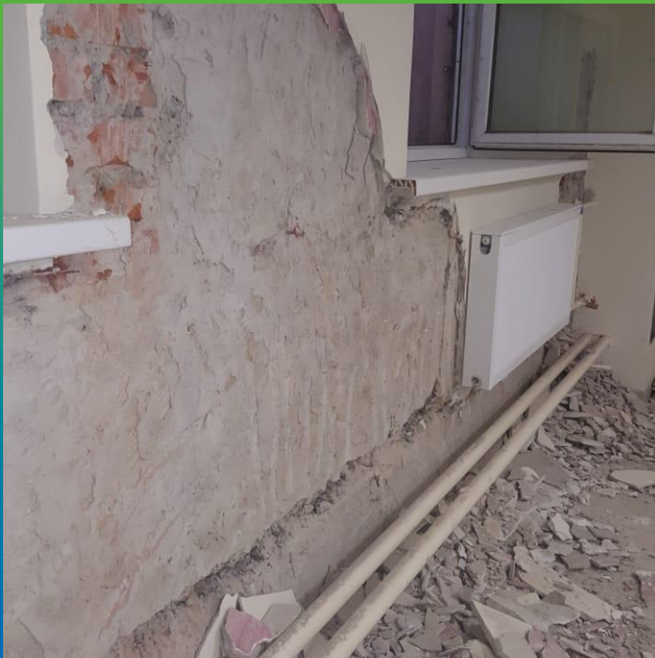
Подготовка основания под проведение гидроизоляционных работ
