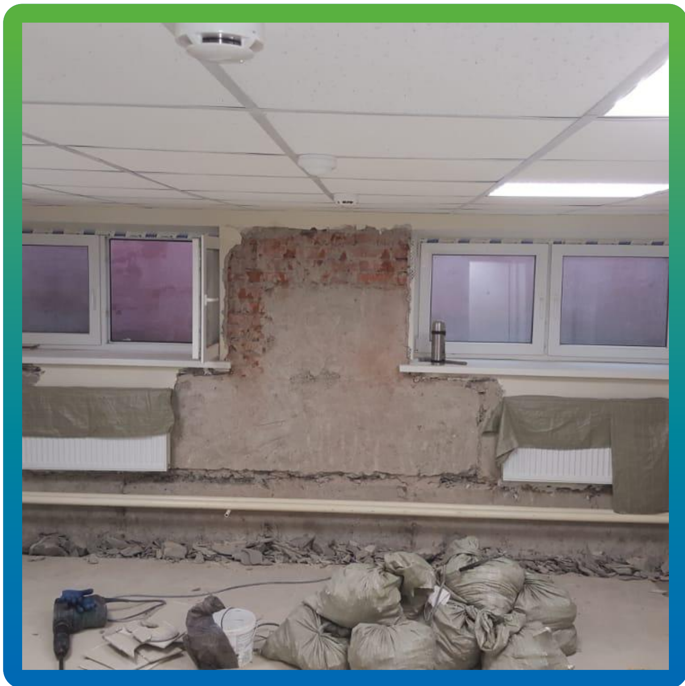
Подготовка основания под проведение гидроизоляционных работ
