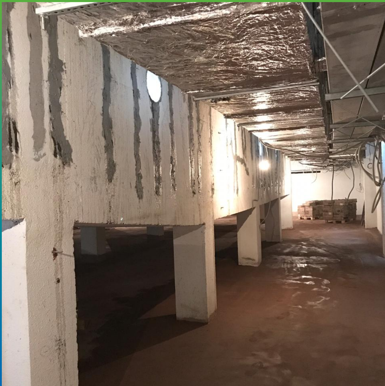
Зачеканка трещин составом Манопокс 331 с внешней стороны бассейна
