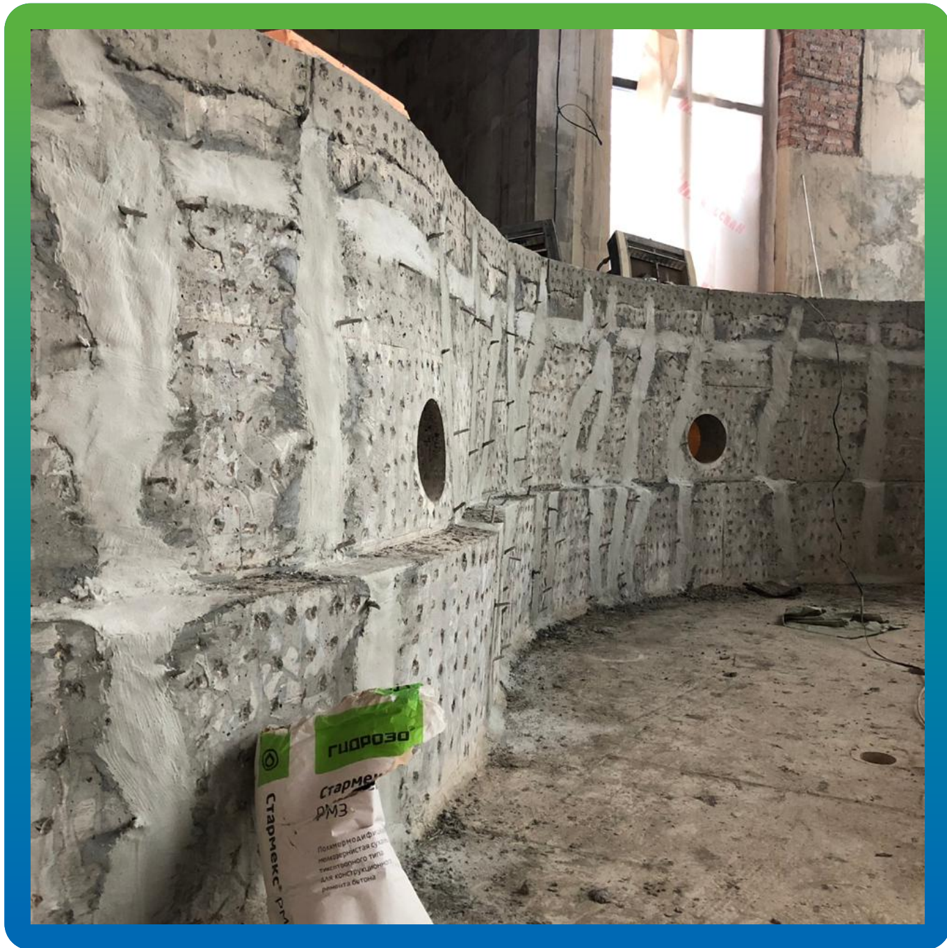
Подготовленная к инъектированию стена
