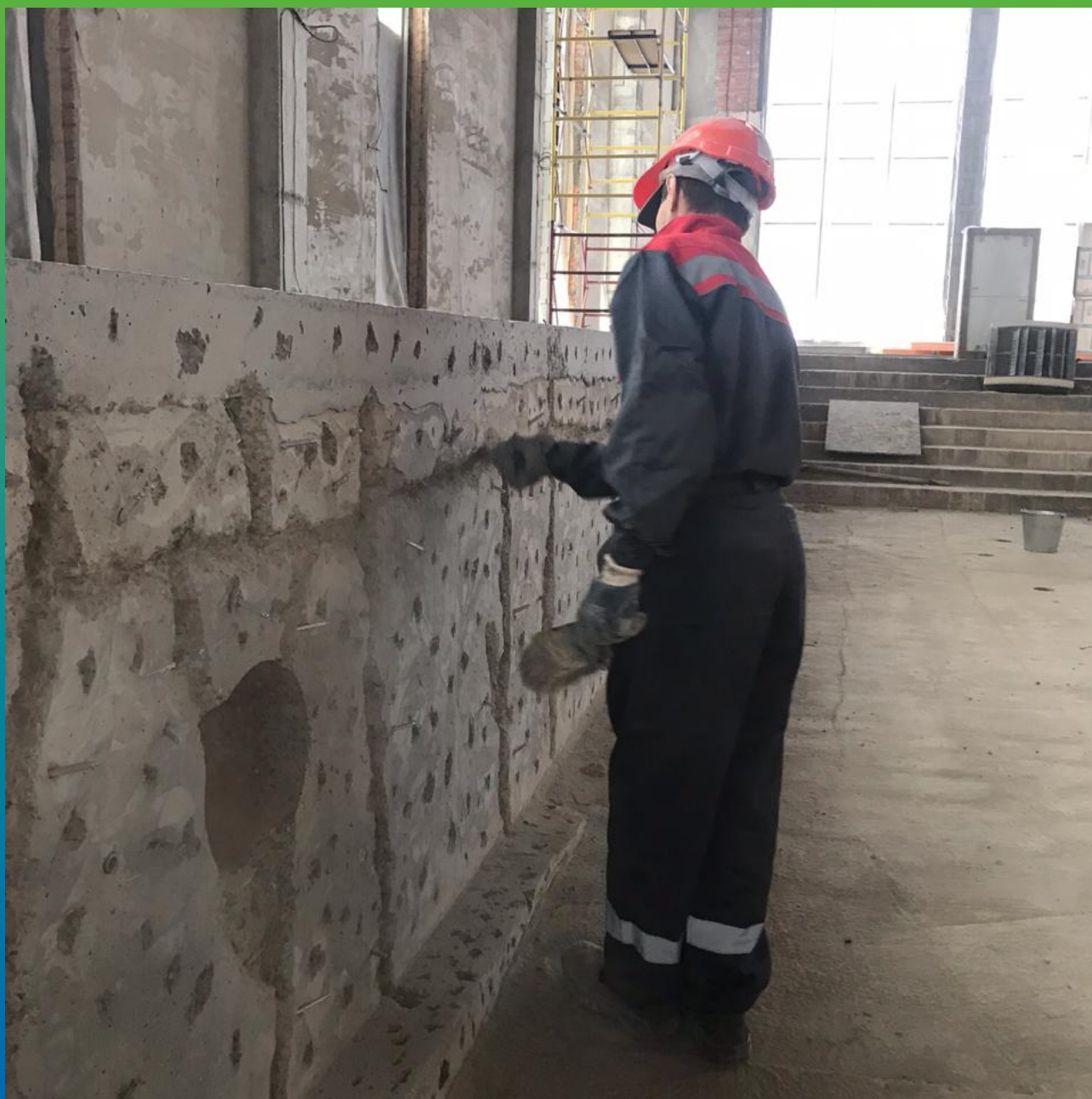
Расшивка дефектных участков бетона и монтаж пакеров
