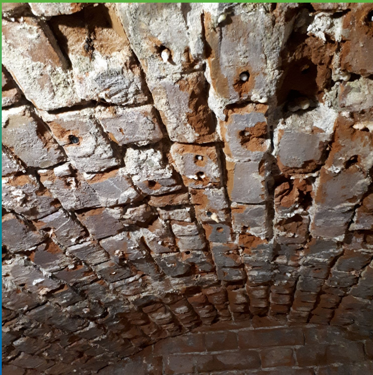
Вид до ремонтных работ
