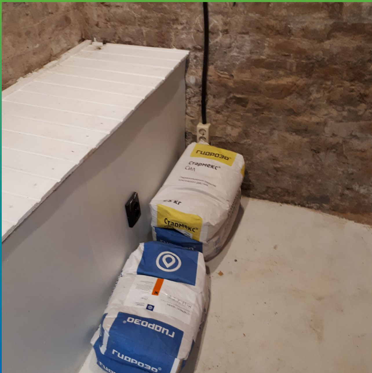
Шовный ремонтный состав Стармакс Чекан и гидроизоляционный состав осмотического действия Стармакс Сил
