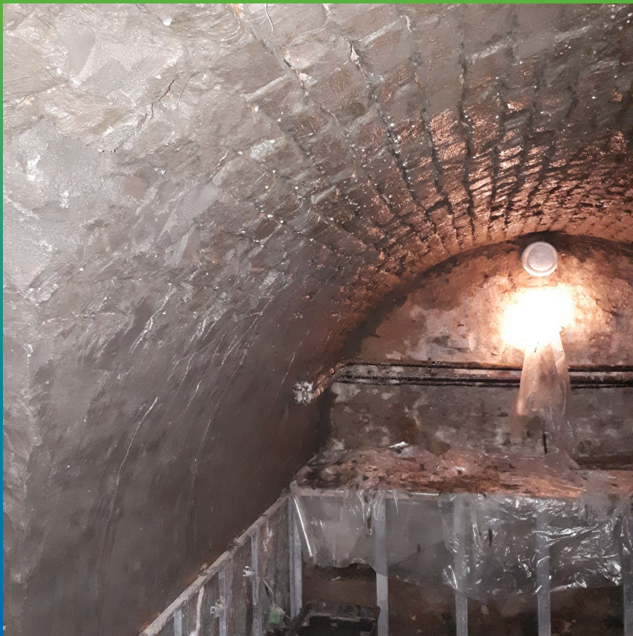
Нанесенная гидроизоляция Стармекс Сил
