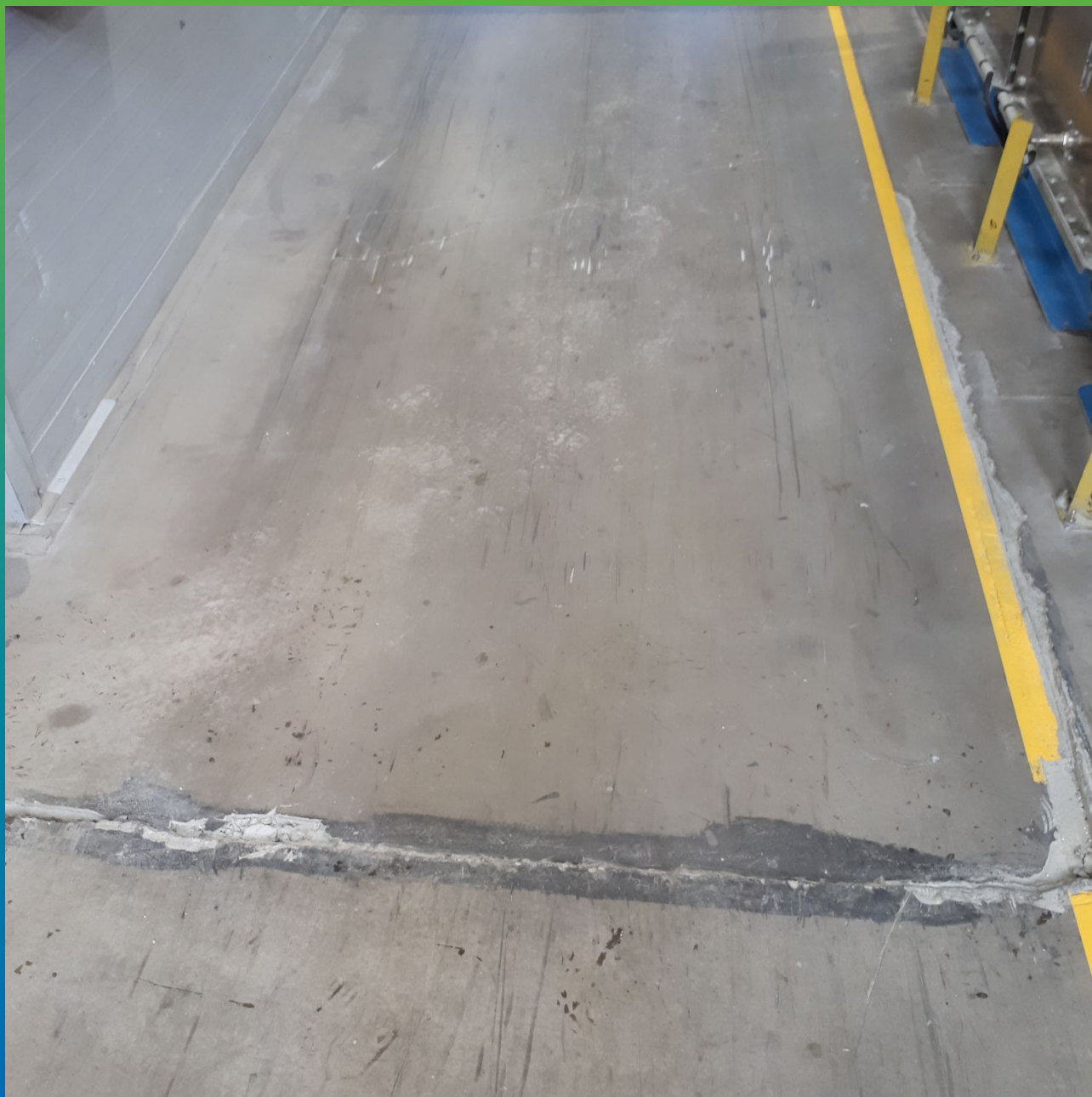
Вид плиты, подлежащей фиксации
