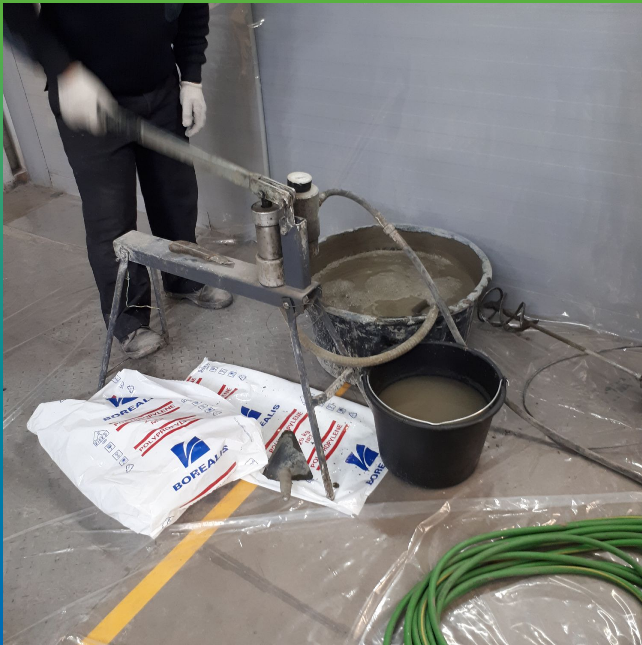
Прокачка безусадочного микроцемента Маноцем Грут для поднятия и фиксации плиты
