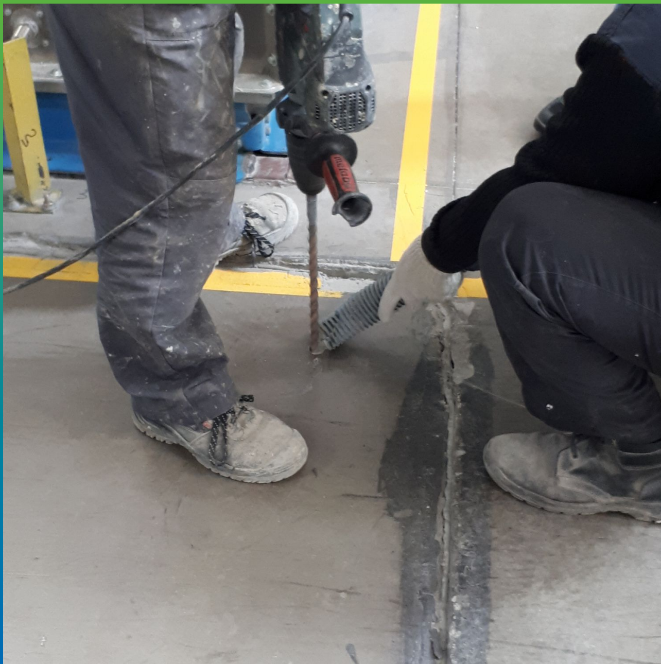
Бурение отверстий в плите
