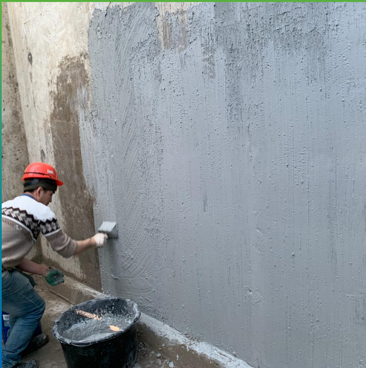
Нанесение материала на подготовленную поверхность
