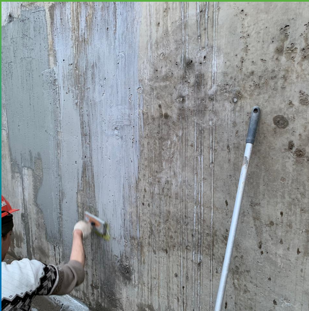
Нанесение материала на подготовленную поверхность
