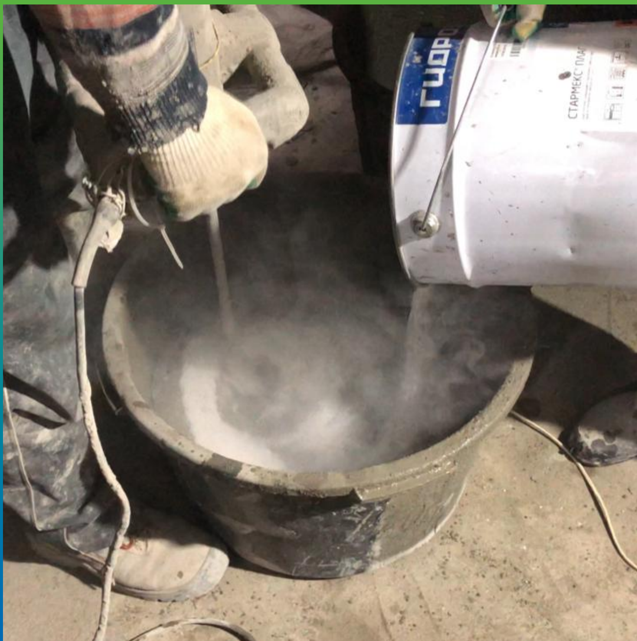
Затворение Стармекс ФМ7 с 25% кварцевого песка фракции 0,8-2 мм
