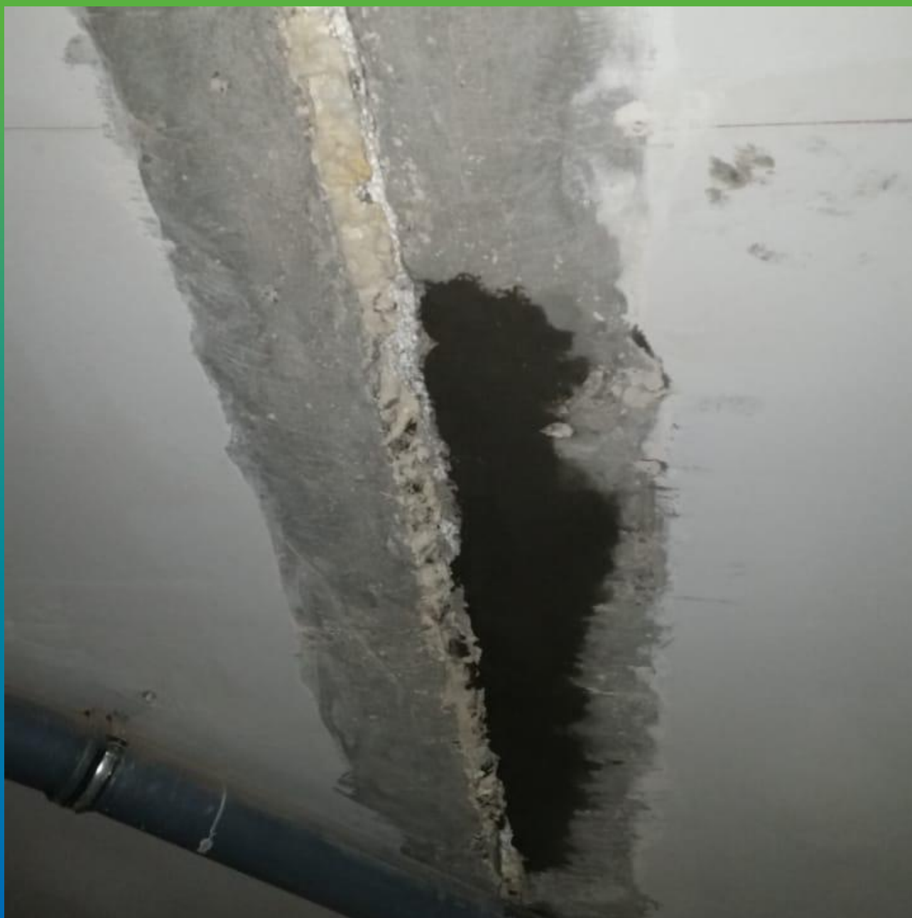
Ремонт плит перекрытия
