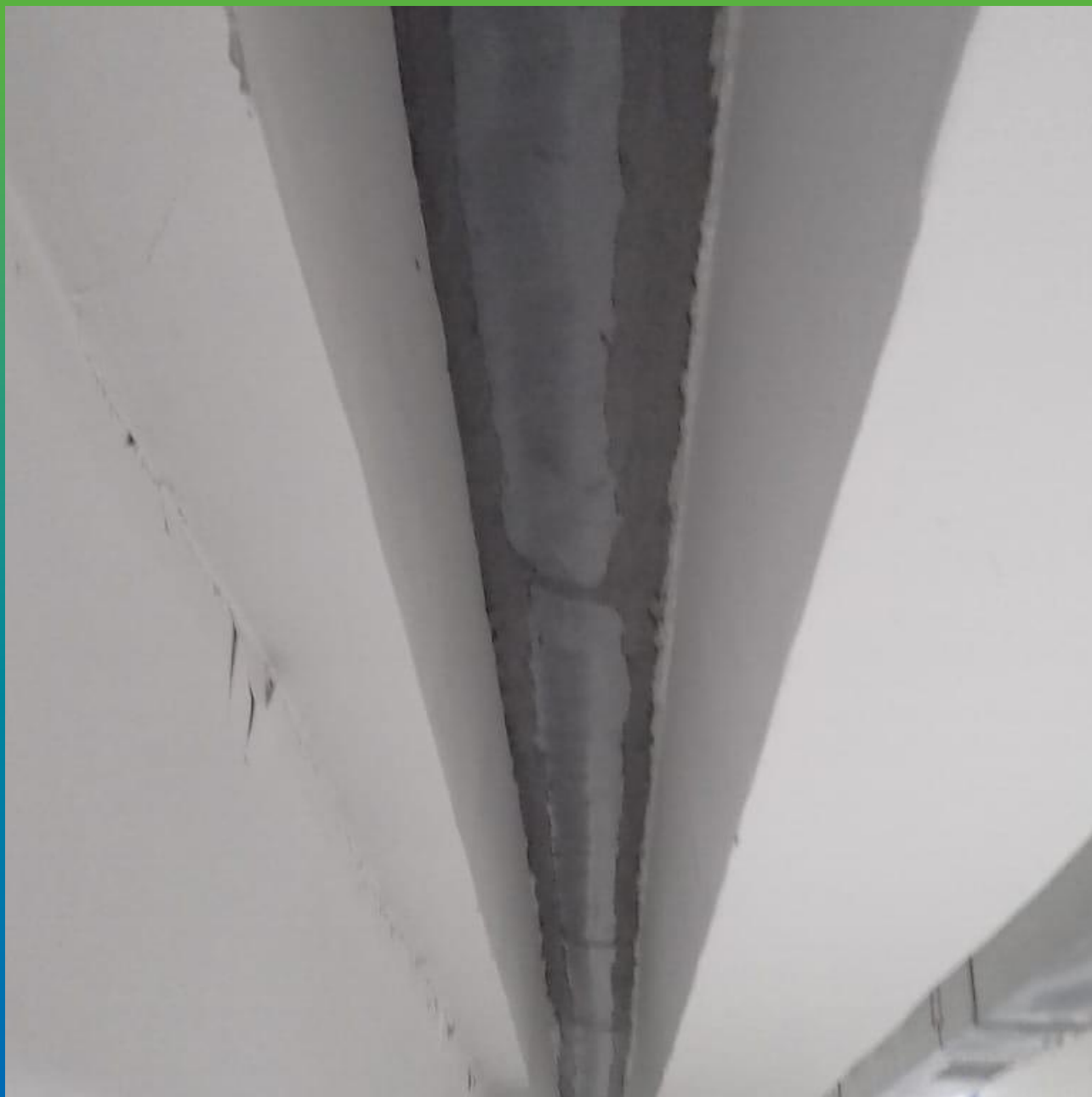
Участок с выполненной гидроизоляцией деформационного шва
