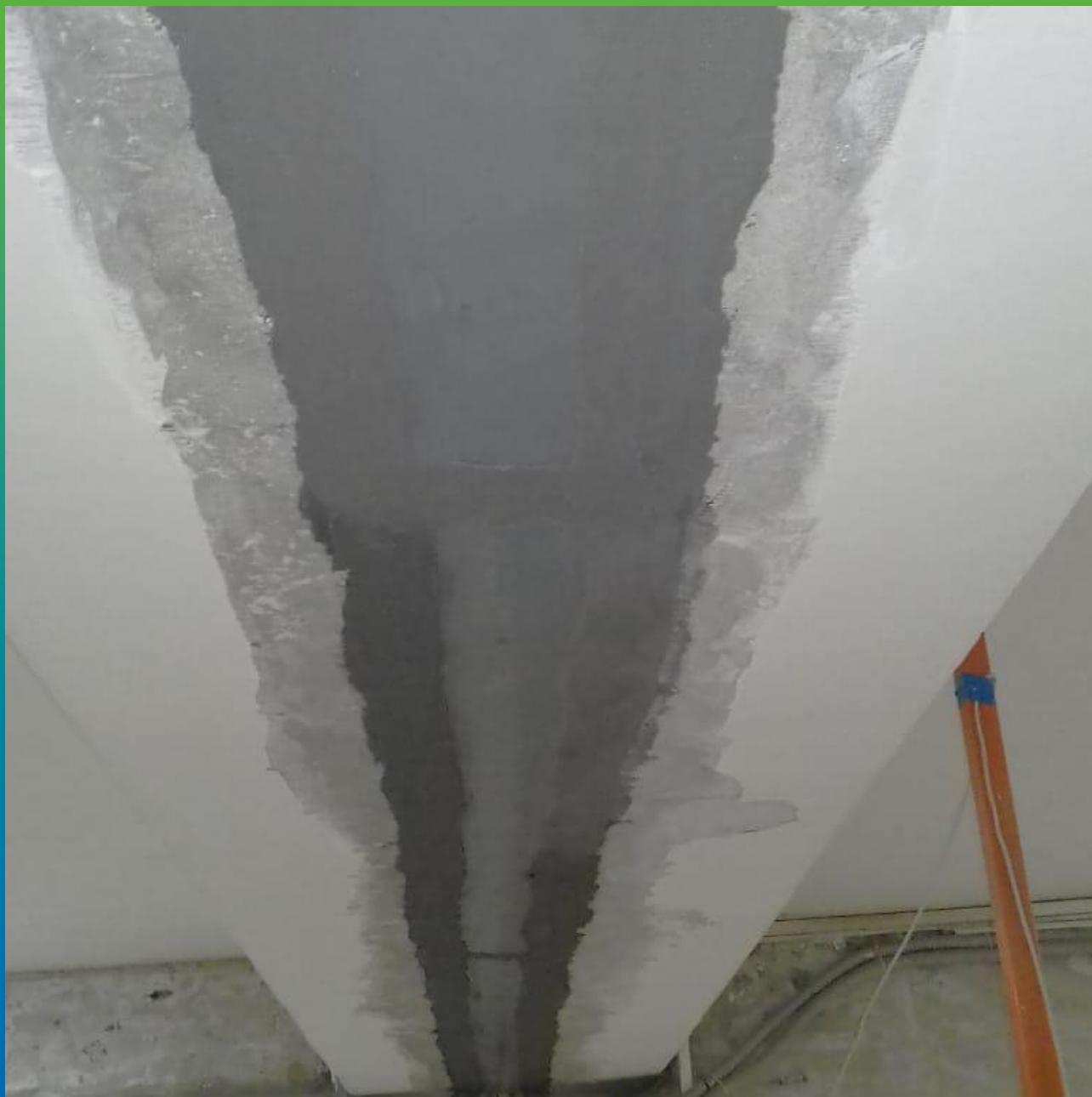
Участок с выполненной гидроизоляцией деформационного шва
