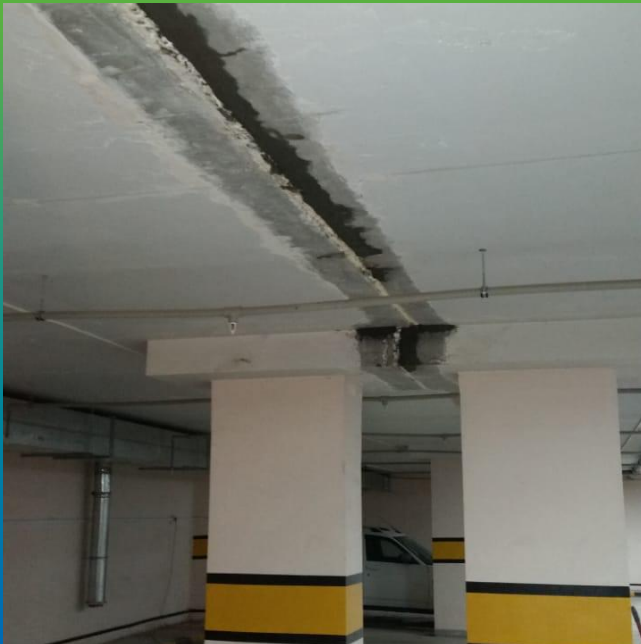
Ремонт плит перекрытия
