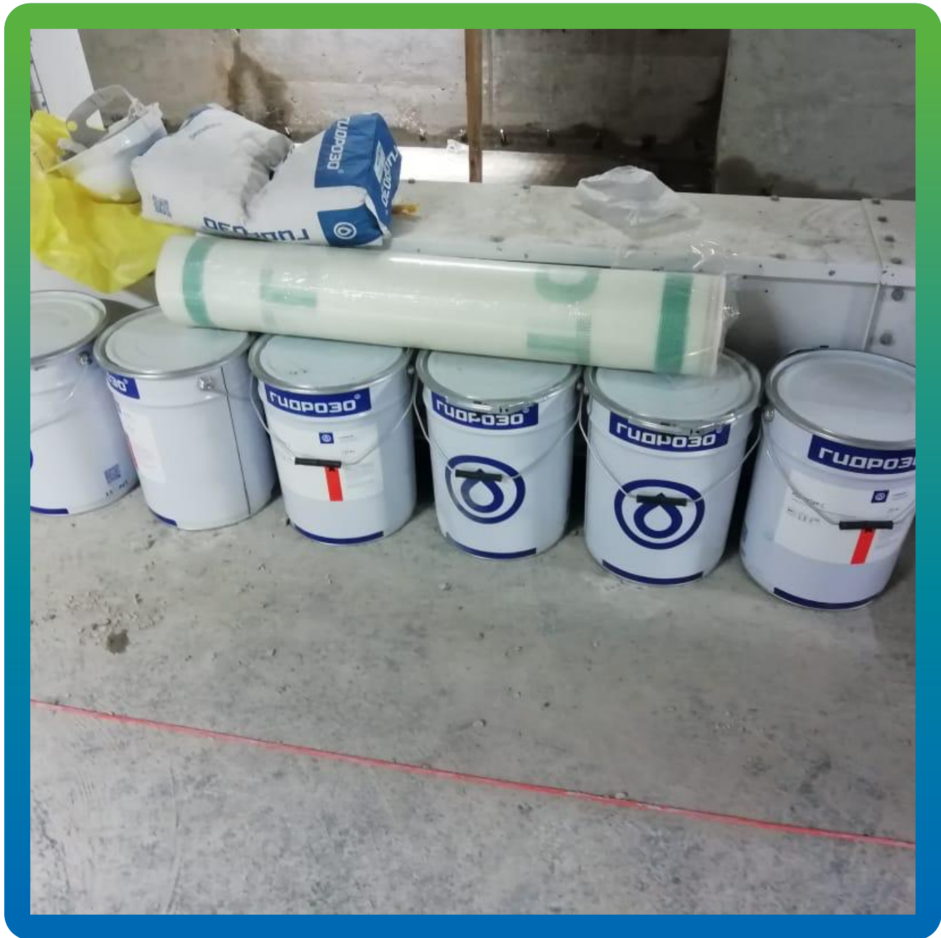
Материалы Гидрозо на объекте
