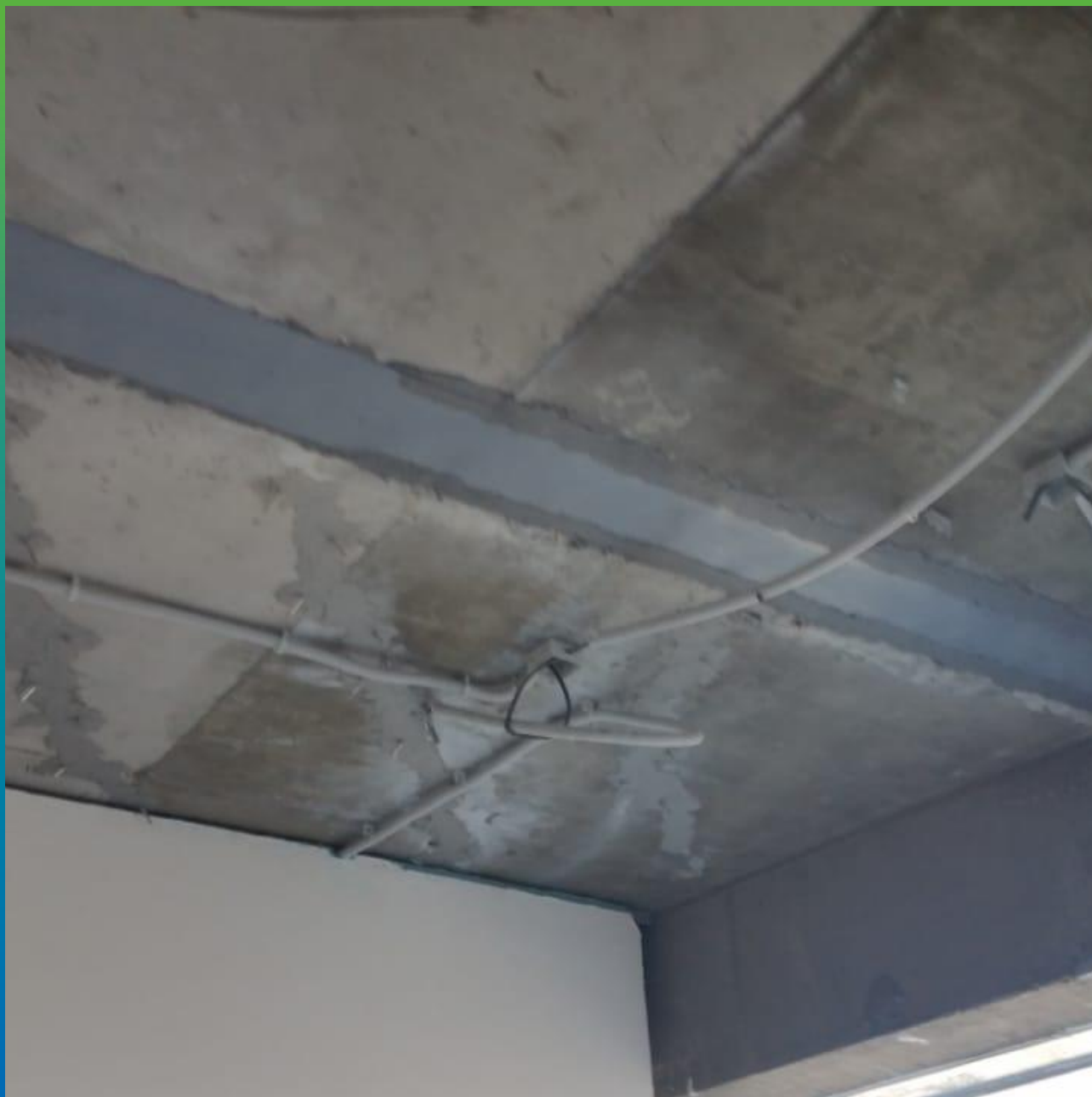
Участок с выполненной гидроизоляцией деформационного шва
