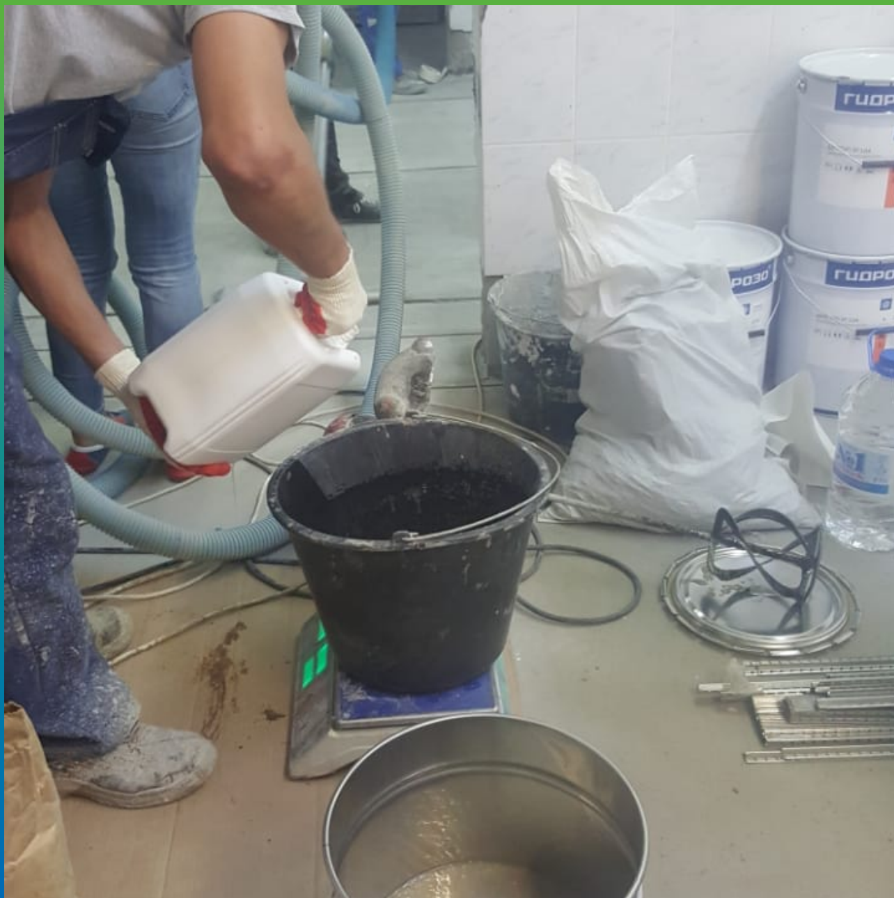
Приготовление грунтовки ДенсТоп ЭП 104
