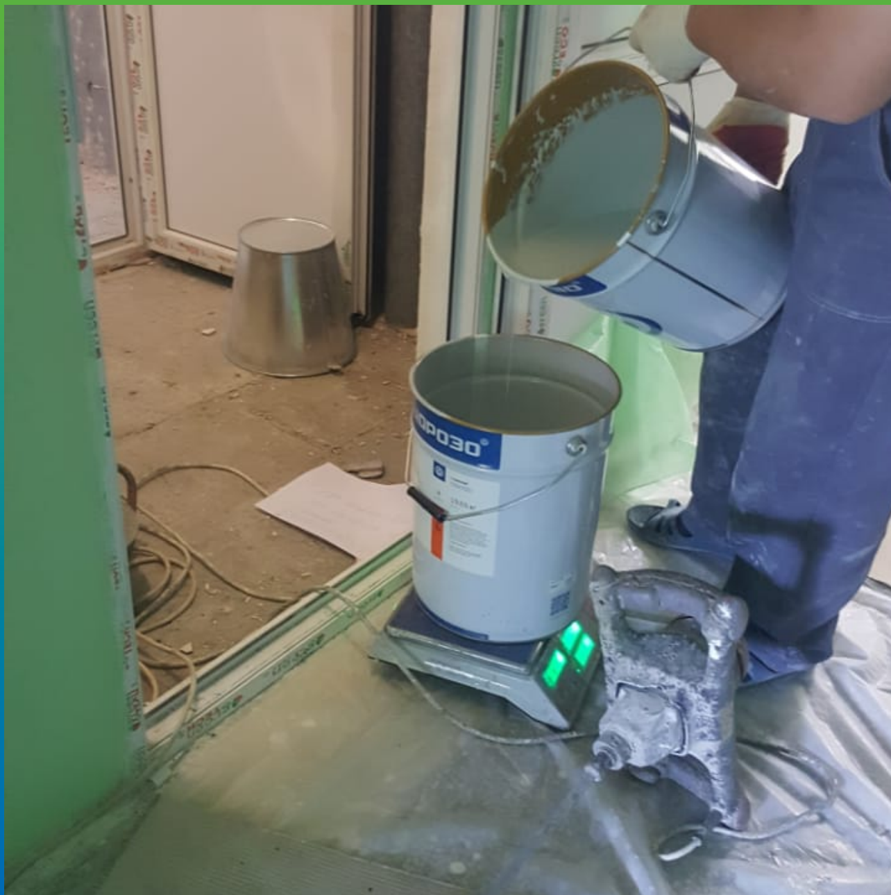
Подготовка финишного эпоксидного покрытия ДенТоп ЭП 501
