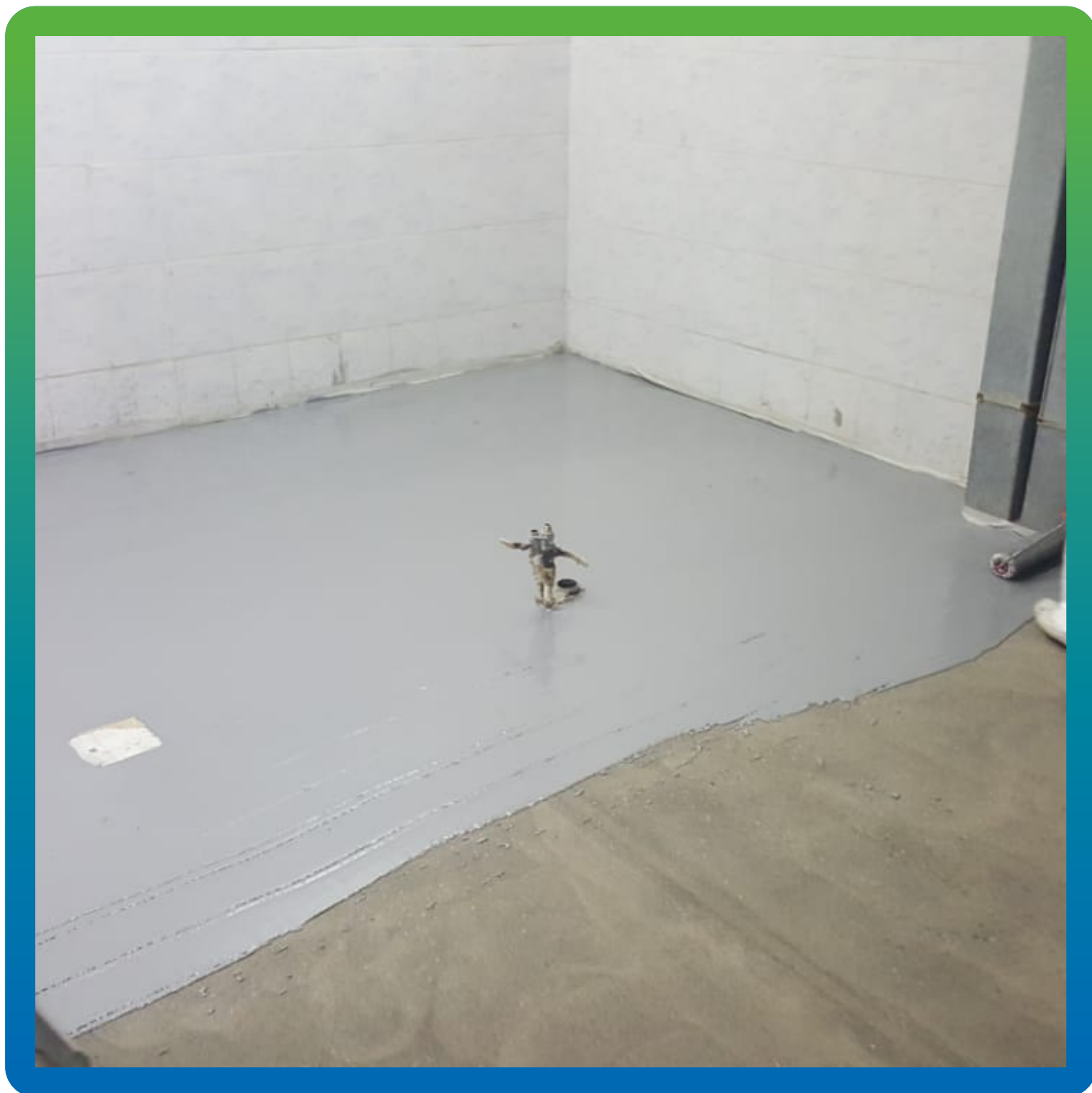
Укладка полимерцементного химстойкого покрытия ДенсТоп ПМ 605 Флоу
