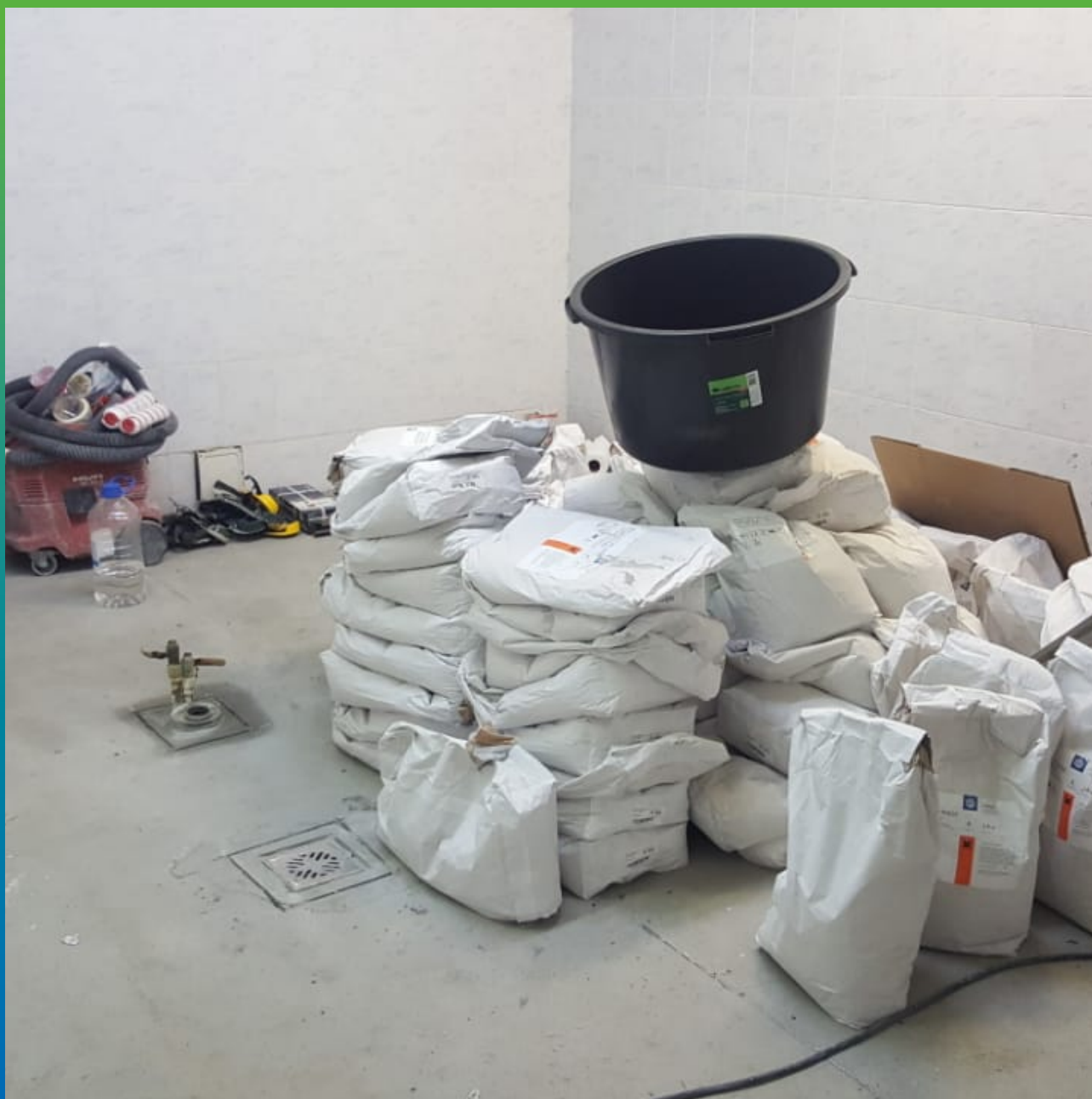
Материалы Гидрозо на объекте
