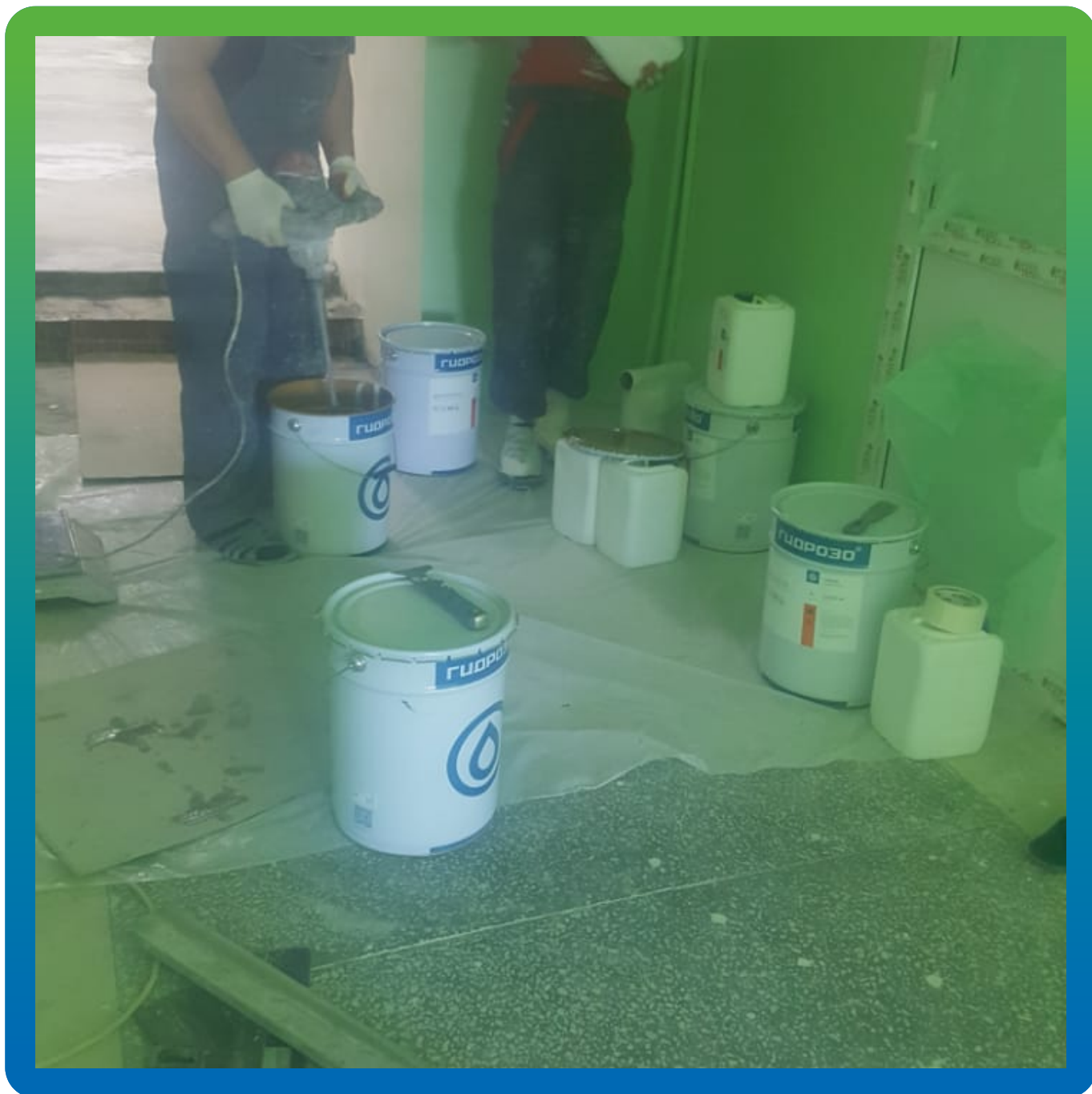
Смешивание двух компонентов ДенТоп ЭП 501
