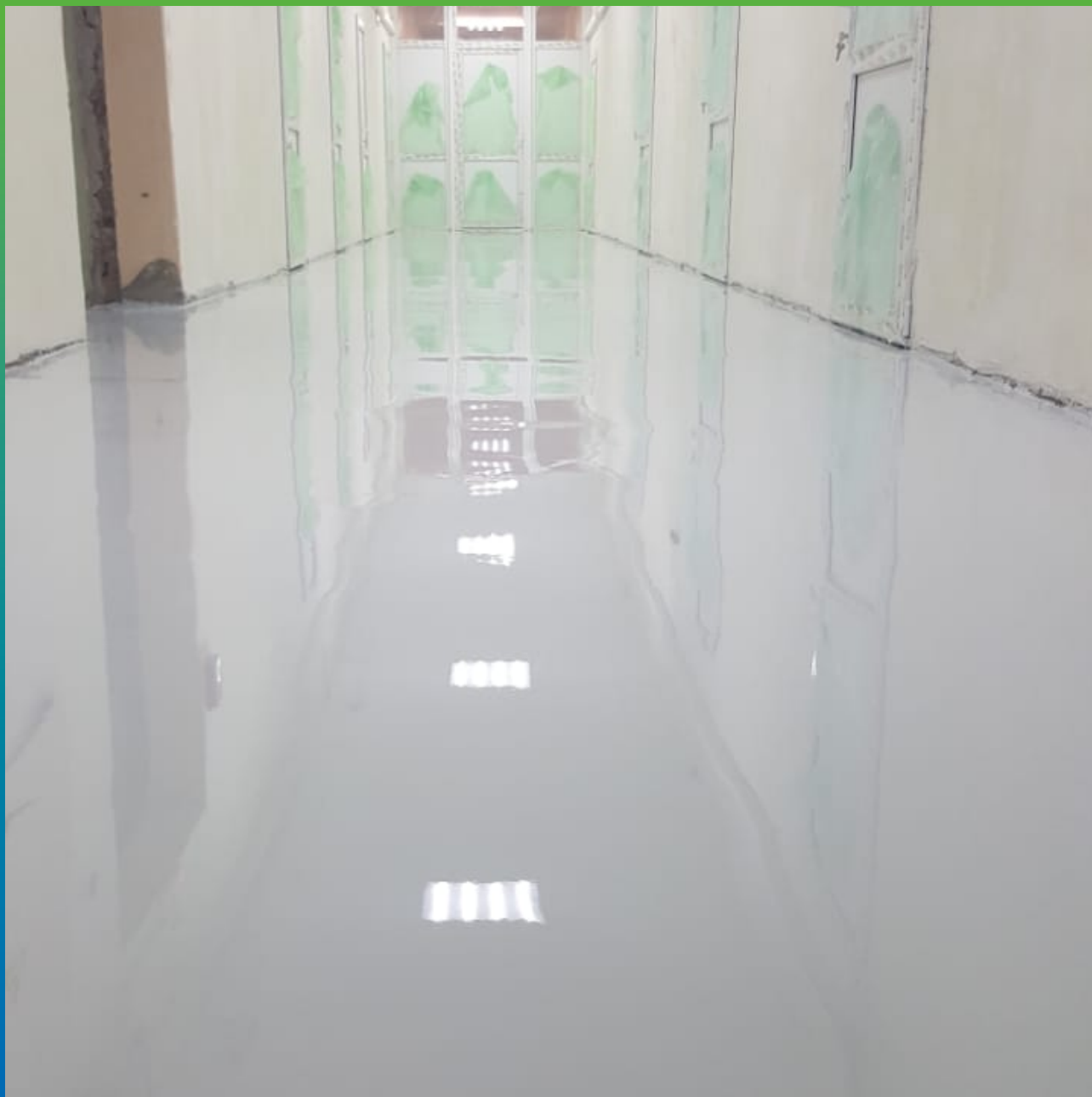
Финишный вид покрытия ДенсТоп ЭП 501
