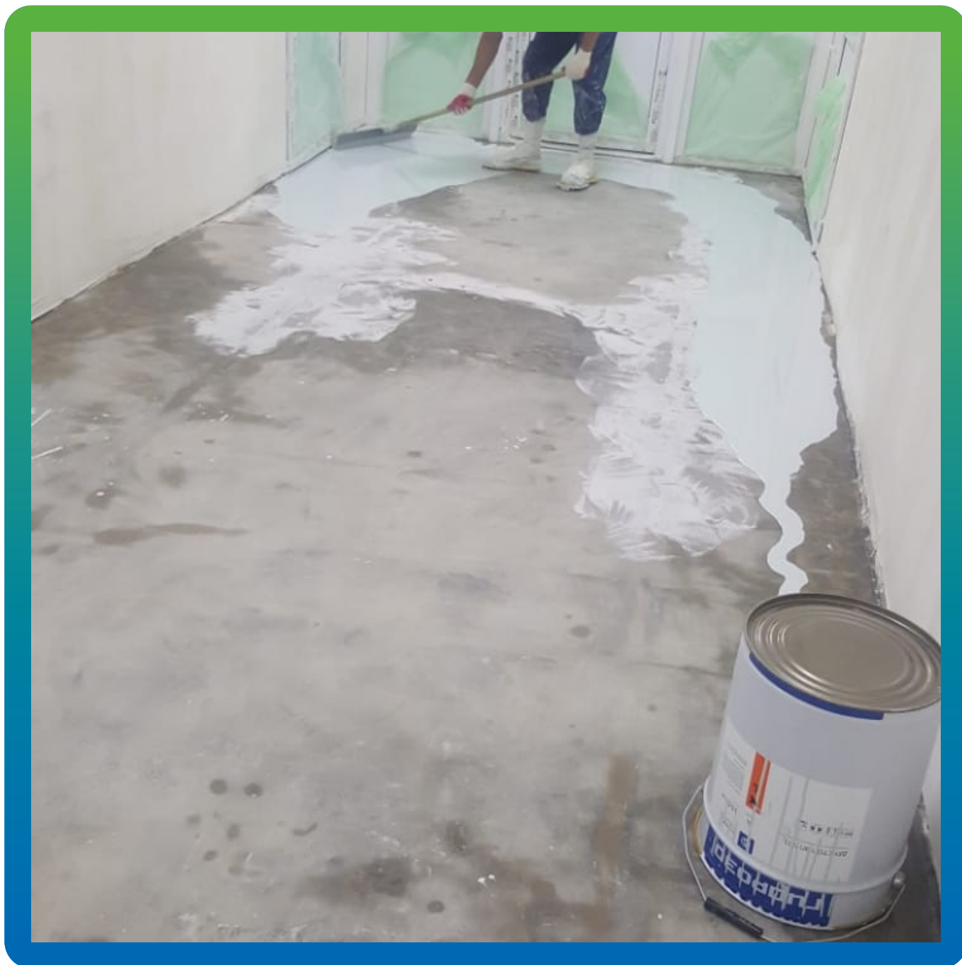
Растягивание эпоксидной массы по площади
