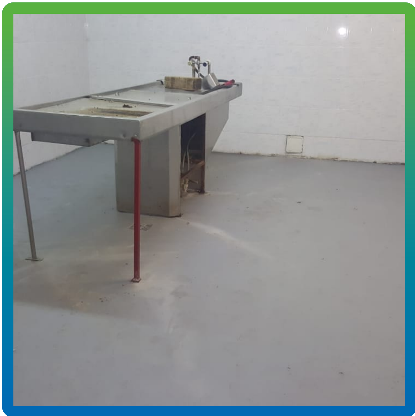
Финишный вид цементно-полиуретанового покрытия ДенсТоп ПМ 605 Флоу
