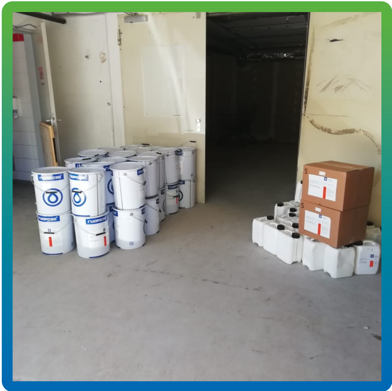
Материалы Гидрозо на объекте
