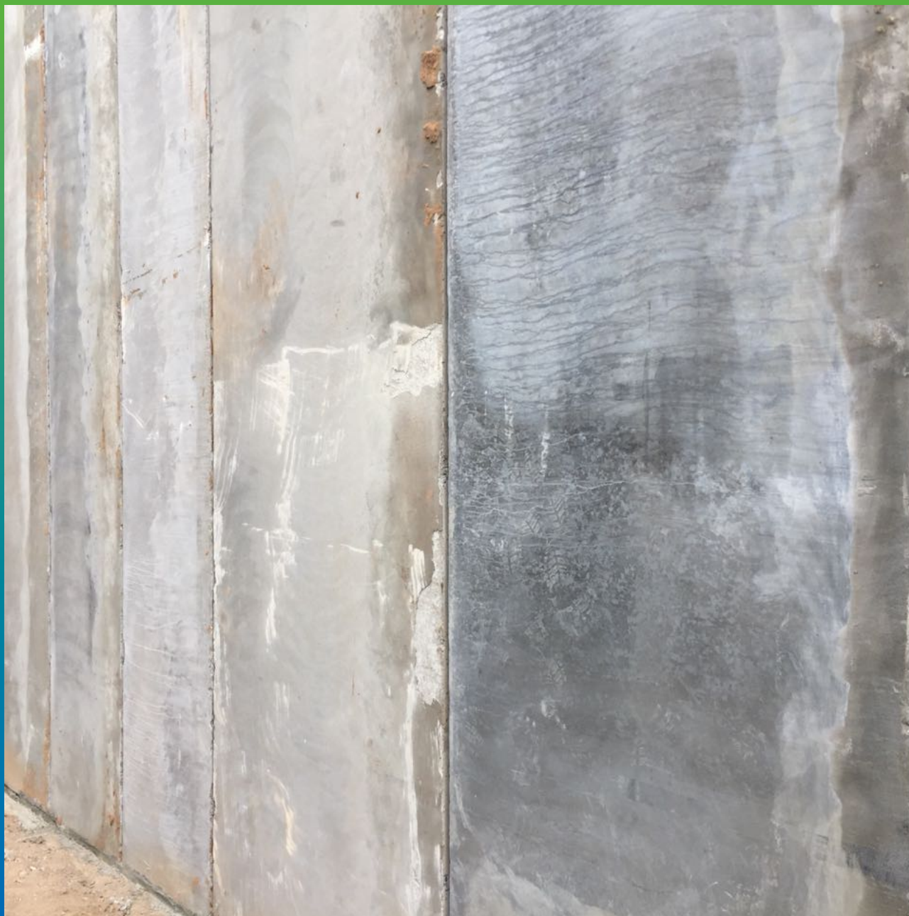
Стеновые панели подземной парковки до начала работ
