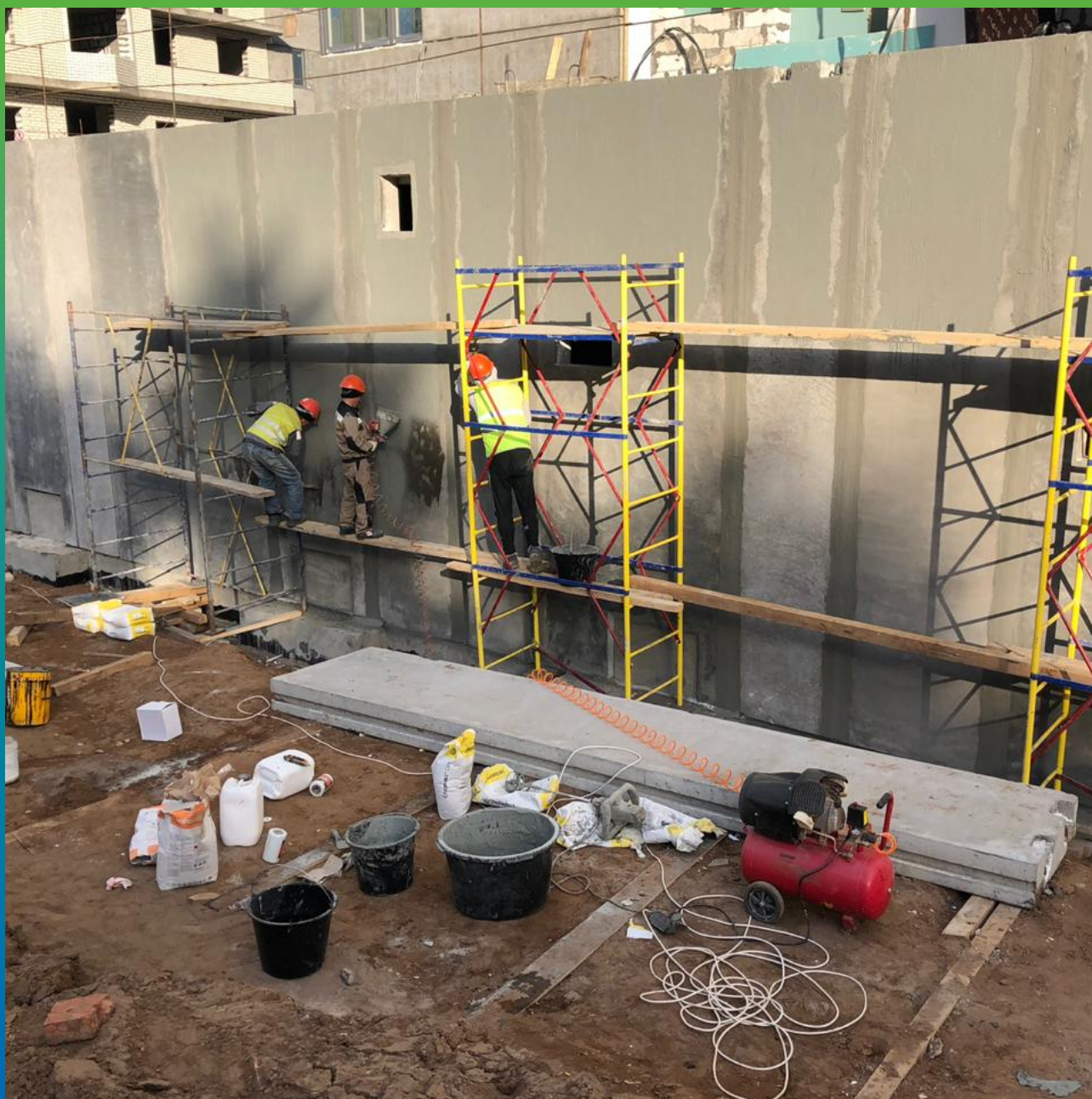
Работы по гидроизоляции стен подземной парковки снаружи.
