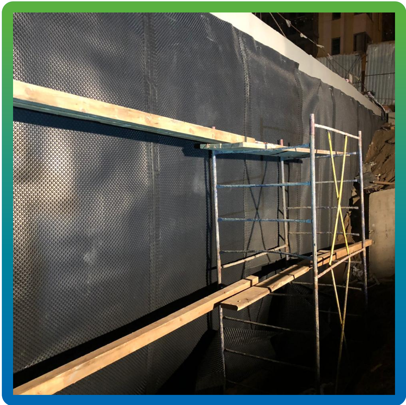
Участок, готовый к засыпке.
