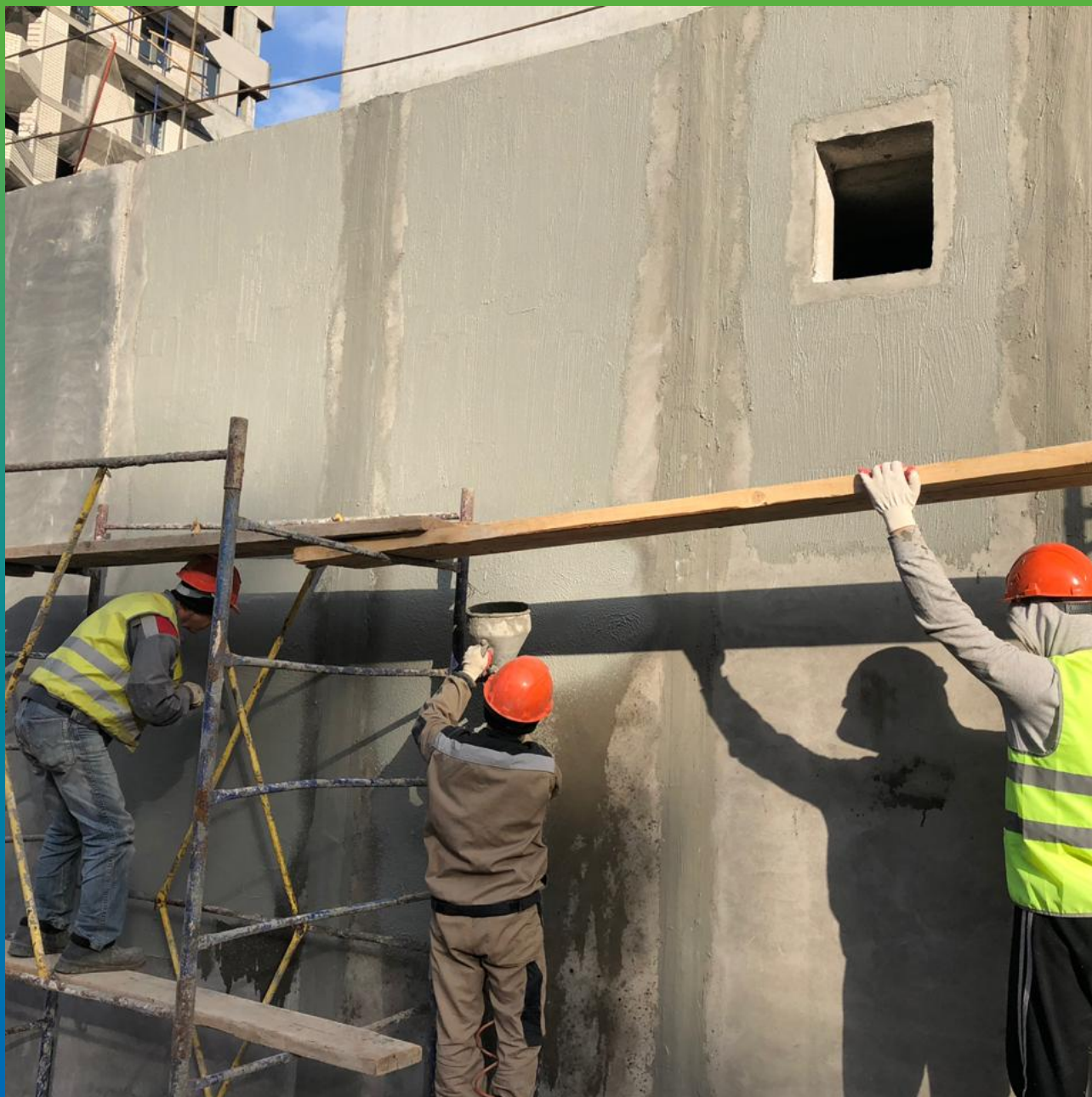
Нанесение гидроизоляционного покрытия Стармекс Сил.
