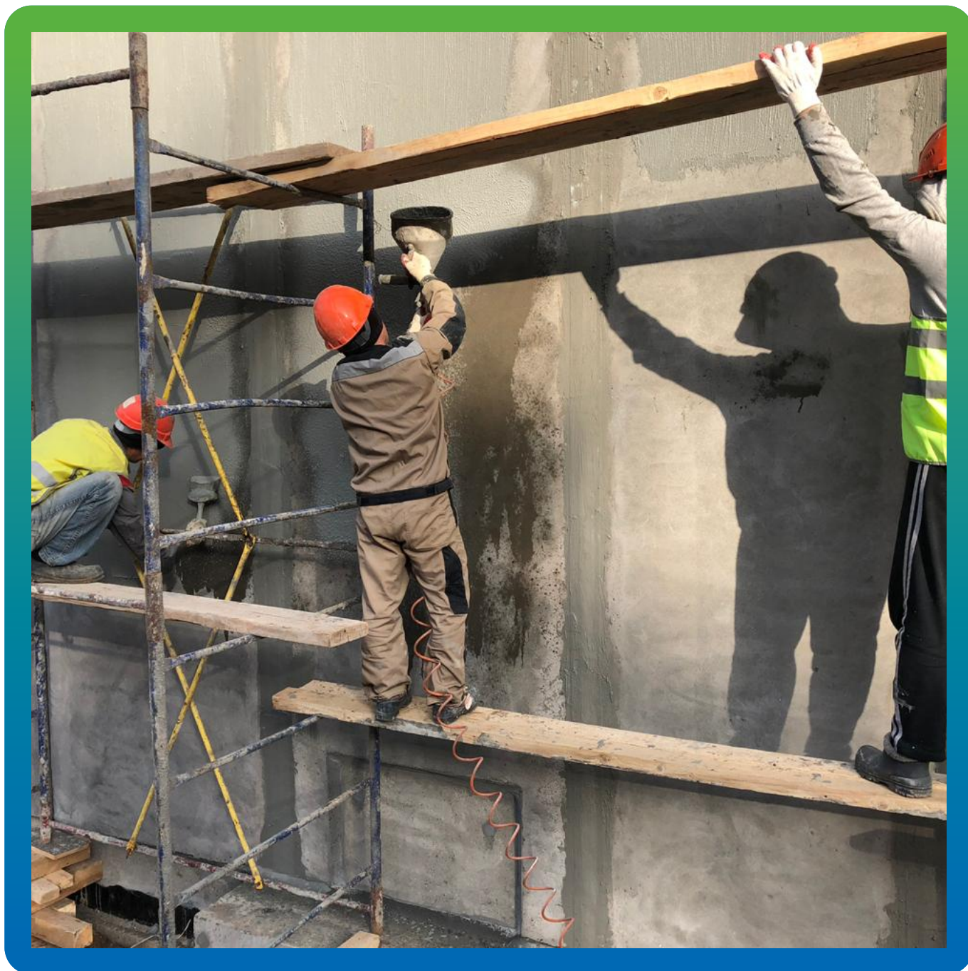
Нанесение гидроизоляционного покрытия Стармекс Сил.
