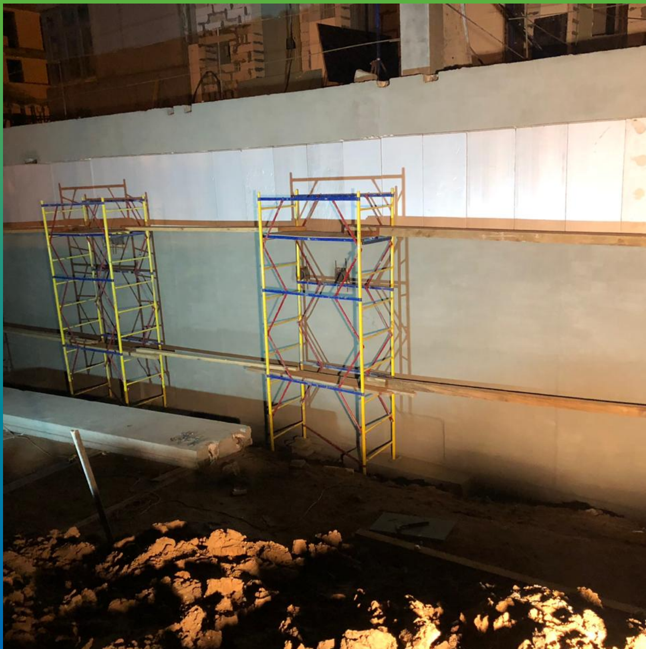
Монтаж утеплителя на гидроизолированную поверхность.
