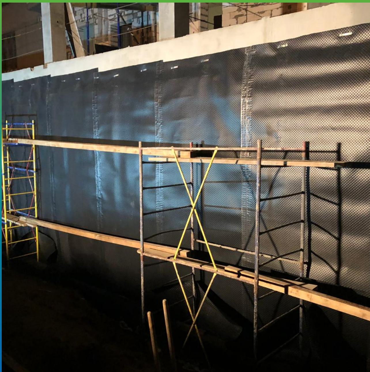
Участок, готовый к засыпке.
