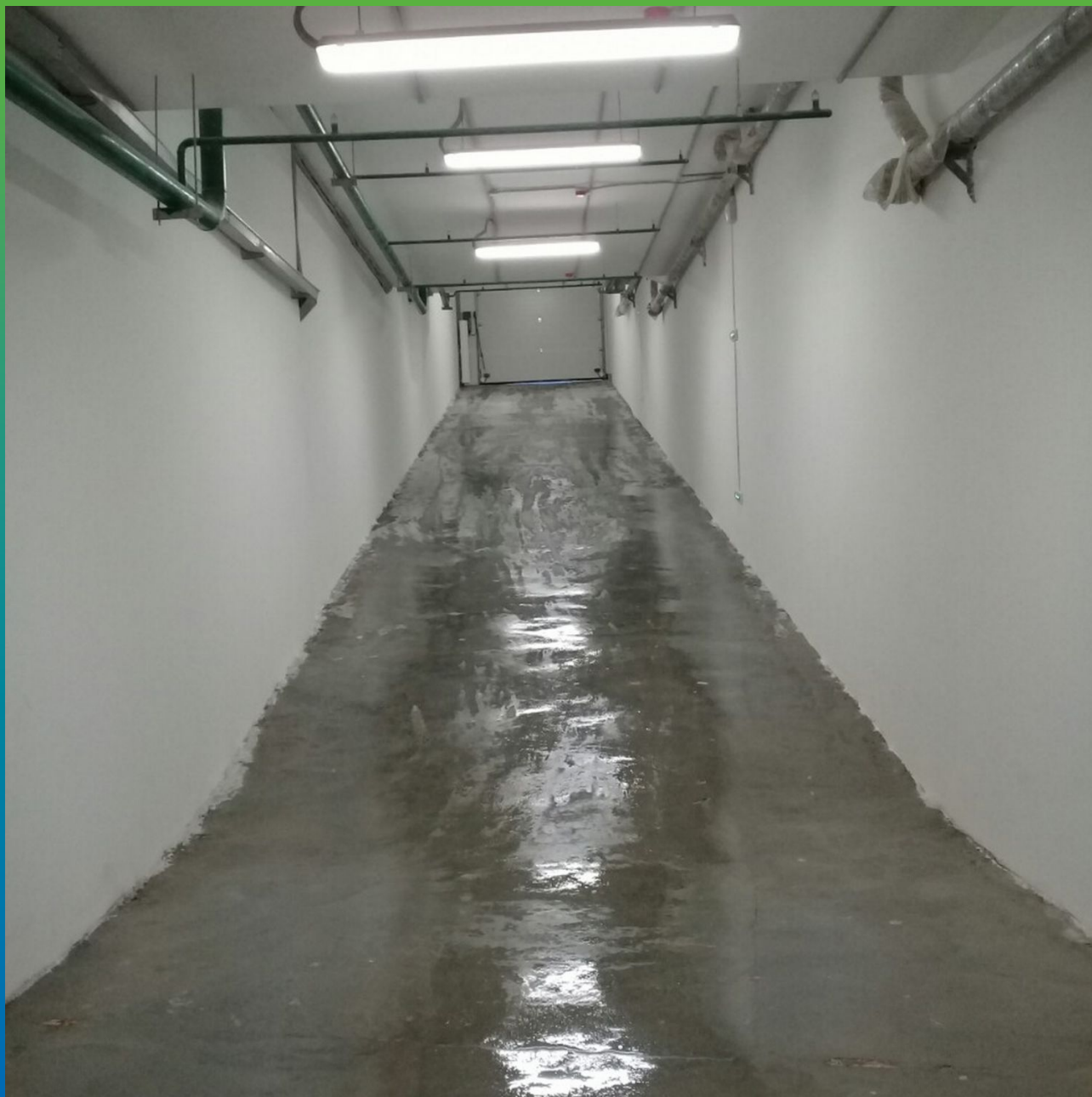
Парковка после нанесения Маногард Топ 117.
