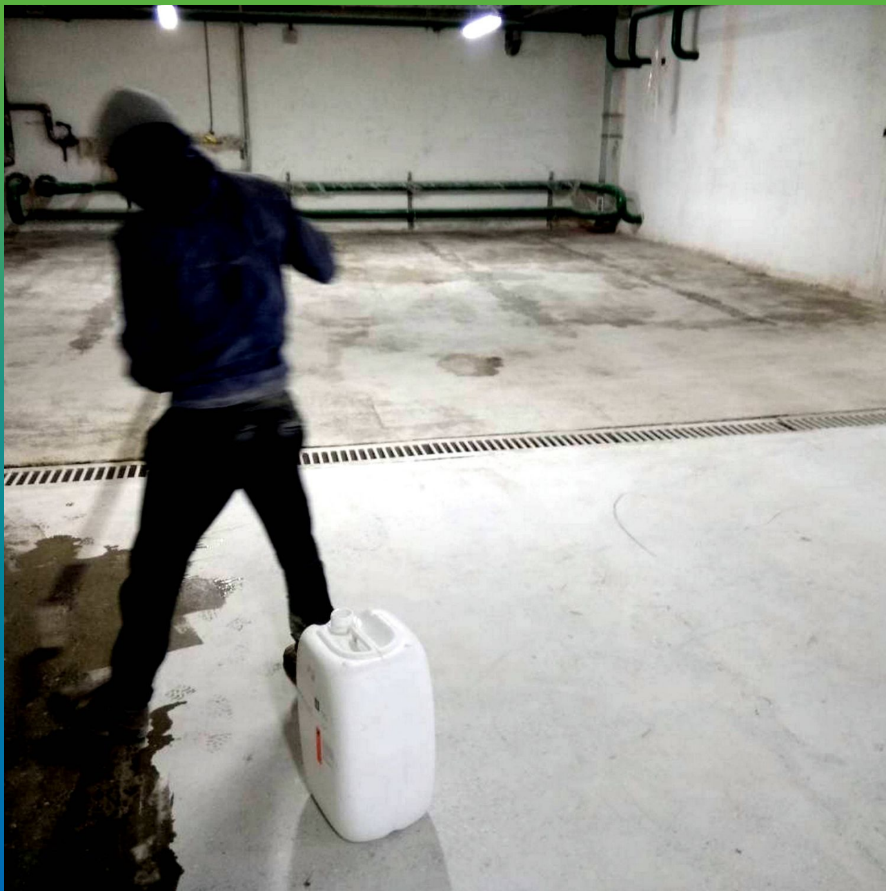
Нанесение валиком на поверхность упрочняющей и обеспыливающей пропитки Маногард Топ 117.
