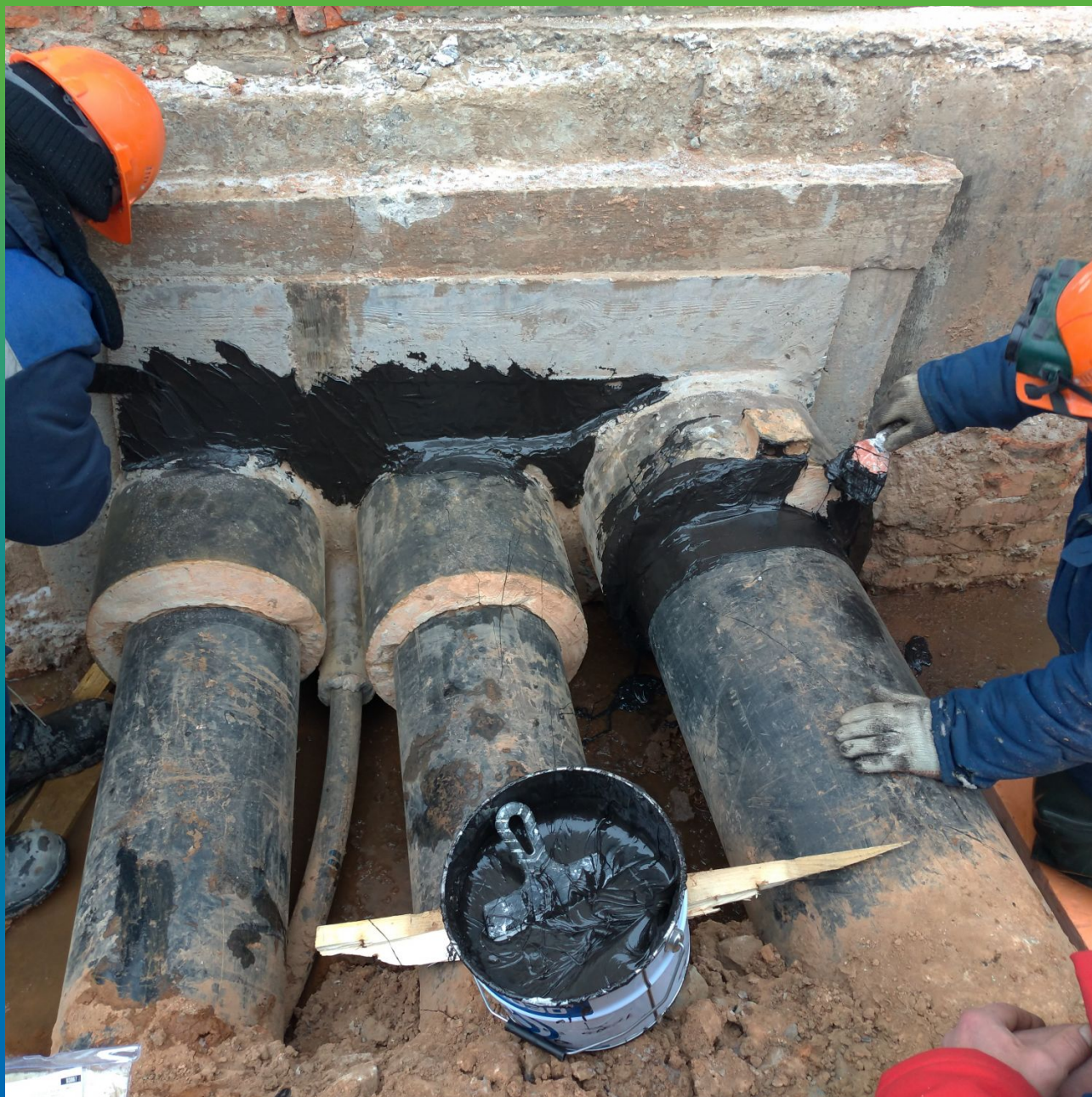
Нанесение ДенсТоп ПС 391 на пластиковые и бетонные поверхности.
