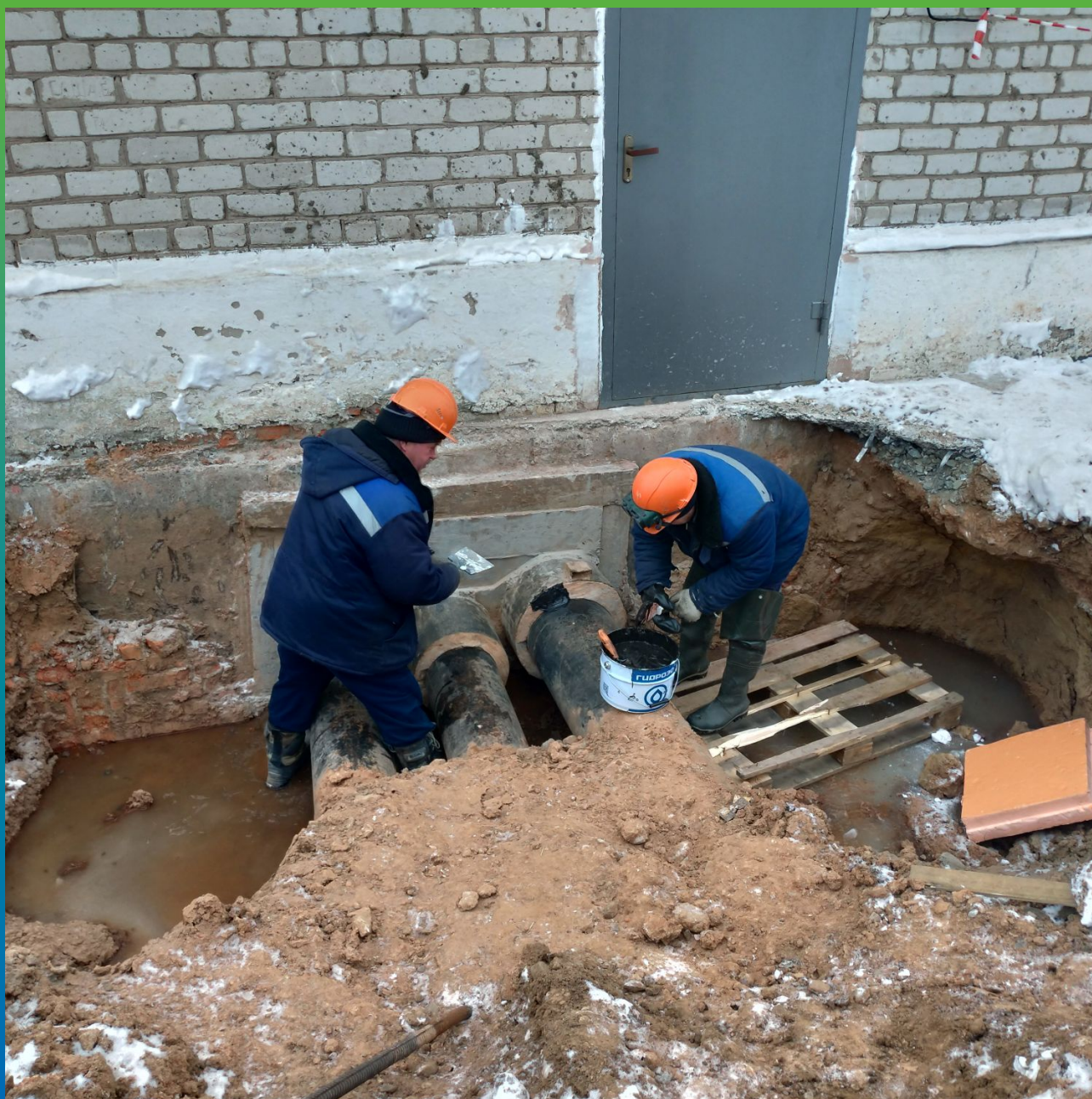
Нанесение материала при отрицательных температурах.
