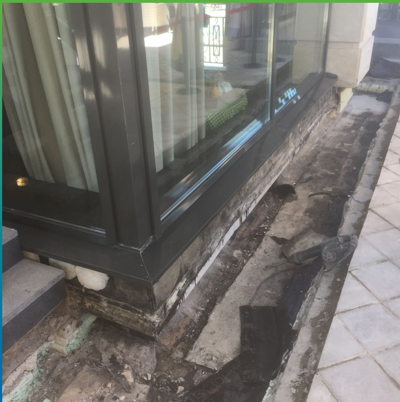
Демонтаж старого покрытия.
