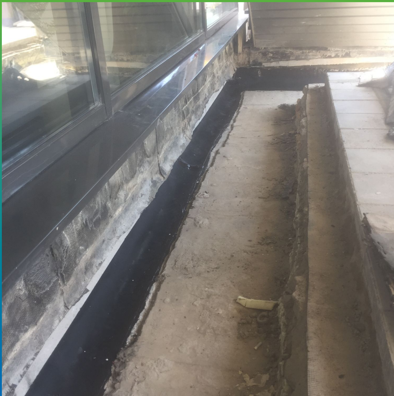
Герметизация стыка стена-пол ЭПДМ мембраной Прелести.
