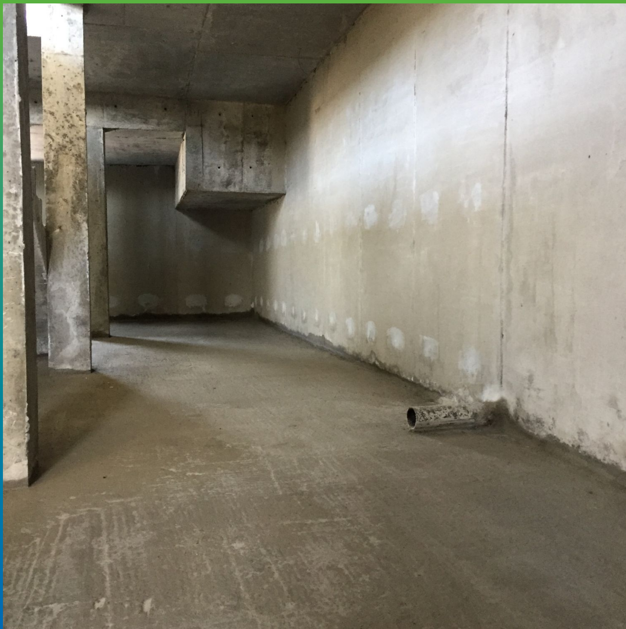
Результат проведенных гидроизоляционных работ.
