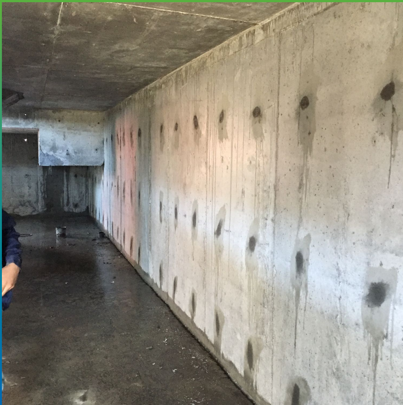
Ремонт опалубочных отверстий.
