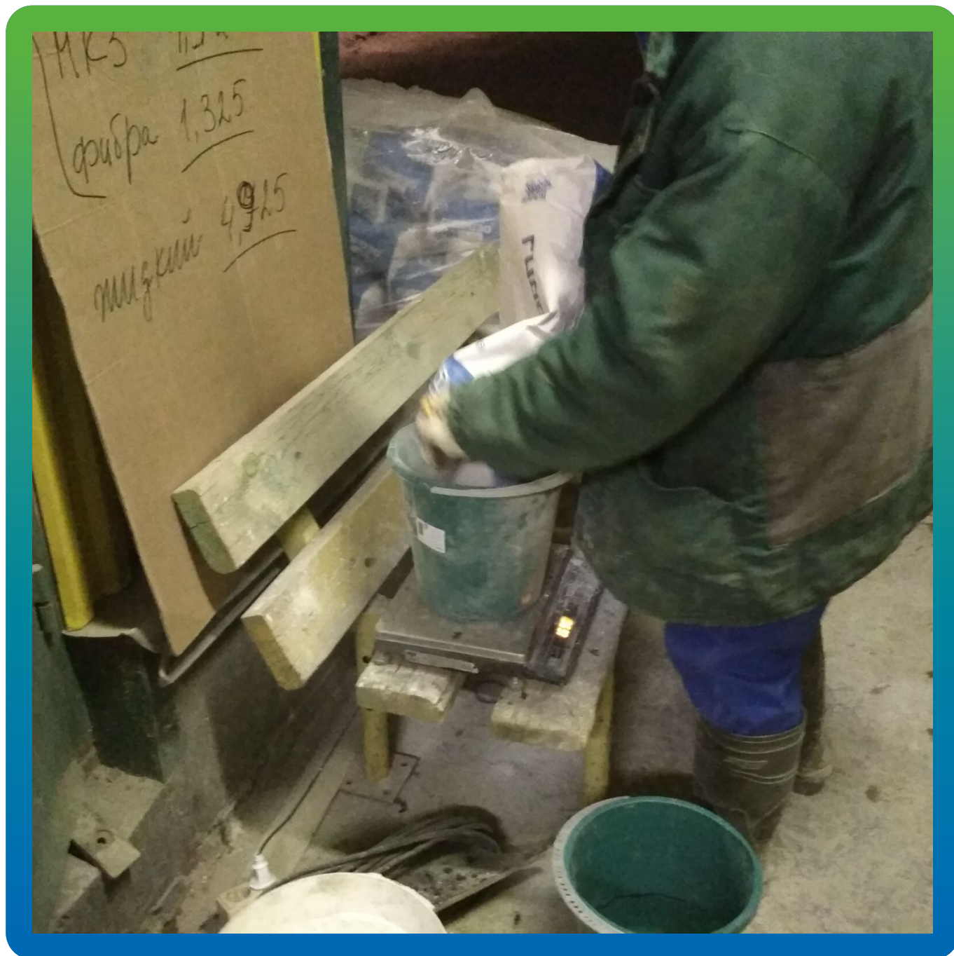
Взвешивание добавок Реолен Адмикс, Реолен МКЗ, Реолен ПЛ 430, Реолен Файбер кратно кубическому метру бетона.
