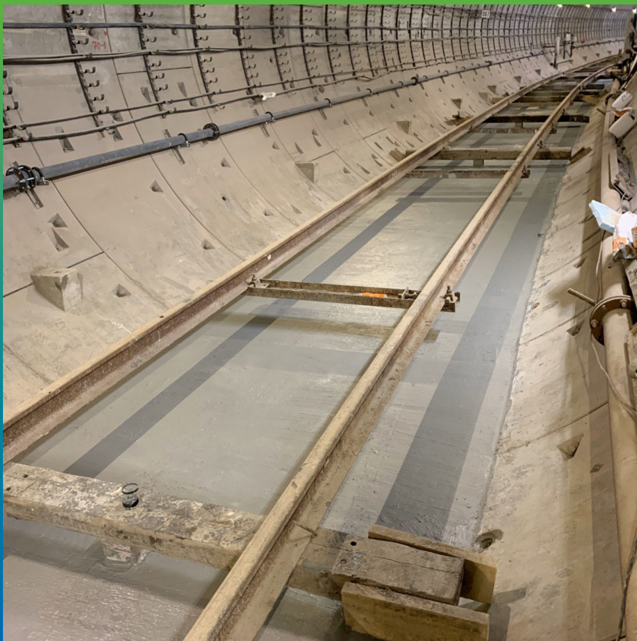
Финишный слой загидроизолированного участка в тоннеле метро
