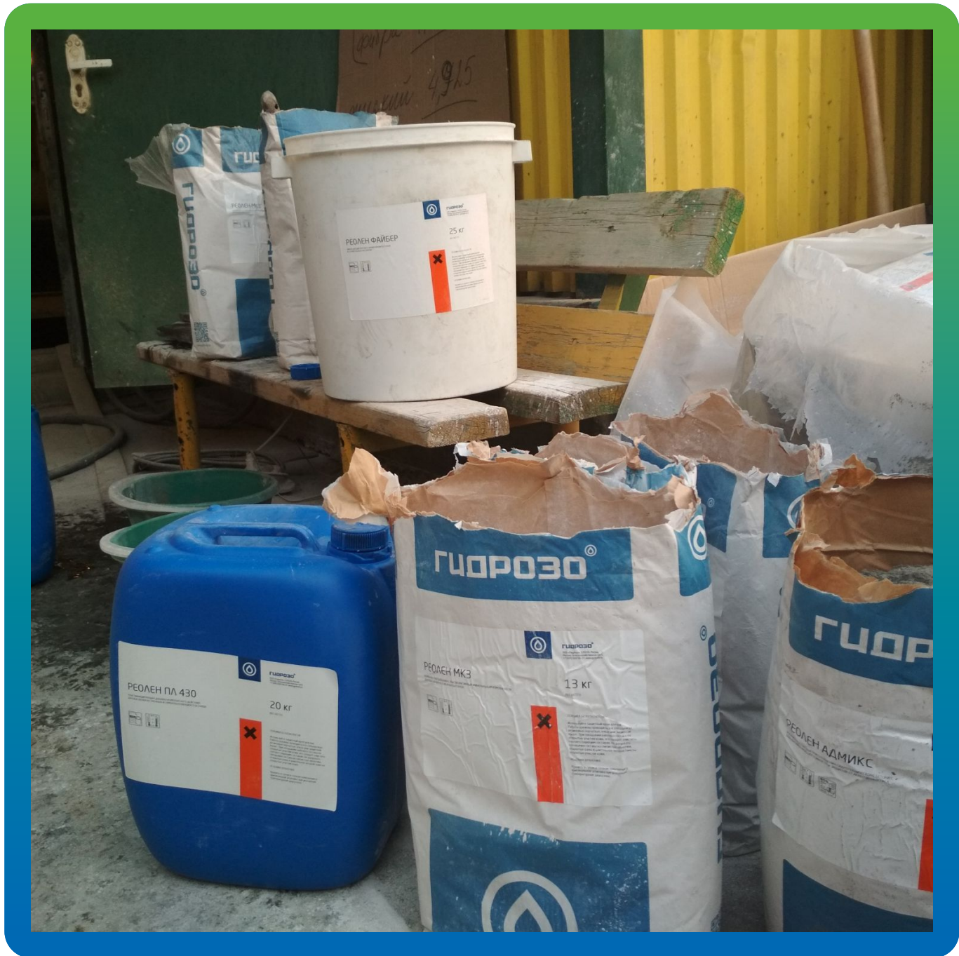
Подготовка добавок Реолен Адмикс, Реолен МКЗ, Реолен ПЛ 430, Реолен Файбер перед добавлением в сухой состав бетона
