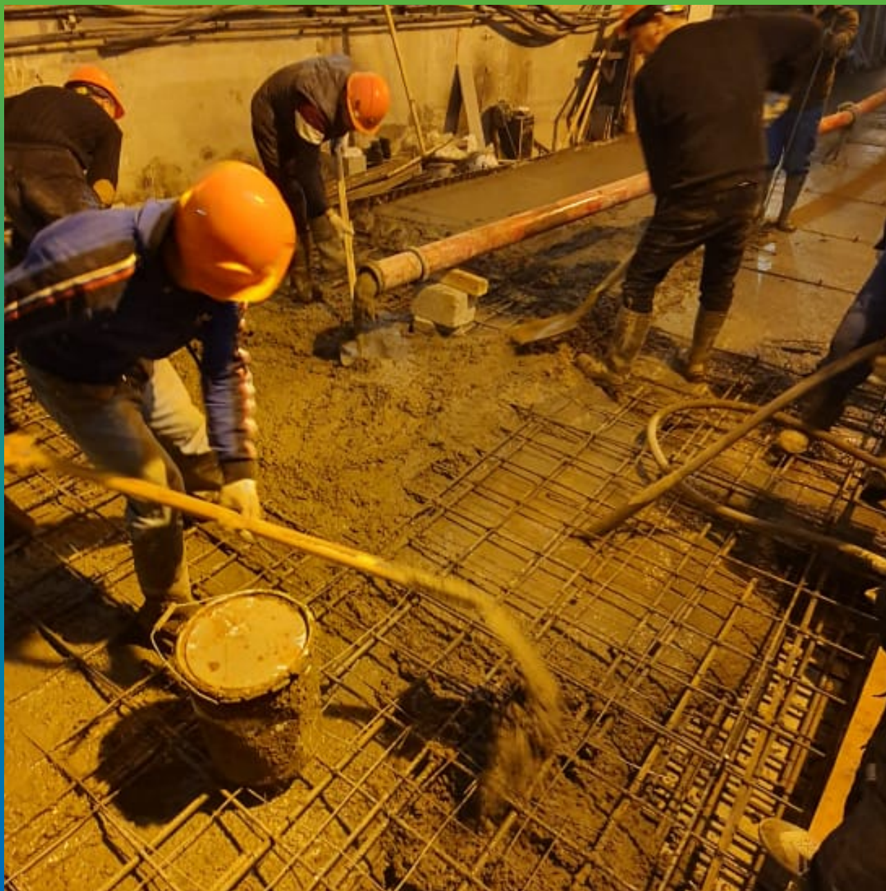
Приемка бетона на объекте
