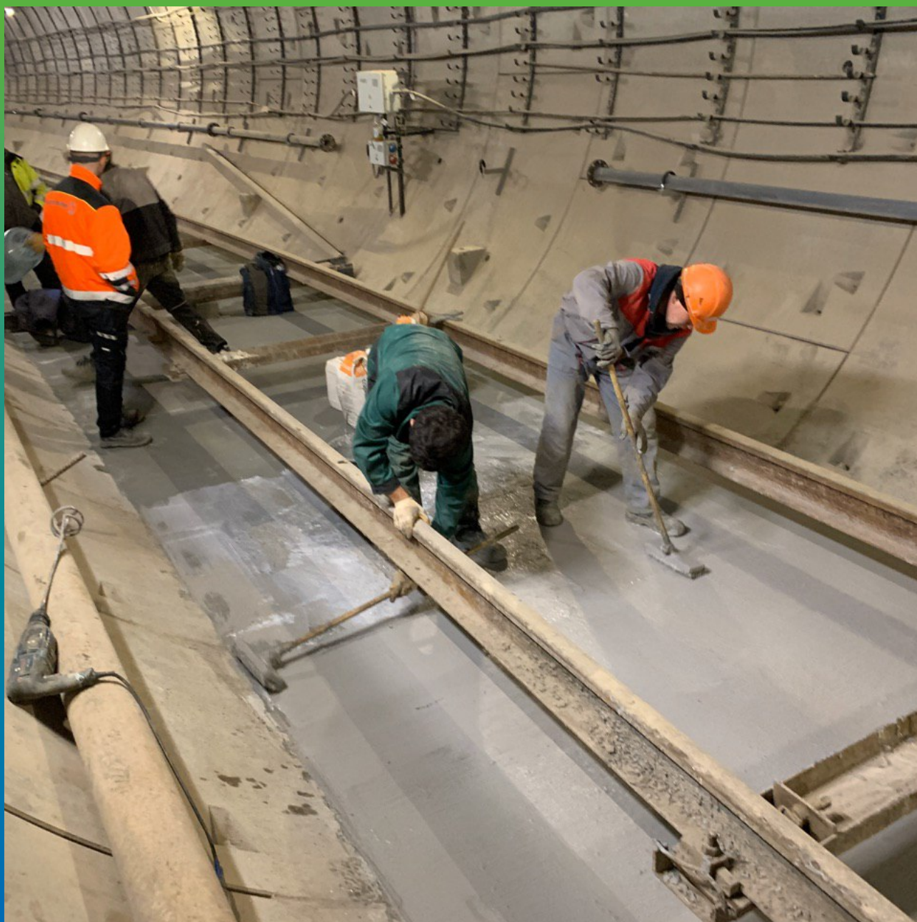
Нанесение второго слоя гидроизоляции Стармекс Сил Флекс на подготовленное основание
