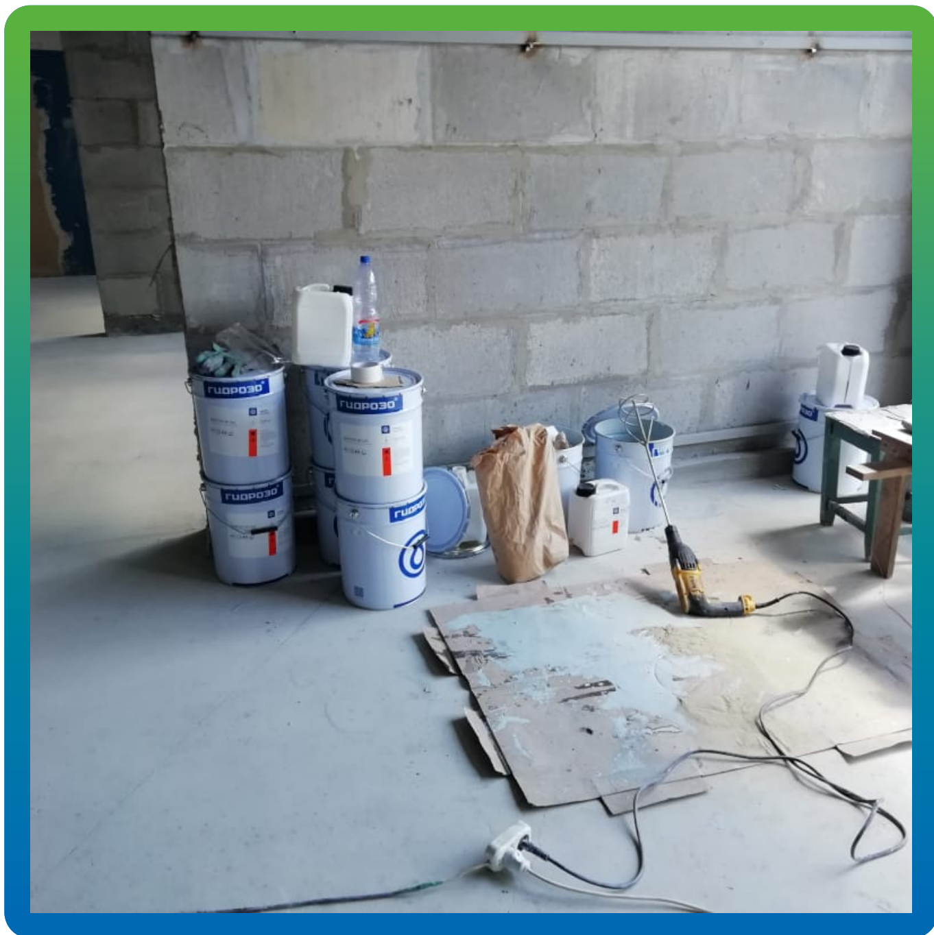
Материалы Гидрозо на объекте
