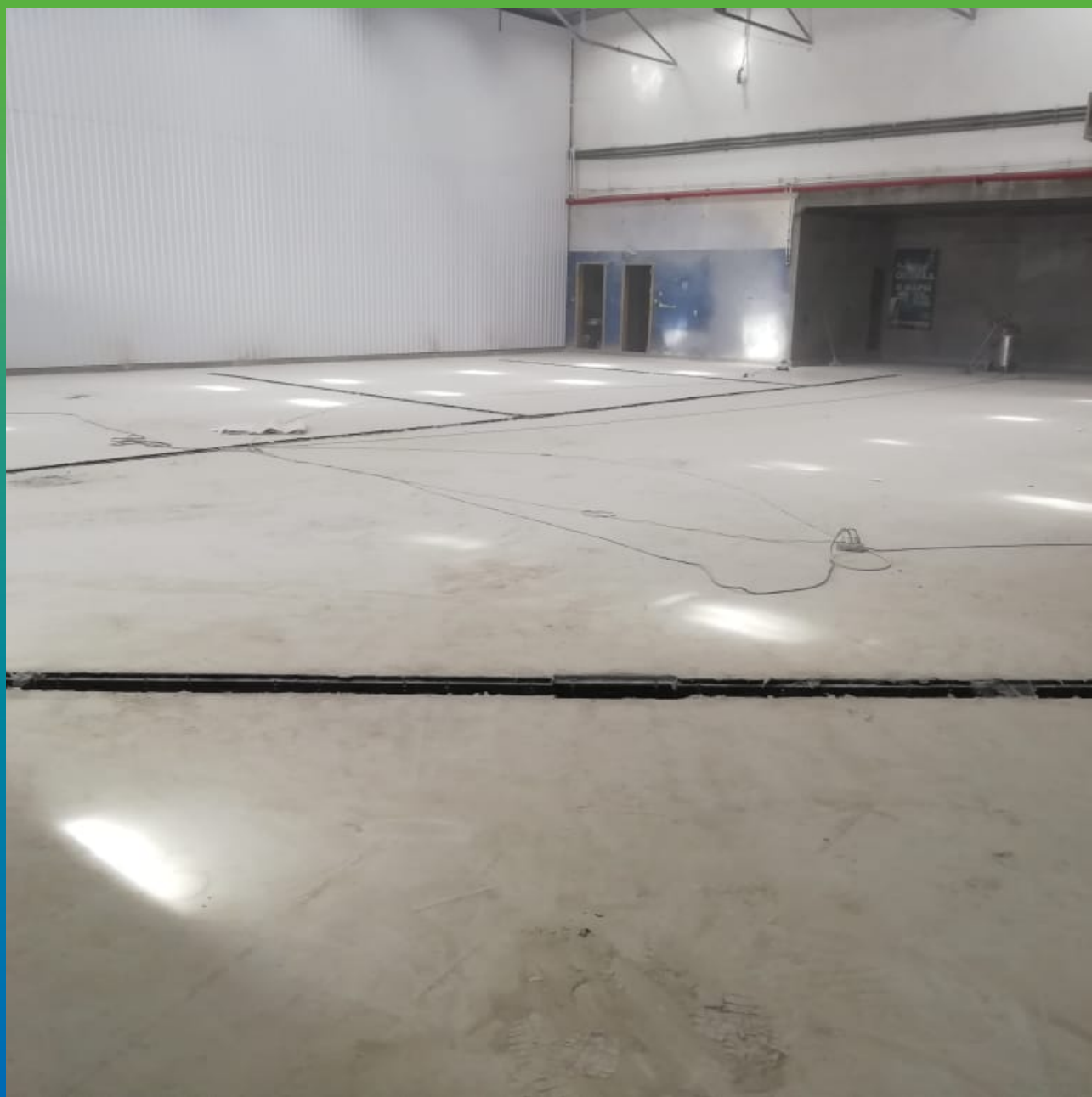
Основание перед нанесением полимерного покрытия
