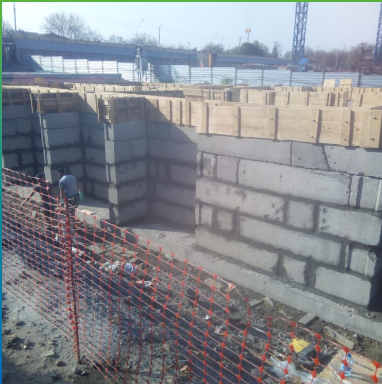
Чеканка швов рем. составом Стармекс РМЗ
