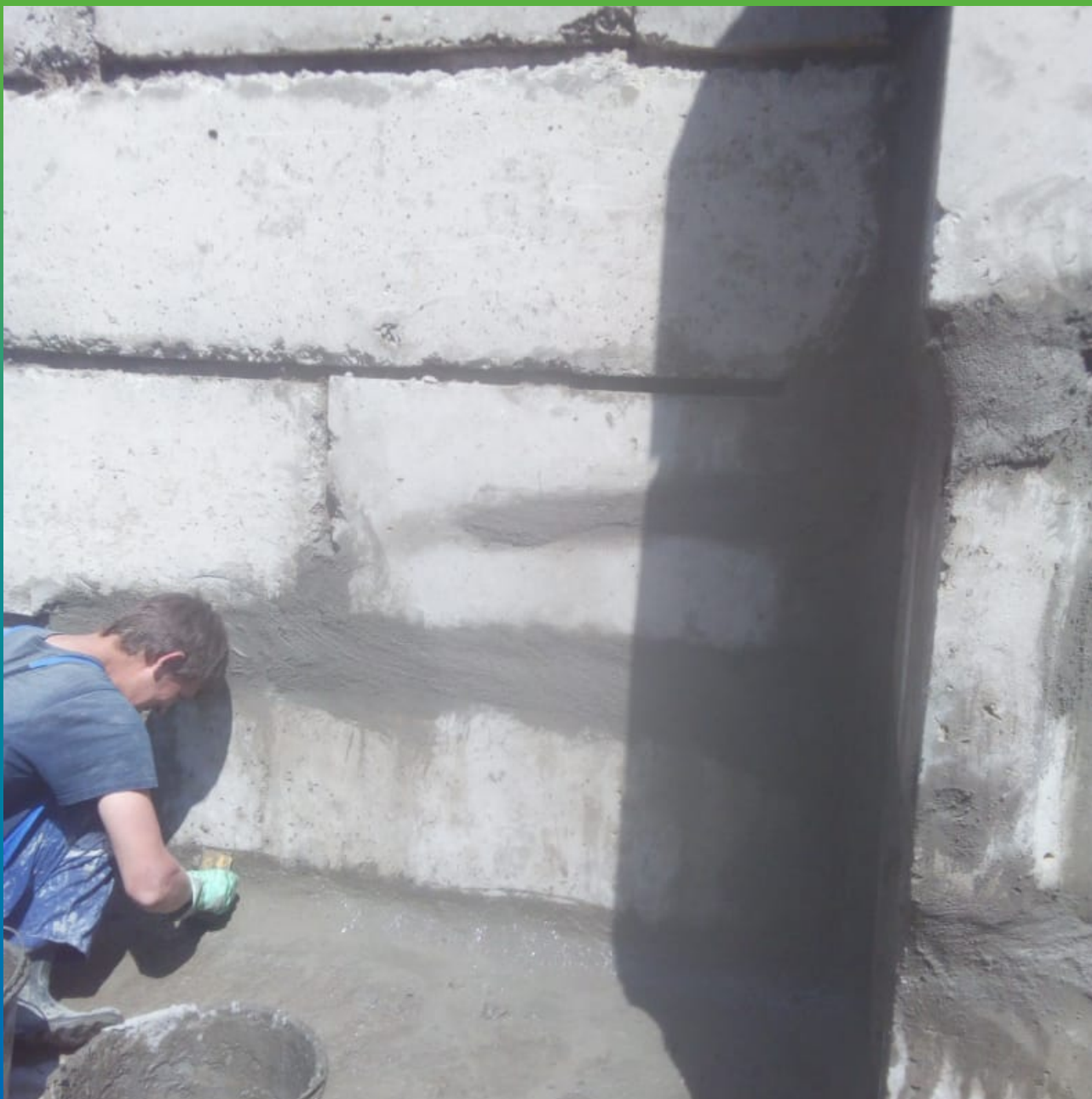
Создание галтели из ремонтного состава Стармекс РМЗ
