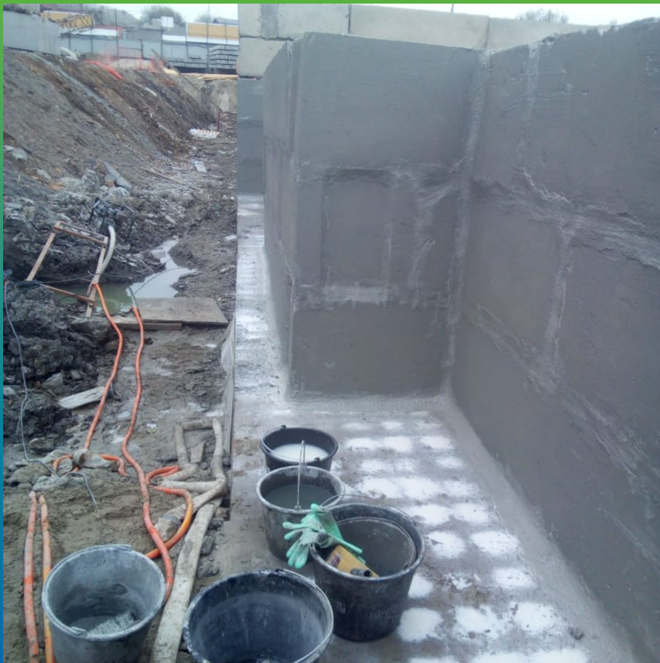
Стены, покрытые эластичной гидроизоляцией Стармекс Сил Флекс
