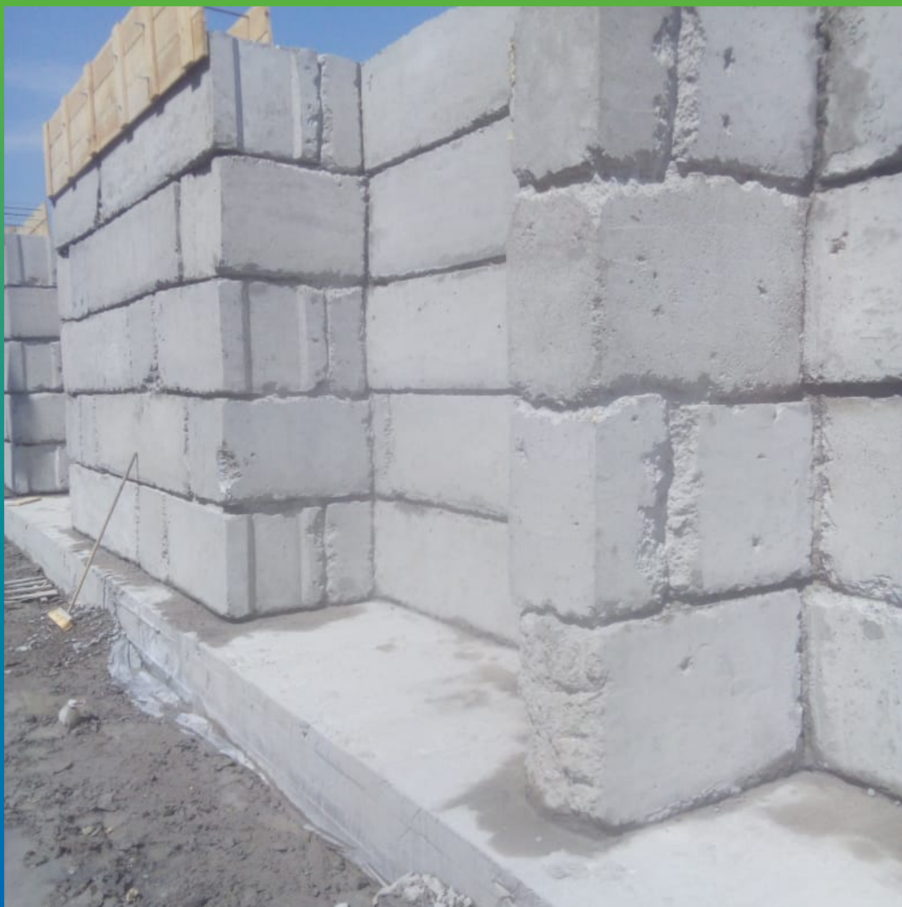
Расшивка блоков ФБС
