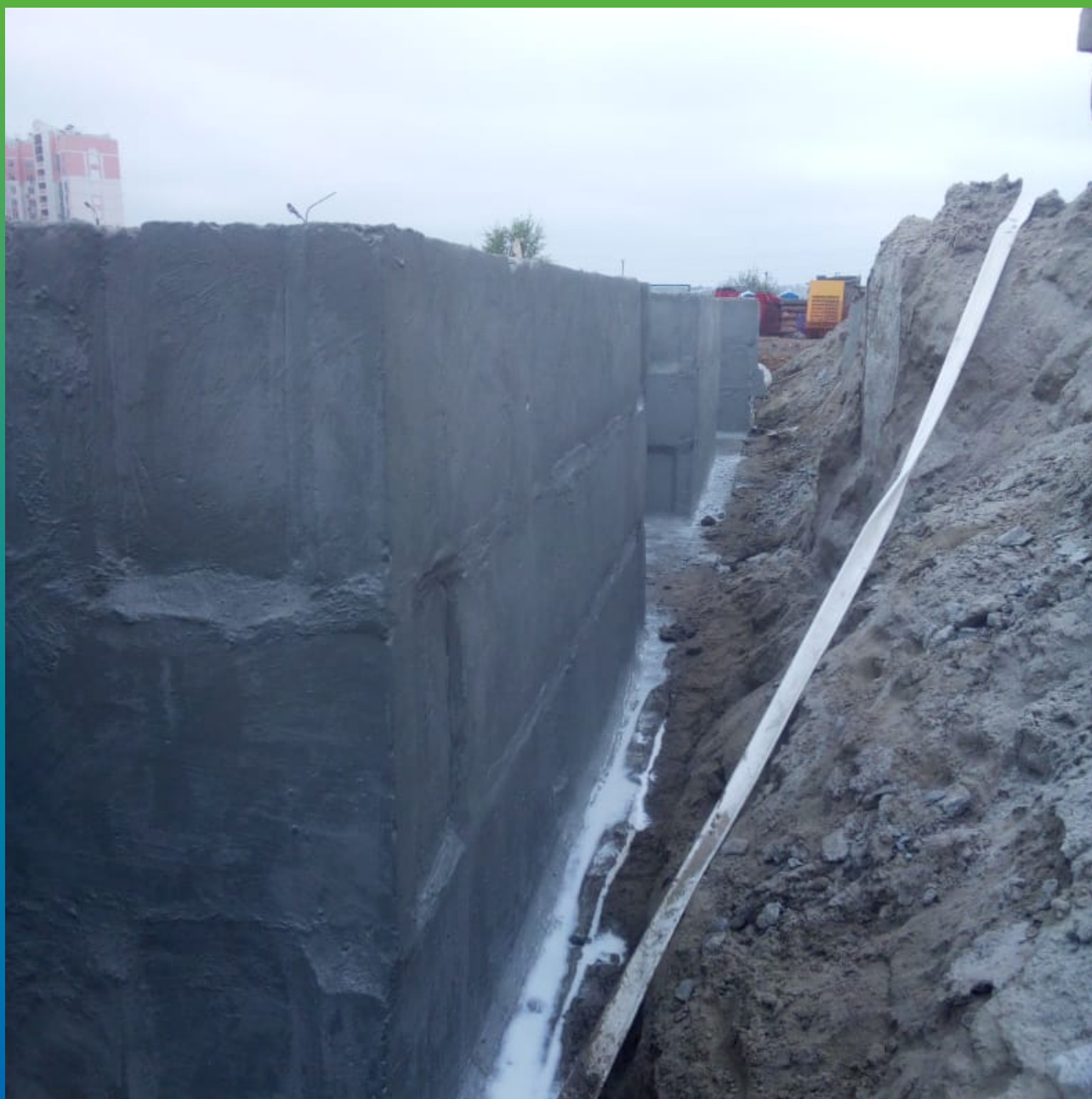
Финишный вид выполненной гидроизоляции
