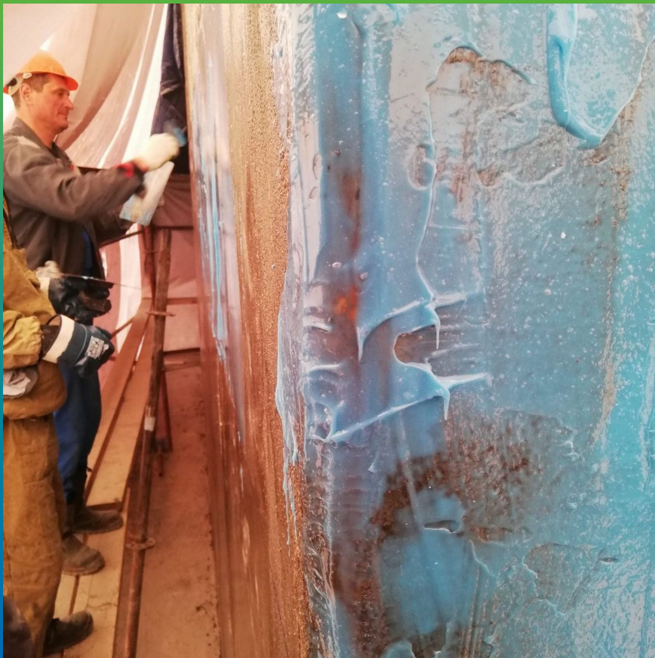
Грунтование поверхности наполненным клеем Манопокс 183
