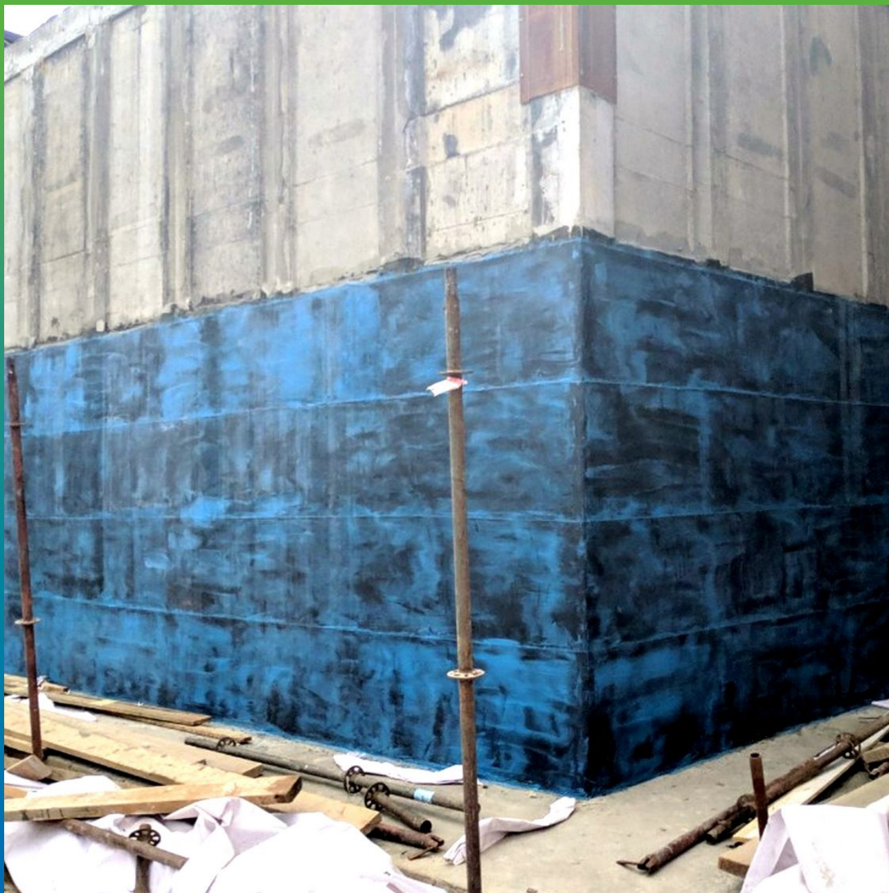
Резервуар после проведения работ по усилению
