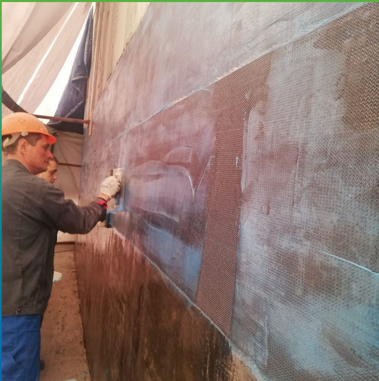
Финишное нанесение Манопокс 183
