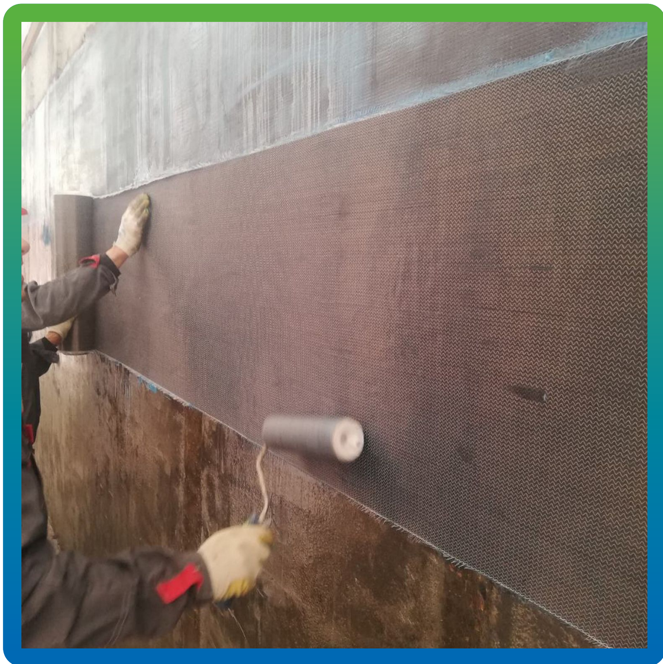
Монтаж Армошел KB200 на загрунтованную поверхность бака
